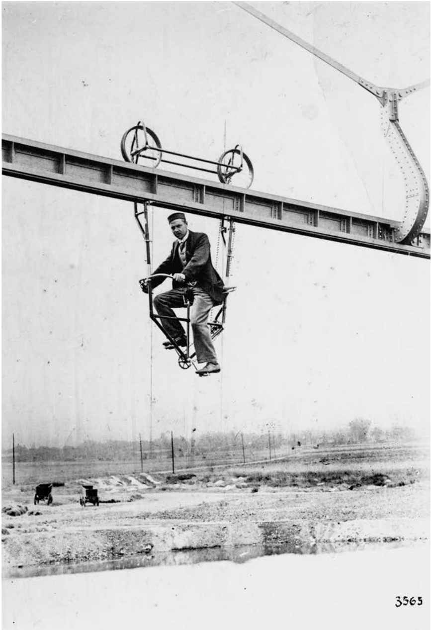
Abb. 3: Tret-Draisine auf der Deutzer Teststrecke, o. D. RWWA, 107-F2006
