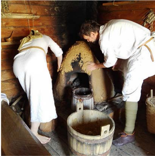
13 Bau eines Lehmkuesselofens im Innenraum des frühmittelalterlichen Blockhauses. Geschichtspark Bärnau-Tachov 2017.
