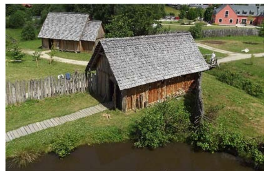
26 Das als Pfosten-Stabbau mit Schwellriegel konstruierte Herrenhaus. Geschichtspark Bärnau-Tachov 2017.
