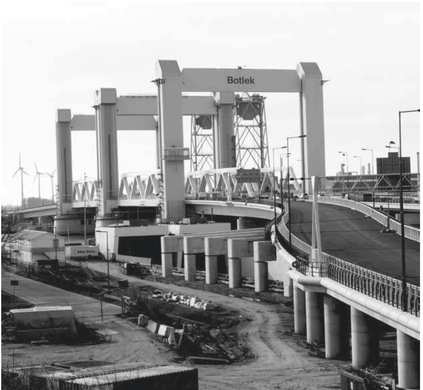
De Nieuwe Botlekbrug deel van de A15 Maasvlakte-Vaanplein
