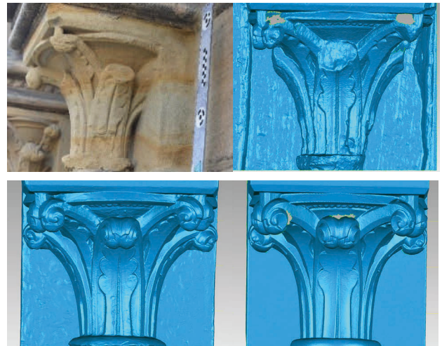
Abb. 3: (v. oben li.nach unten re.) Mittleres Kapitell in-situ, 3D-Scans nach der digitalen Aufarbeitung im Vergleich (Original, 3D-Druck aufmodelliert mit Plastilin, Steinmetz-Arbeit) [Hess 2020].
