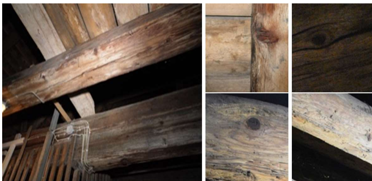
Abb. 4: Links: Originalbild aus der Dominikanerkirche; rechts: extrahierte Bilder (jeweils 640 x 640) für die weitere Ästigkeitserkennung.
