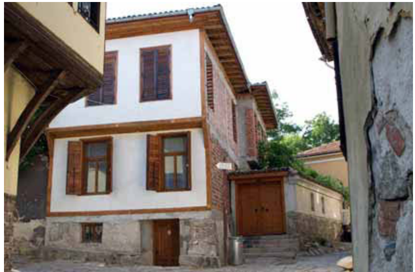
Abbildung 6: Haus fertig, fast ganz verputzt (2009)
