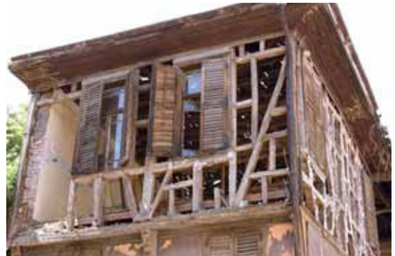
Abbildung 4: Vorbereitung zur Renovierung? (2006)
