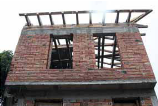
Abbildung 5: Neubau mit Beton und Ziegeln (2007)
