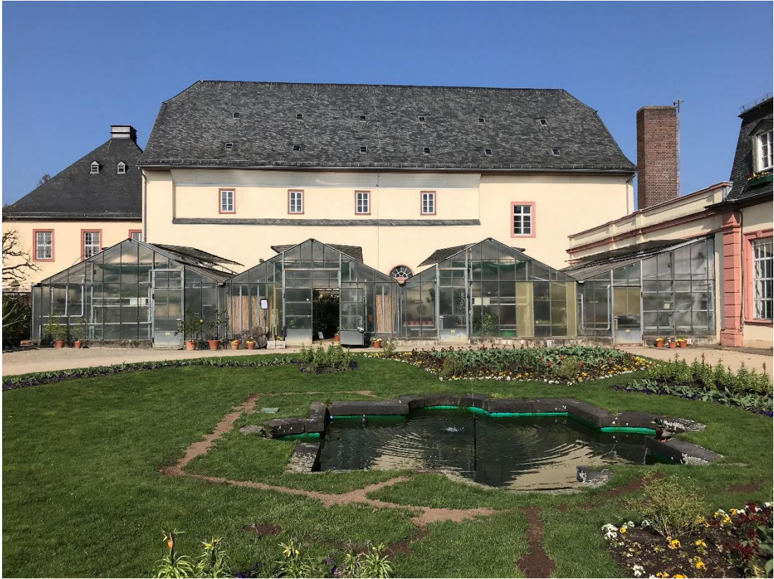
Abb. 198: Ostansicht des Marstalls. Bild: Nils Wetter
