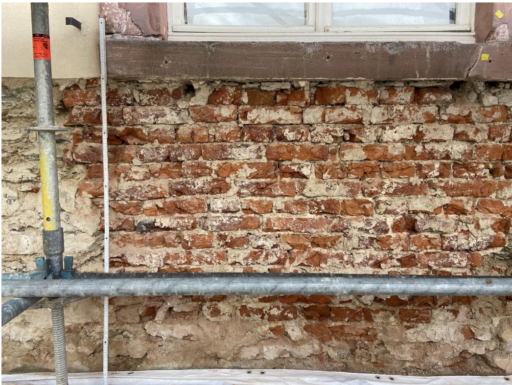
Abb.: 147: Ansicht des freigelegten Sockels des Königsflügels, Westfassade, deutlich sichtbar der mit Backsteinen zugesetzte Bereich unter dem Fenster. Bild: Nils Wetter
