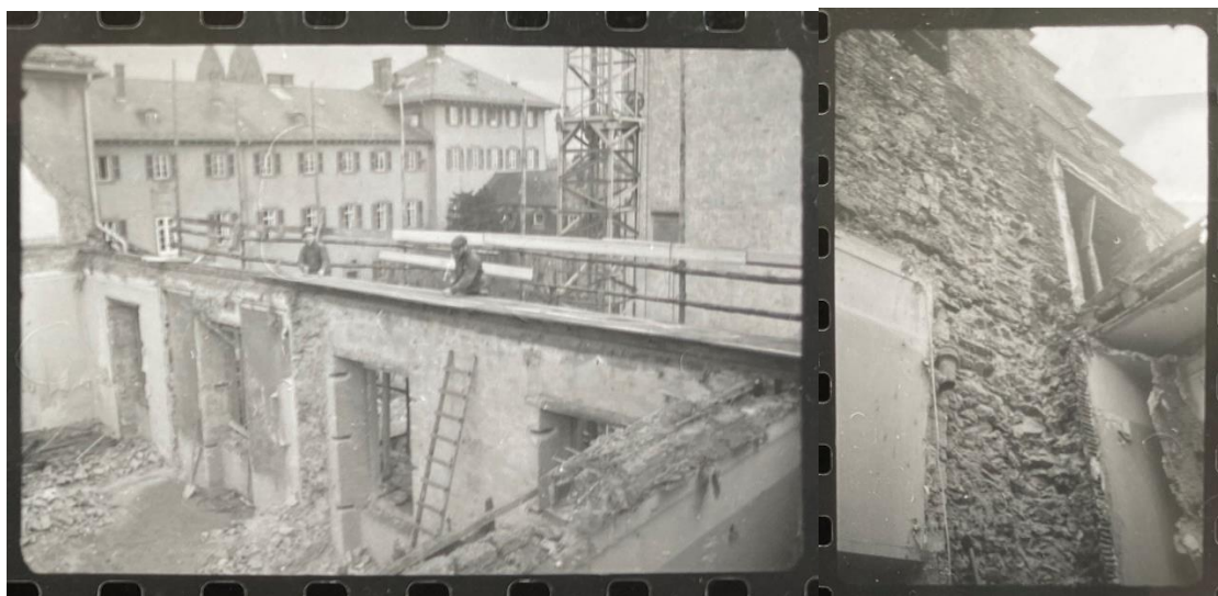
Abb. 217: Abbrucharbeiten am Hirschgangflügel, 1960-1967 Bild: Staatsbauamt Hessen, Inventar: 4394, Staatliche Schlösser und Gärten Hessen. Blick auf den Königsflügel und Blich auf die Giebelwand zum Bibliotheksbau.
