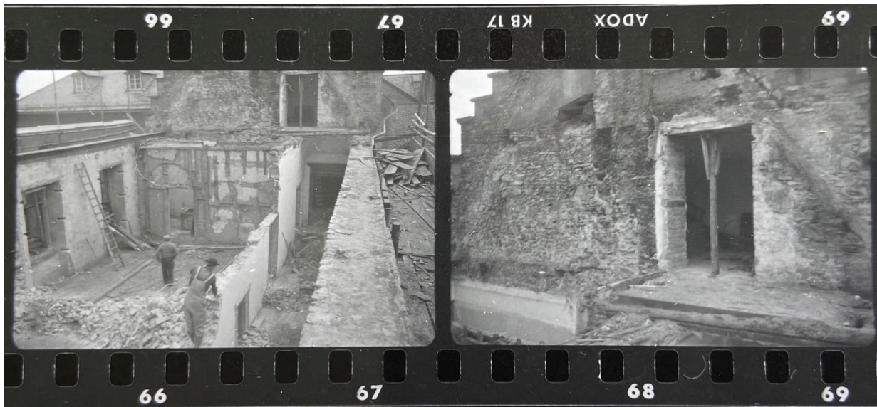
Abb. 213: Abbrucharbeiten am Hirschgangflügel, 1960-1967 Bild: Staatsbauamt Hessen, Inventar: 4394, Staatliche Schlösser und Gärten Hessen
