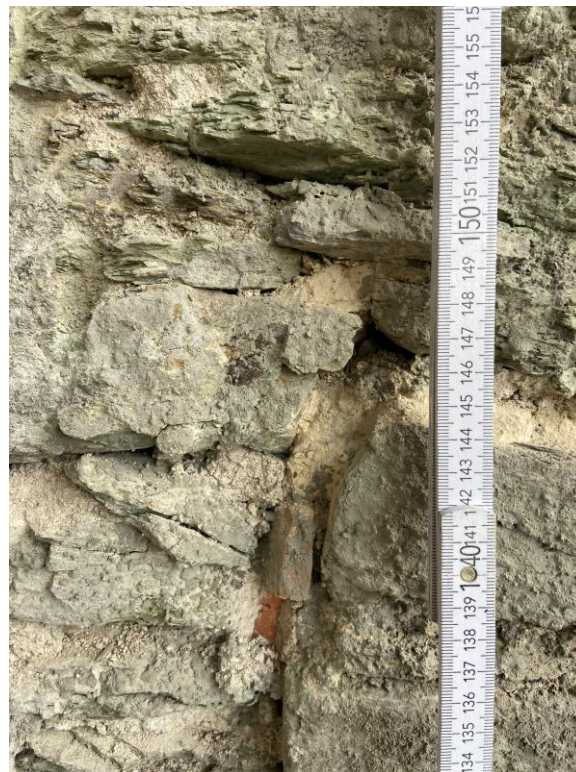
Abb.: 145: Detail Übergang Königsflügel / Wagenhalle. Im Befund deutlich sichtbar die unterschiedlichen Mörtel der beiden Bauteile. Der südliche Bereich (links) gröberer älter Mörtel, leicht entfestigt. Der jüngere, nördliche Bereich mit einem feineren, gelblicheren Mörtel (rechts). Foto: Nils Wetter
