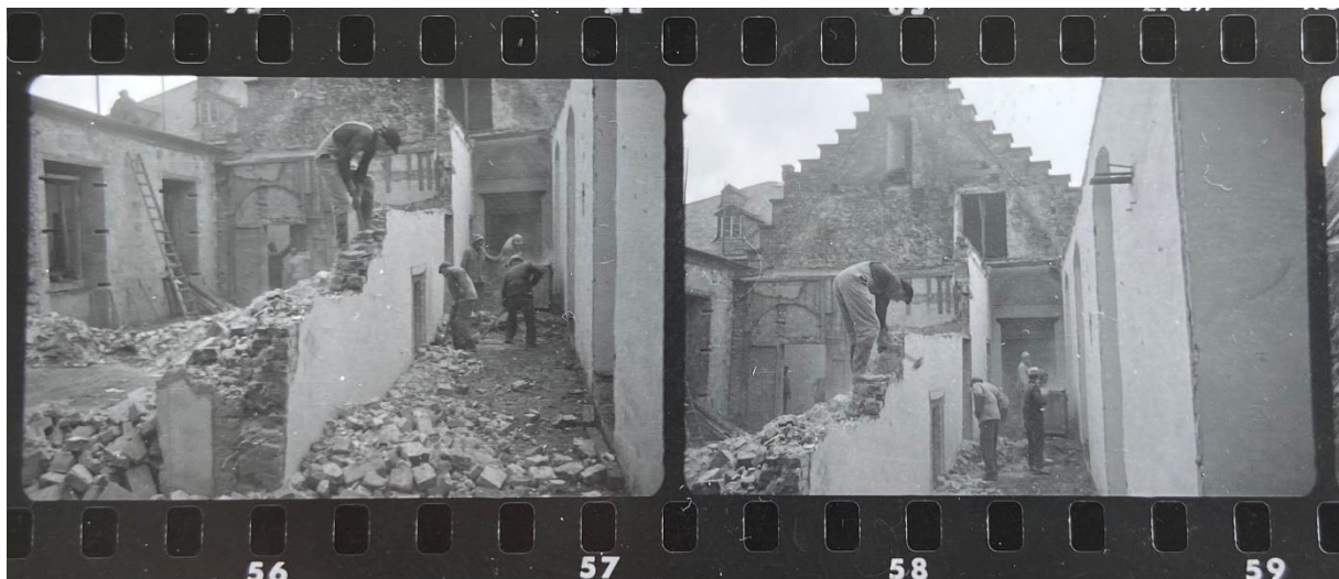
Abb. 212: Abbrucharbeiten am Hirschgangflügel, 1960-1967 Bild: Staatsbauamt Hessen, Inventar: 4394, Staatliche Schlösser und Gärten Hessen
