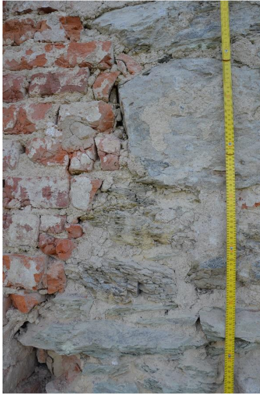
Abb. 236: Mit Backsteinen gemauerte Nordwestecke des Bibliotheksflügels (Detail). Bild: Nils Wetter
