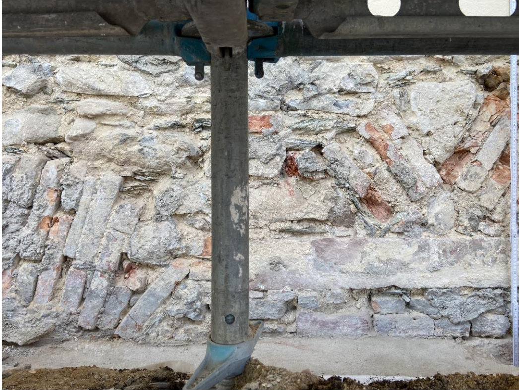
Abb.: 146: Detail Sockel Königsflügel. Im Befund deutlich sichtbar die zugesetzte Fensteröffnung. Foto: Nils Wetter
