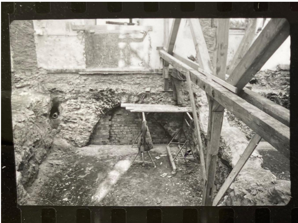
Abb. 220: Abbrucharbeiten am Hirschgangflügel, 1960-1967 Bild: Staatsbauamt Hessen, Inventar: 4394, Staatliche Schlösser und Gärten Hessen. Blick auf die neu ausgemauerte Bogenkonstruktion im Fundamentbereich.
