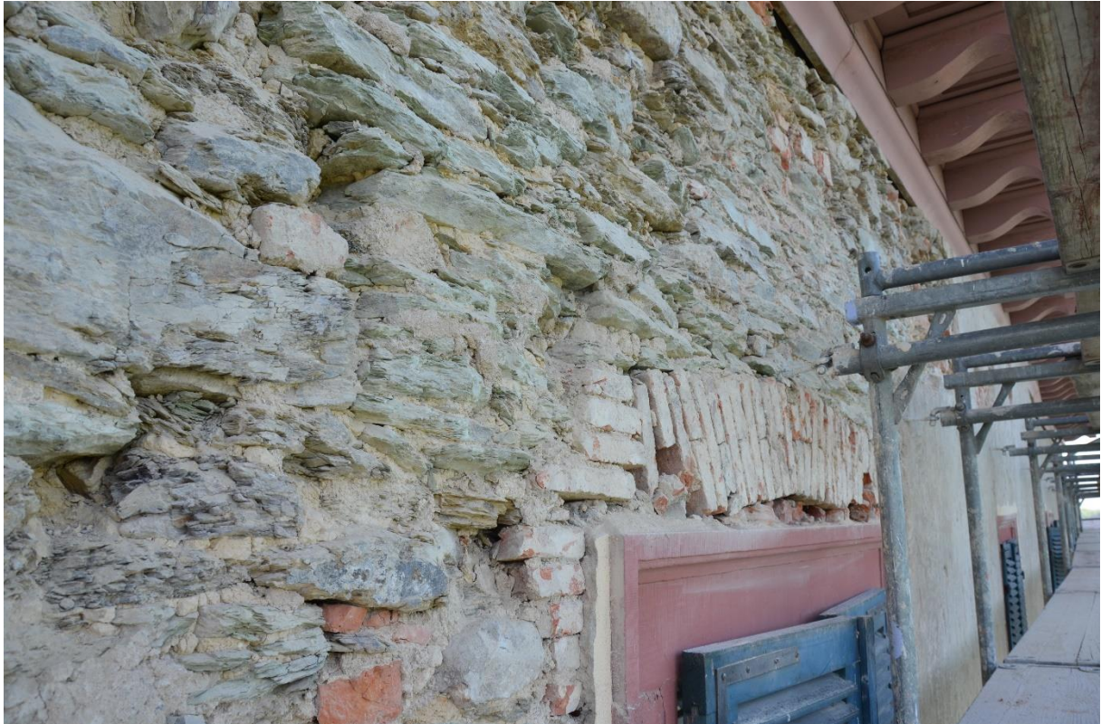
Abb. 237: Mit Backsteinen eingemauerte Fensterprofile des Bibliotheksflügels. Bild: Nils Wetter
