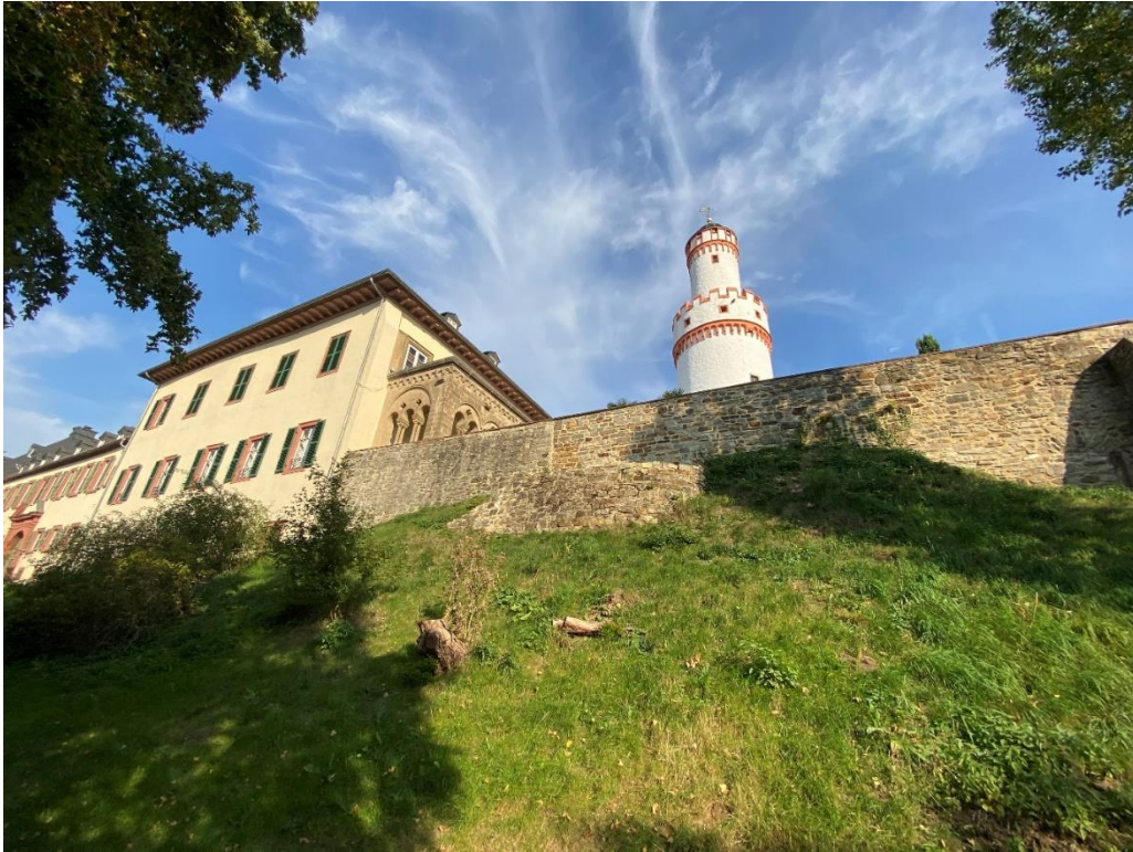
Abb. 222: Blick vom Garten auf die Mauer des Oberen Schlosshofs mit Weißen Turm und Romanischer Halle. In der Mitte ist das Stützmauerwerk der ehemaligen Rampe zu sehen, sowie ein Baunaht im Bereich der ehemaligen Öffnung. Bild: Nils Wetter
