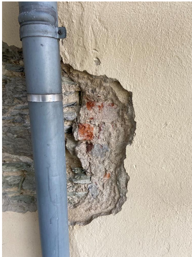
Abb. 239: Befundöffnung am Übergang Hirschgang- Königsflügel an der Nordfassade. Sichtbar die Baufuge zwischen den beiden Baukörpern. Bild: Nils Wetter
