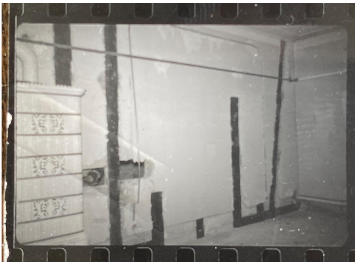
Abb. 218: Abbrucharbeiten am Hirschgangflügel, 1960-1967 Bild: Staatsbauamt Hessen, Inventar: 4394, Staatliche Schlösser und Gärten Hessen. Blick in Raum 105 oder 124 im 1.OG.
