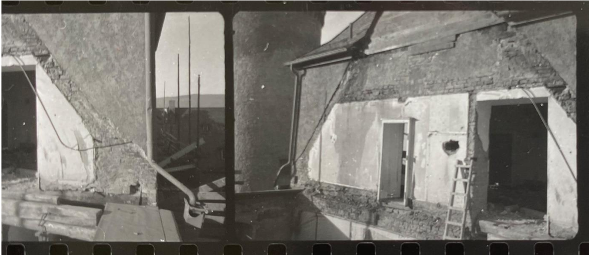
Abb. 215: Abbrucharbeiten am Hirschgangflügel, 1960-1967 Bild: Staatsbauamt Hessen, Inventar: 4394, Staatliche Schlösser und Gärten Hessen. Blick von Osten auf den Turm über dem Tor, der in Backsteinmauerwerk ausgeführt ist.
