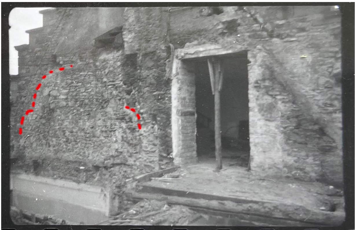
Abb. 214: Abbrucharbeiten am Hirschgangflügel, 1960-1967 Bild: Staatsbauamt Hessen, Inventar: 4394, Staatliche Schlösser und Gärten Hessen. Rot eingezeichneter Bereich könnte ein ehemaliger Stufengiebel sein.
