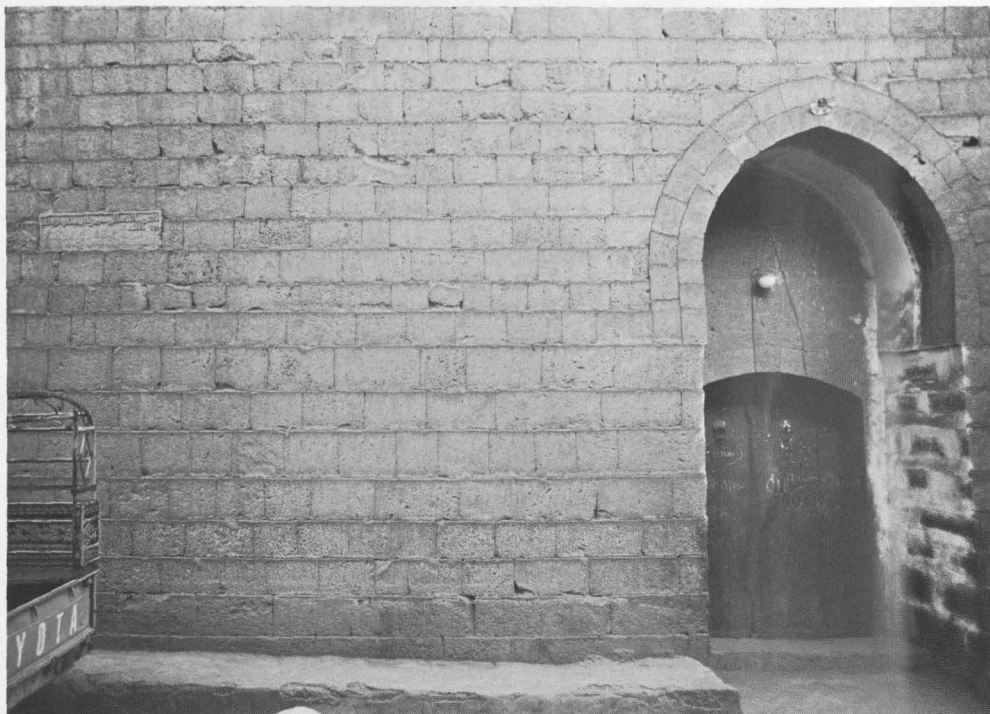
a. Şan'ā', Freitagsmoschee, Ostfassade, südlicher Eingang
