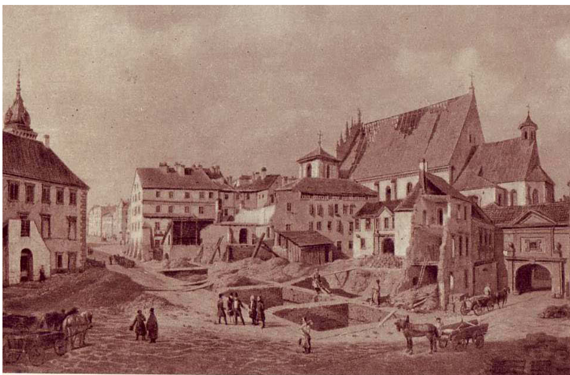
Abb. 527. Abriss des Hauses des Dekans in 1838. Bild Marcin Zaleski. Aus der Sammlung Muzeum Historyczne m. st. Warszawy (Das Historische Museum der Hauptstadt Warschau), MHW 17894.
