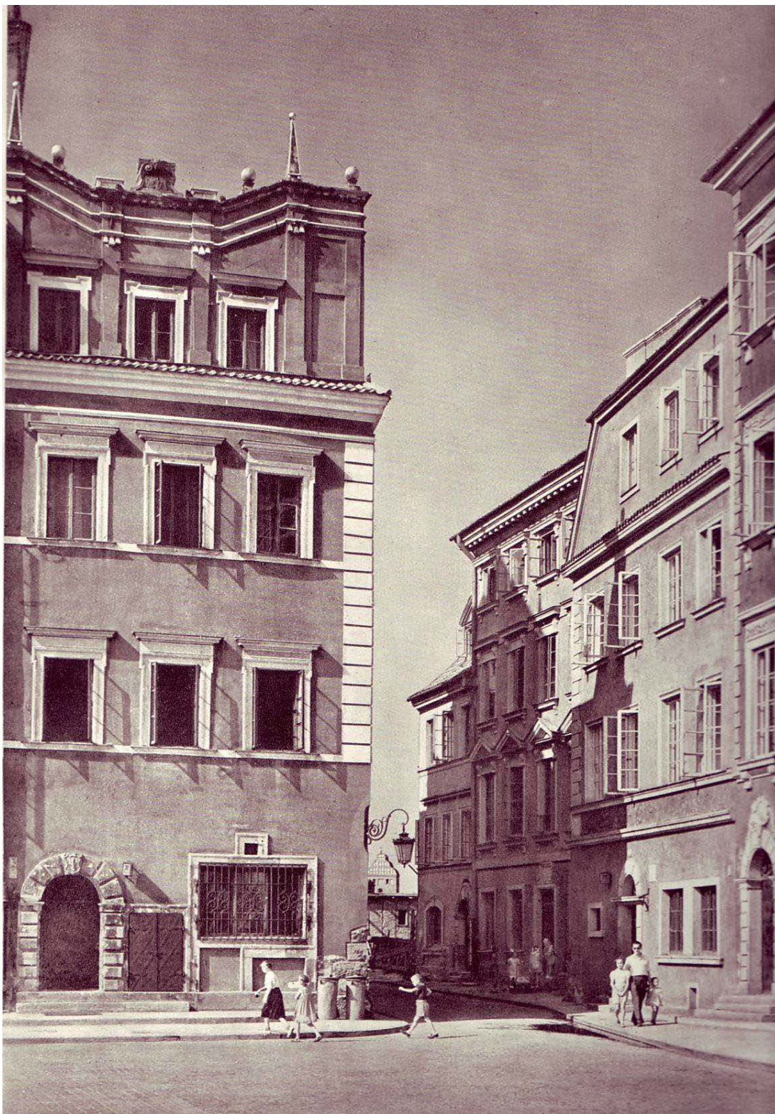
Abb. 360. Haus Nr. 28 in 1956. Die ursprünglich nach dem Wiederaufbau auf der Attika aufgestellte Plastiken wurden abgenommen und erst in 70-er Jahre wieder aufgestellt. Fotograf nicht benannt. Nach: Biegański Piotr / Zachwatowicz Jan, Die Altstadt in Warschau , Warschau 1956, Abb. 43.
