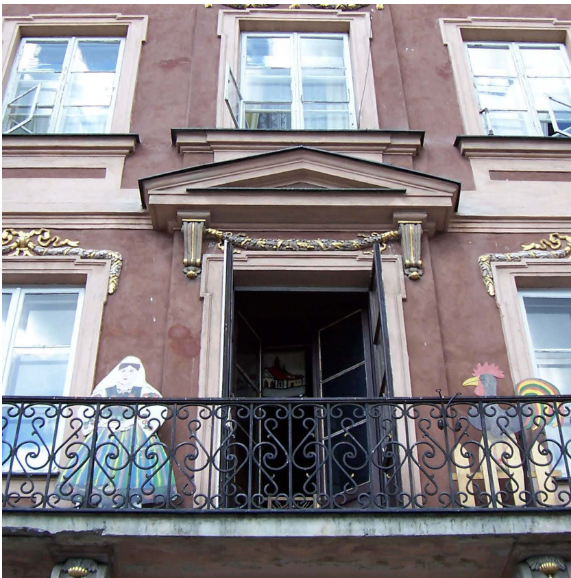
Abb. 306. Rynek Nr. 10. Balkontür im 1. Obergeschoss. Foto Verfasserin, 2008.
