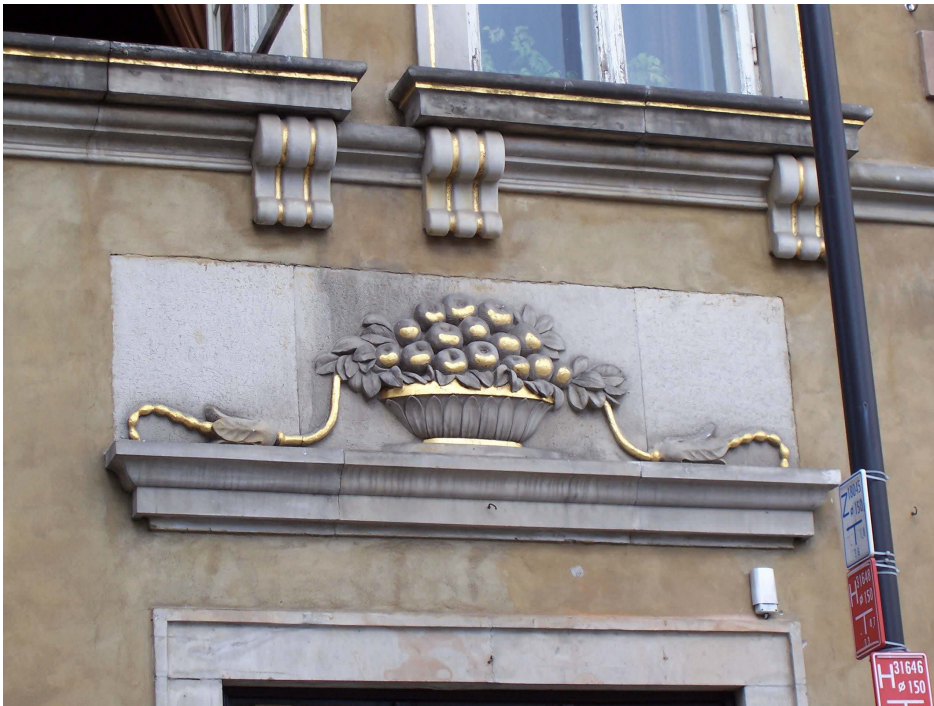
Abb. 341. Rynek Nr. 24. Fenesterverzierung. Foto Verfasserin, 2005.
