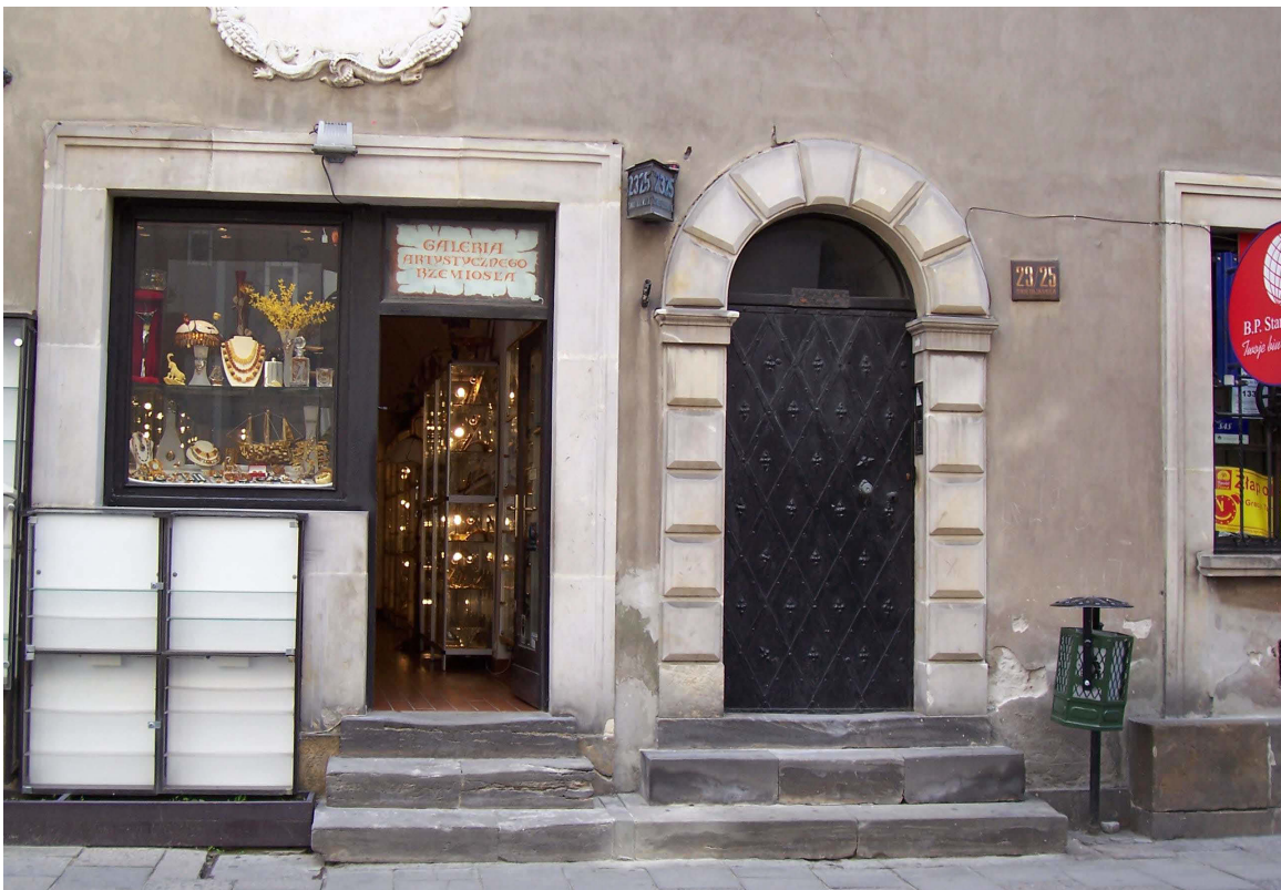
Abb. 498. Świętojańska-Straße Nr. 23. Fassade des Erdgeschosses. Links sichtbar der Eingang zum Laden Świętojańska Nr. 23, rechts - Eingang zum Wohnhaus (Adresse Swietojojanska-Straße Nr. 25). Foto Verfasserin, 2007.
