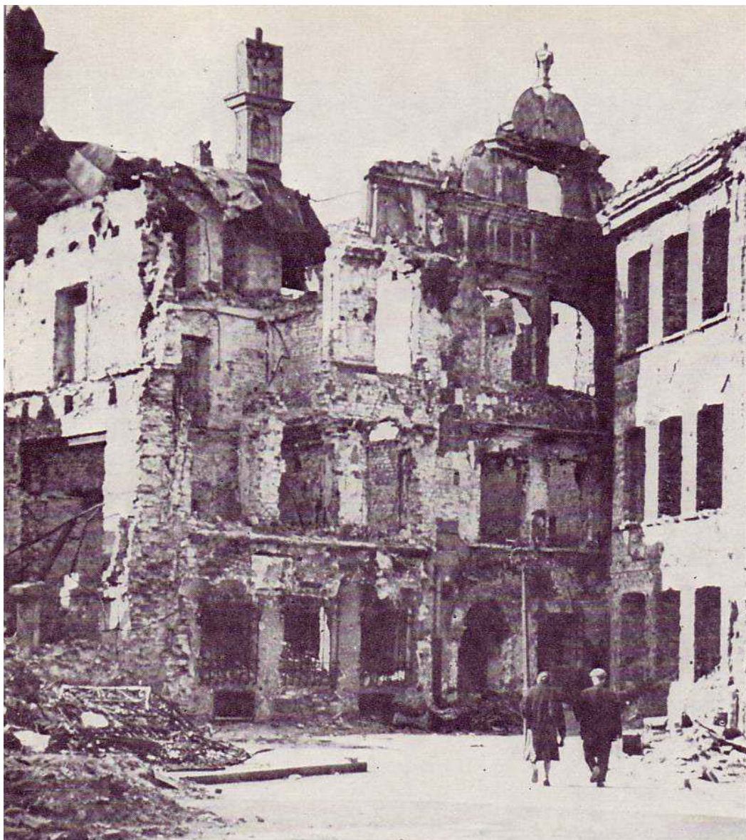
Abb. 536. Kanonia-Straße. Häuser Nr. 26, Nr. 24, Nr. 22, Nr. 18 und Nr. 16. Foto Leonard Jabrzemski*, 1946.
