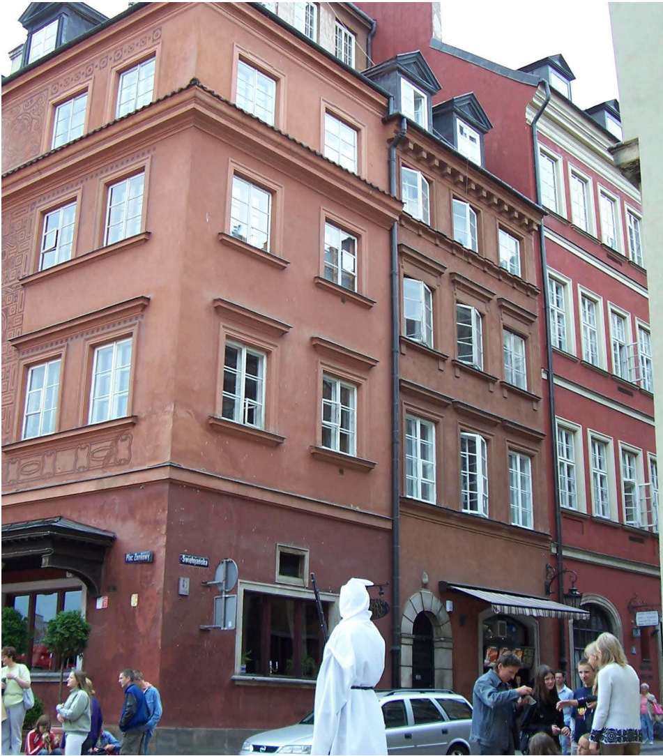
Abb. 455. Blick vom Schlossplatz in die Świętojańska-Straße. Von links Häuser: Ecke Zamkowy-Platz/Swiętojańska-Straße, Świętojańska-Straße Nr. 3 und Nr. 5 (Fragment). Foto Verfasserin, 2007.
