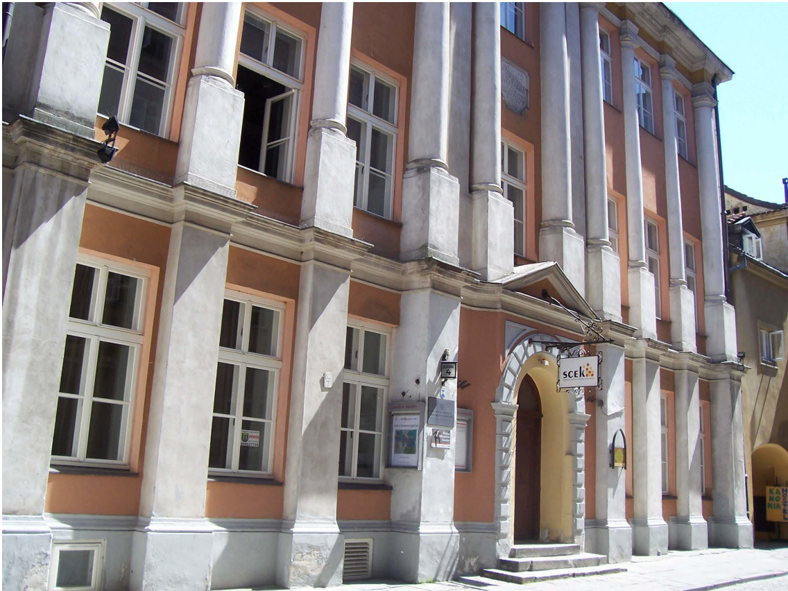
Abb. 573. Haus Jezuicka-Straße Nr. 4. Foto Verfasserin, 2012.
