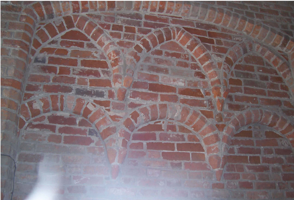
Abb. 413. Rynek Nr. 40. Gotische Nische im Flur. Foto Verfasserin, 2012.
