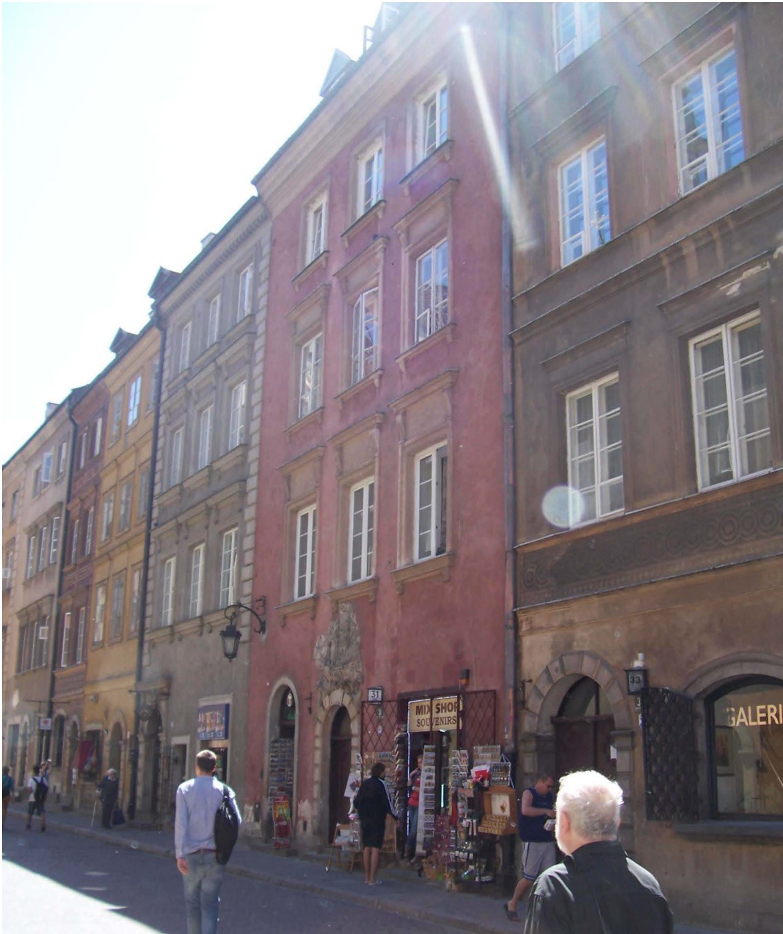
Abb. 506. Świętojańska-Straße Nr. 31. Eingang zum Laden, Hauptportal. Foto Verfasserin, 2012.
