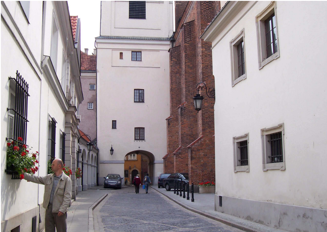
Abb. 528. Dziekania-Straße gesehen von der Kanonia-Straße. Rechts im Bild Fragment der Wand der Kathedrale, links ein Teil der Seitenfassade des Dekanshauses, hinten in Richtung der Świętojańska-Straße - eine Arkade die an der Stelle des Vikarhauses errichtet wurde. Foto Verfasserin, 2006.
