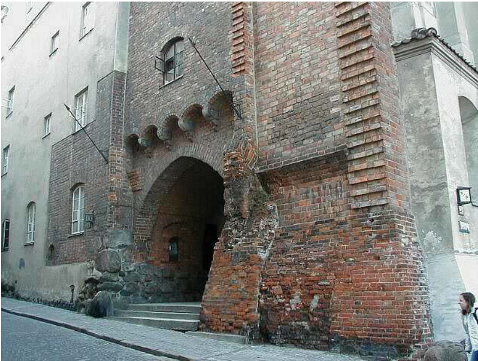
Abb. 586. Fragment der Fassade von der Celna-Straße mit dem Ausgang der Gasse „An der Mauer“. Foto Verfasserin, 2008.
