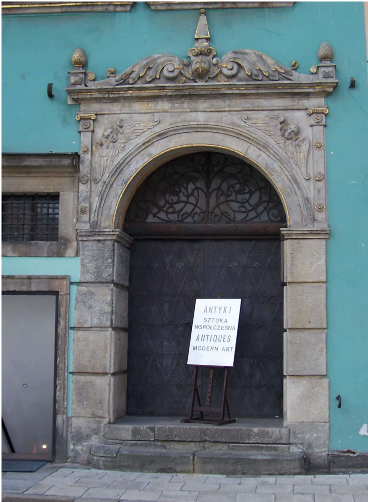
Abb. 383. Rynek Nr. 32. Portal vom 1633. Foto Verfasserin, 2008.
