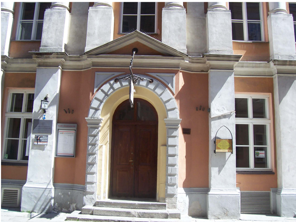
Abb. 574. Jezuicka-Straße Nr. 4. Portal. Foto Verfasserin, 2012.
