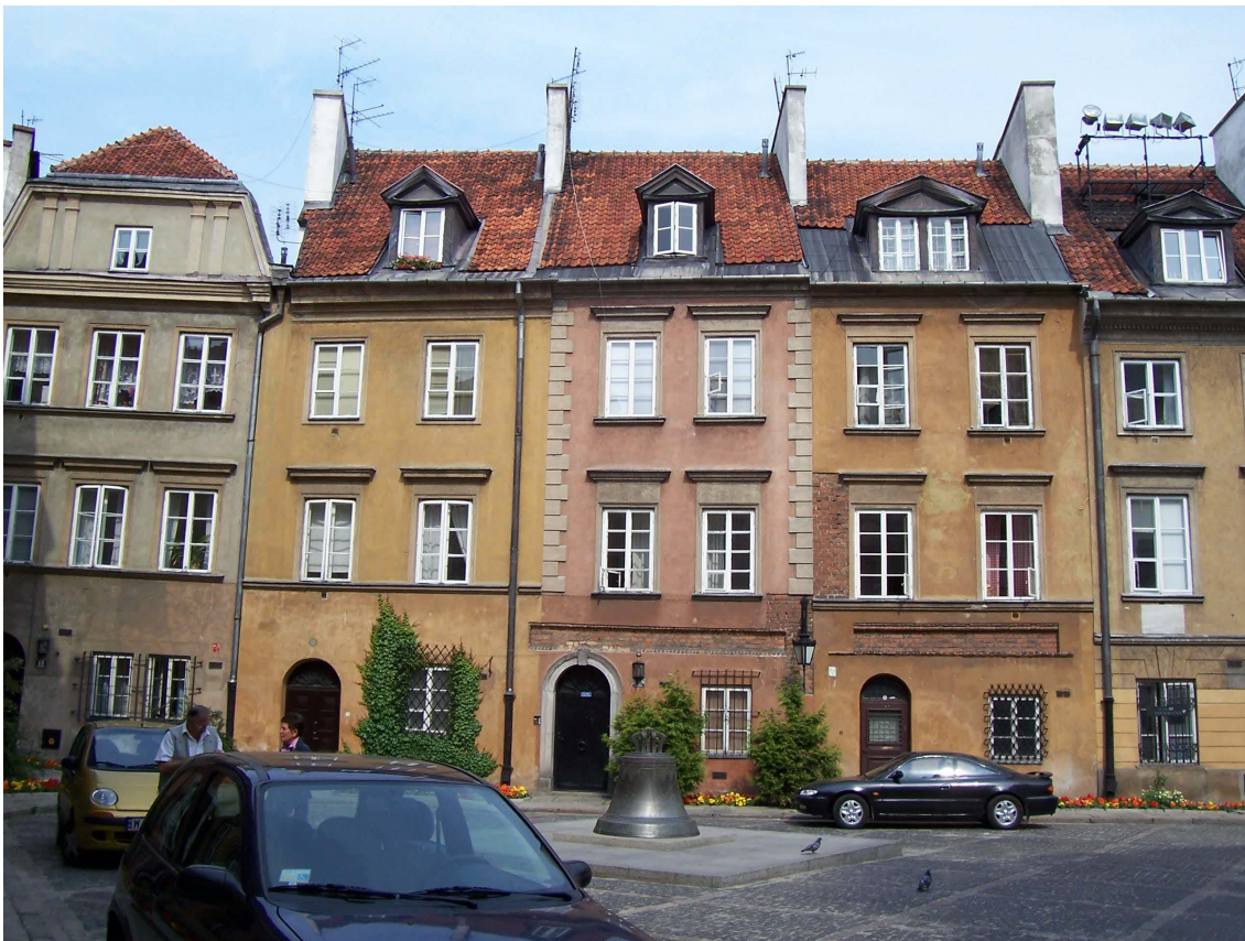
Abb. 543. Kanonia-Straße. Von links Nr. 16, Nr. 14, Nr. 12, Nr. 10 und Nr. 8. Foto Verfasserin, 2006.
