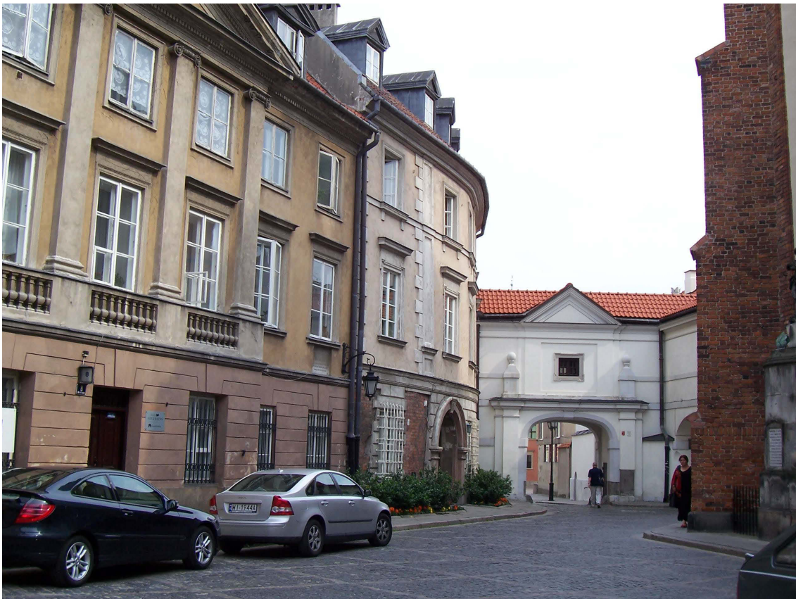
Abb. 541. Kanonia-Straße Nr. 8 und Nr. 6. Übergang zu der Gasse Ku Kanoni. Foto Verfasserin, 2006.
