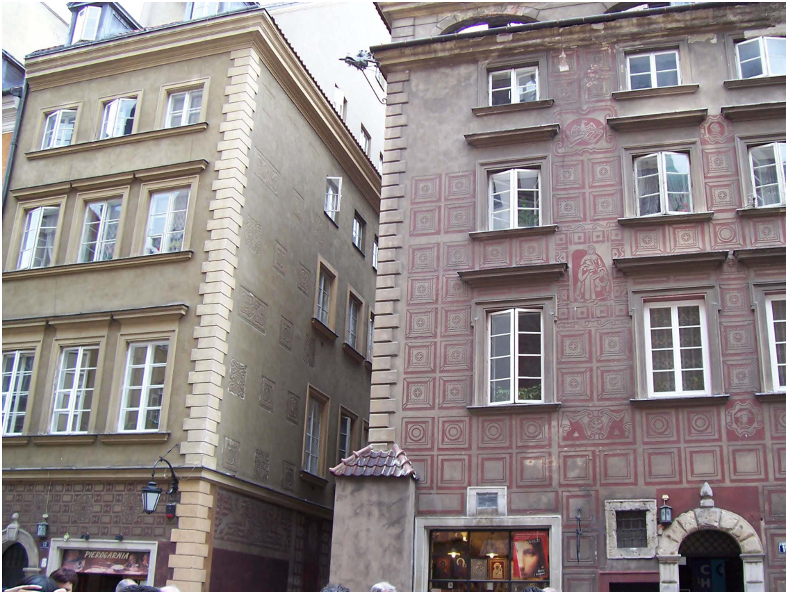
Abb. 464. Świętojańska-Straße Nr. 13 und Nr. 15 Foto Verfasserin, 2007.
