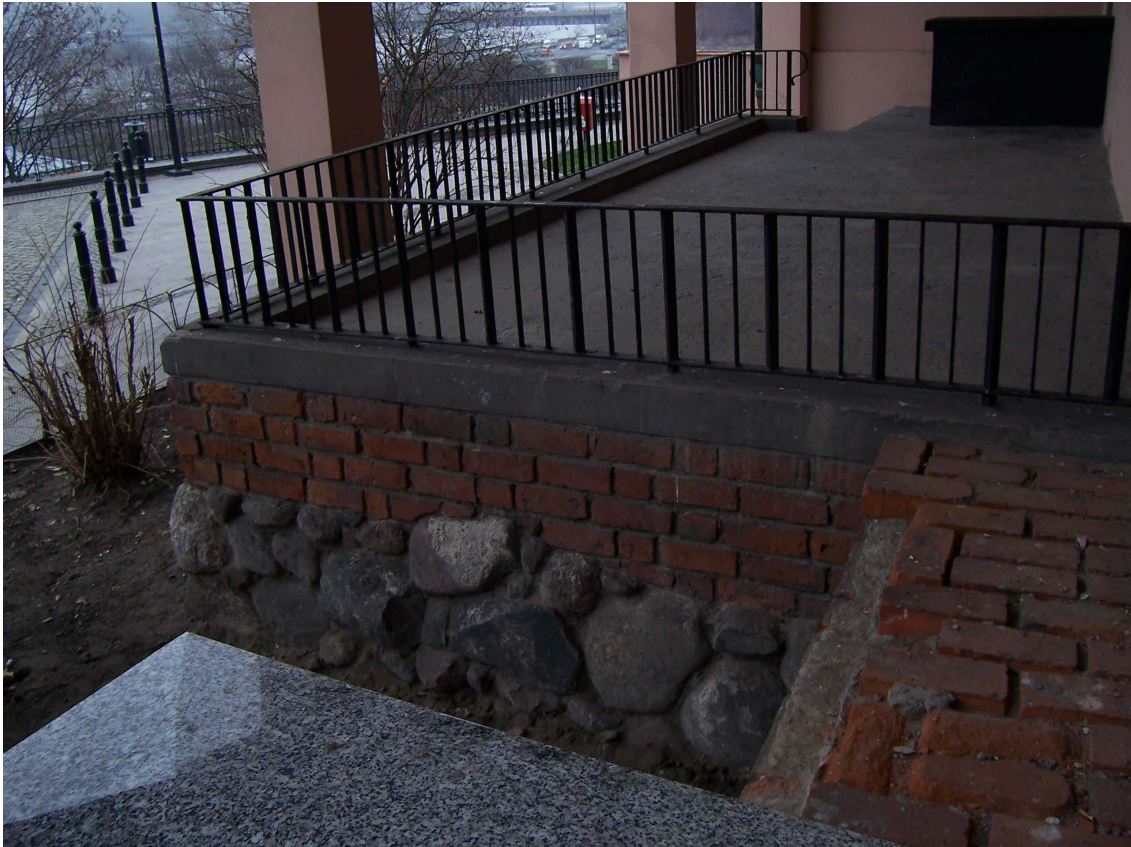
Abb. 553. Freigelegte Reste der Wehrmauer in der Hinterfassade des Hauses Kanonia-Straße Nr. 18.
