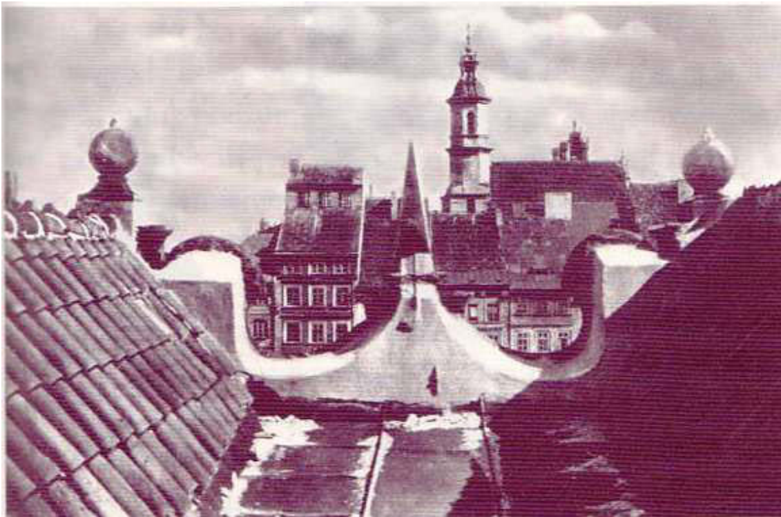
Abb. 375. Ansicht aus dem Dach des Baryczka-Hauses. Foto M. Szczawik*, nicht datiert (sicher nach 1928 und vor 1939). Nach: Wierzbicka Bożena, Kamienica Baryczków (Das Baryczkas-Haus) , Warszawa 1999, Abb. 28, S. 57.
