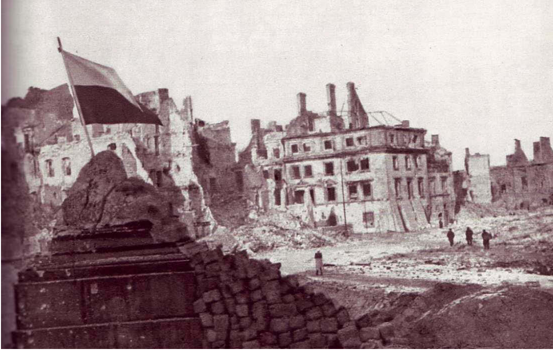
Abb. 512. Ruinen des Schlossplatzes in 1945. Im Vordergrund zerstörte Sockel der Sigismundsäule, im Hintergrund das Haus Świętojańska-Straße Nr. 2. Fotograf unbekannt. Foto vom 17 Januar 1945. KAW Neg. Ł55/16.
