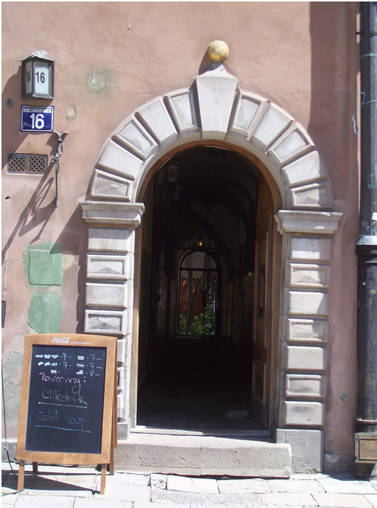
Abb. 316. Rynek Nr. 16. Portal. Foto Verfasserin, 2012.
