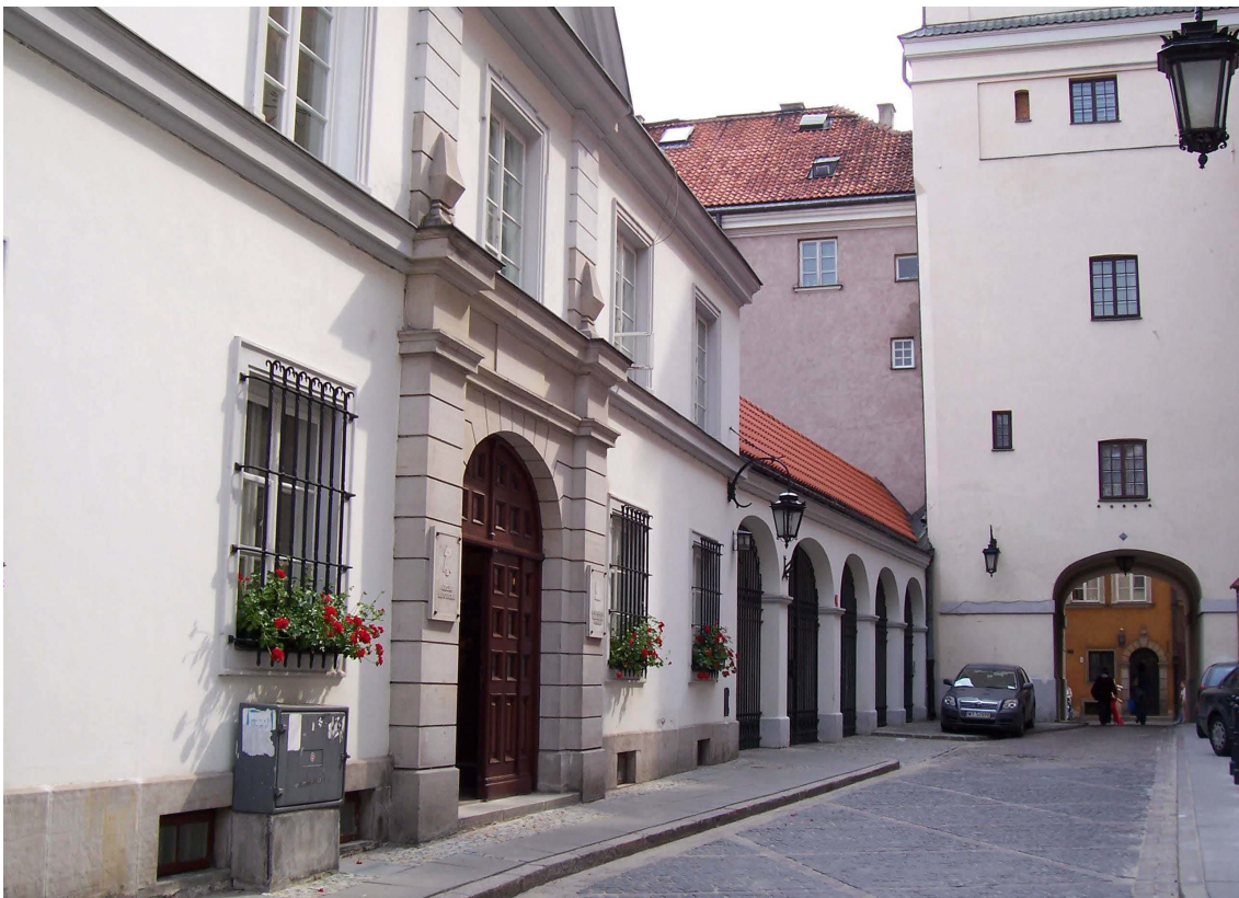
Abb. 529. Dziekania-Straße. Links Front des Dekanshauses. Foto Verfasserin, 2006.
