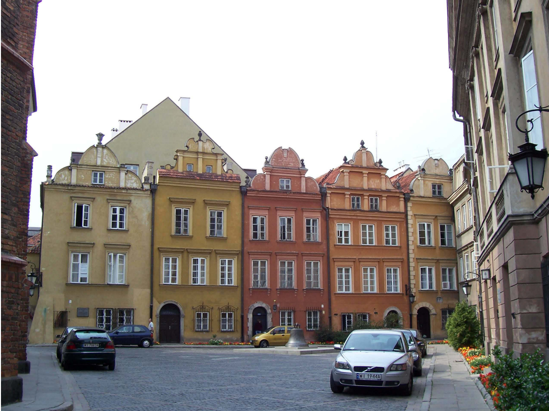
Abb. 538. Kanonia Von links Häuser Nr. 28, Nr. 26, Nr. 24, Nr. 22 und Nr. 20. Foto Verfasserin, 2006.
