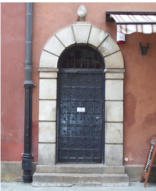
Abb. 456. Świętojańska-Straße Nr. 3. Portal. Foto Verfasserin, 2007.
