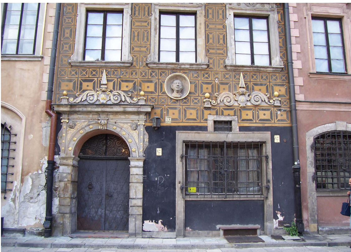
Abb. 398. Rynek Nr. 36. Fassade des Erdgeschosses. Foto Verfasserin, 2005.
