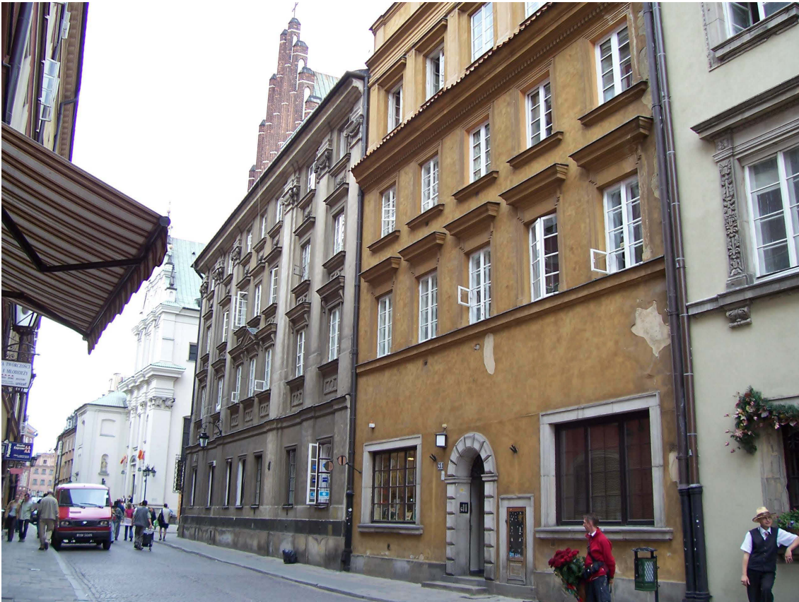
Abb.522. Świętojańska-Straße Nr. 6 und Nr. 4. Foto Verfasserin, 2007.
