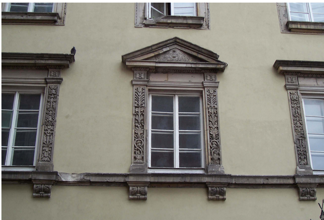
Abb. 515. Świętojańska-Straße Nr. 2. Fenster der Fassade von der Seite der Świętojańska-Straße. Foto Verfasserin, 2007.
