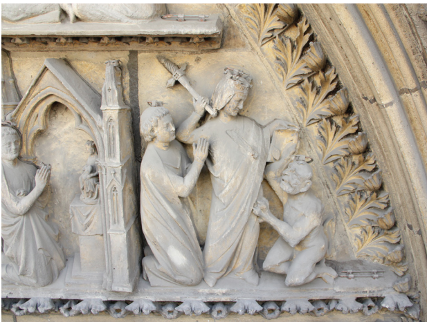
65 PARIS, NOTRE-DAME, NÖRDLICHES QUERHAUSPORTAL, TYMPANON NORD, DETAIL AUS DER THEOPHILUSGESCHICHTE MIT AUSGEBESSERTEN FEHLSTELLEN LINKS UND RECHTS UNTEN, FOTO 2016
