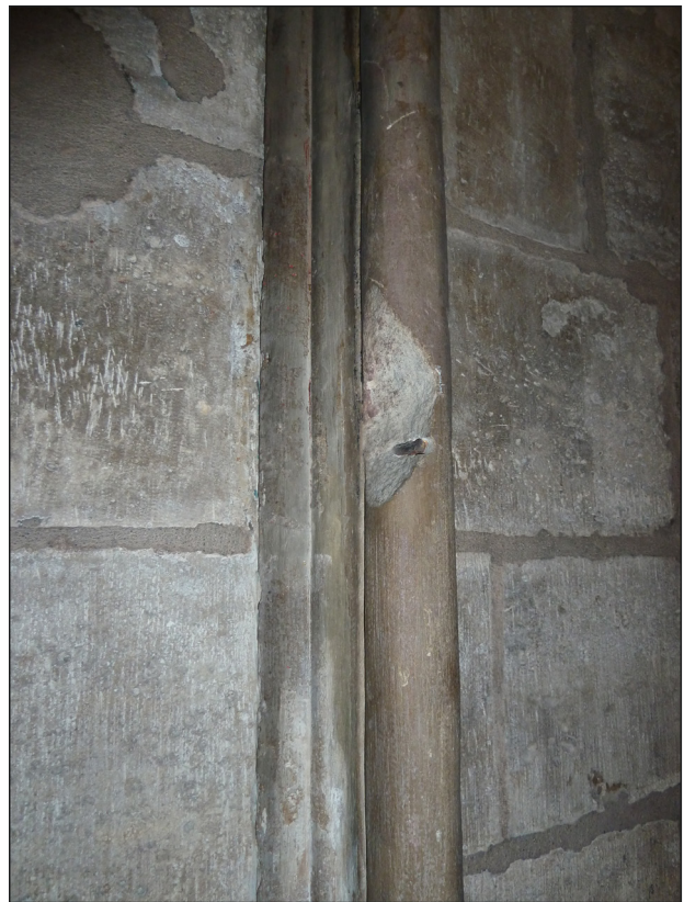
42 PARIS, NOTRE-DAME, QUERHAUS INNENWÄNDE, EISENDÜBEL BLENDMASSWERK, FOTO 2016
