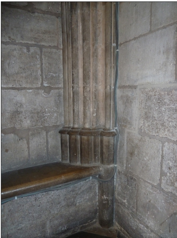
41 PARIS, NOTRE-DAME, SÜDQUERHAUS, ANSATZ DES BLENDMASSWERKS ÜBER DER SOCKELBANK IN DER SW-ECKE. DIE PROFILE FOLGEN DEN STEINLAGEN DER WAND.
