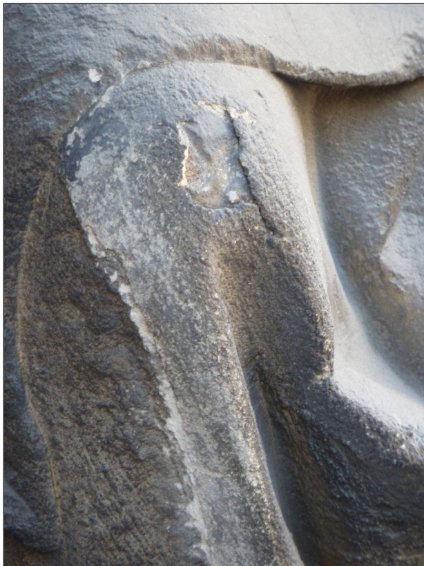
16 PARIS, NOTRE-DAME, NÖRDLICHES QUERHAUSPORTAL, SPUREN DER REPARATURMASSNAHMEN VON ETIENNE-HIPPOLYTE GODDE AB 1843, ANSICHT 2016
