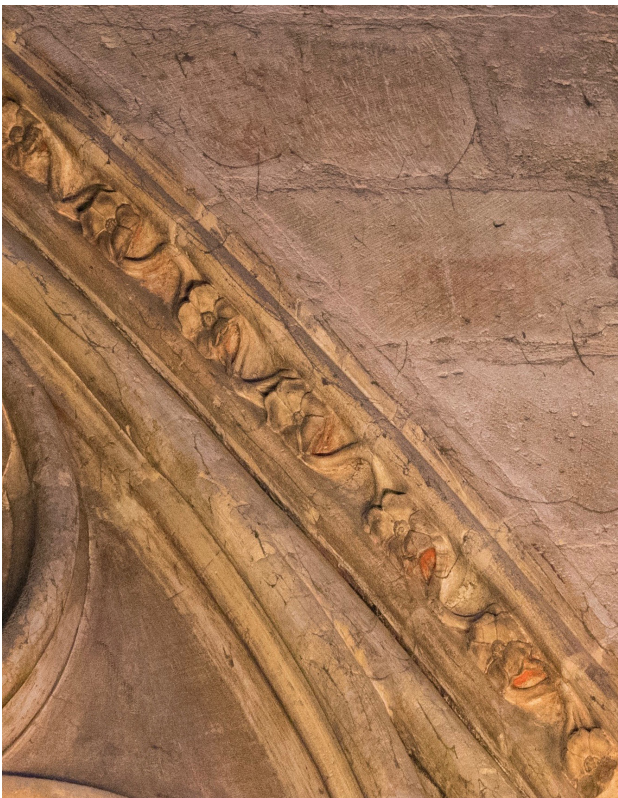
56 PARIS, KATHEDRALE, NÖRDLICHES QUERHAUSPORTAL, INNENFASSADE, ORNAMENTFRIES AM BLENDMAßWERK
