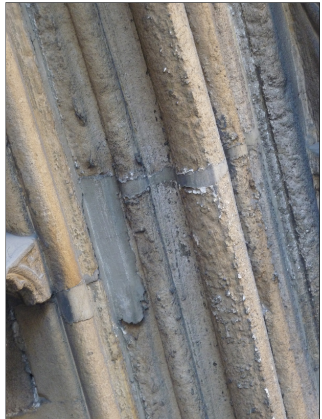
17 PARIS, NOTRE-DAME, NÖRDLICHES QUERHAUSPORTAL, SPUREN DER REPARATURMASSNAHMEN VON ETIENNE-HIPPOLYTE GODDE AB 1843, ANSICHT 2016
