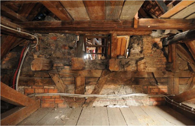
Abb. 22: Blick vom Dachwerk über der Treppenspindel gegen die westliche Traufe des Ostflügels mit ungewöhnlich weit vorkragenden Deckenbalken. Abmauerung mit Ziegelsteinen spätes 19. oder frühes 20. Jahrhundert. Rechts oben Ofenrohrdurchbruch für Kachelofen der Großen Ratsstube
