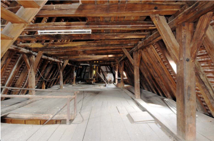
Abb. 15: Blick in das 2. Dachgeschoss mit doppelt stehendem Stuhl
