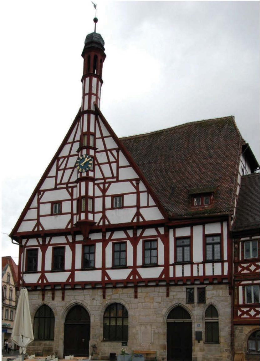
Abb. 5: Blick vom Markt auf die Nordfassade des Ostflügels mit dem Nordgiebel und dem kurzen Nordflügel
