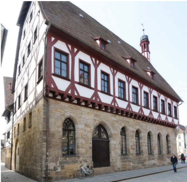
Abb. 4: Ansicht Ostflügel auf die Süd-Ost-Ecke mit der Ostfassade zur Hauptstraße und dem nicht vorkragenden Südgiebel
