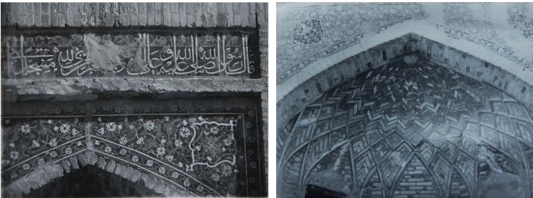
Abb. 10 a-b: Dekor an der Hauptfassade. Fliesenmosaikfeld über der mittleren Nische (oben). Ziegelglasur über der mittleren Nische (unten).
