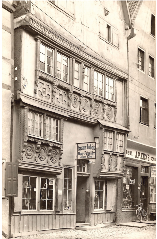
11 Fassadendetail Windeckhaus, Orchheimer Straße. 23, vor 1930.
