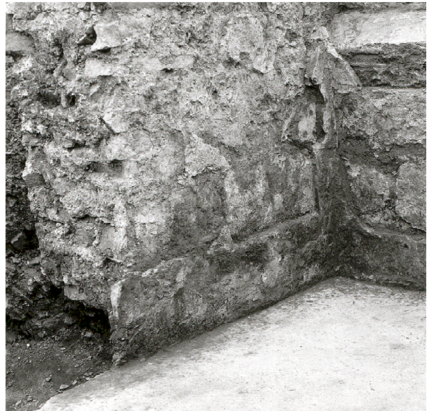
Abb. 388 Nehren, West-Ecke der Grabkammer II, deutlich erkennbar sind die großen Ziegelplatten im Sockelbereich der Innenraumwände, die als Isolierschutz eingesetzt sind.
