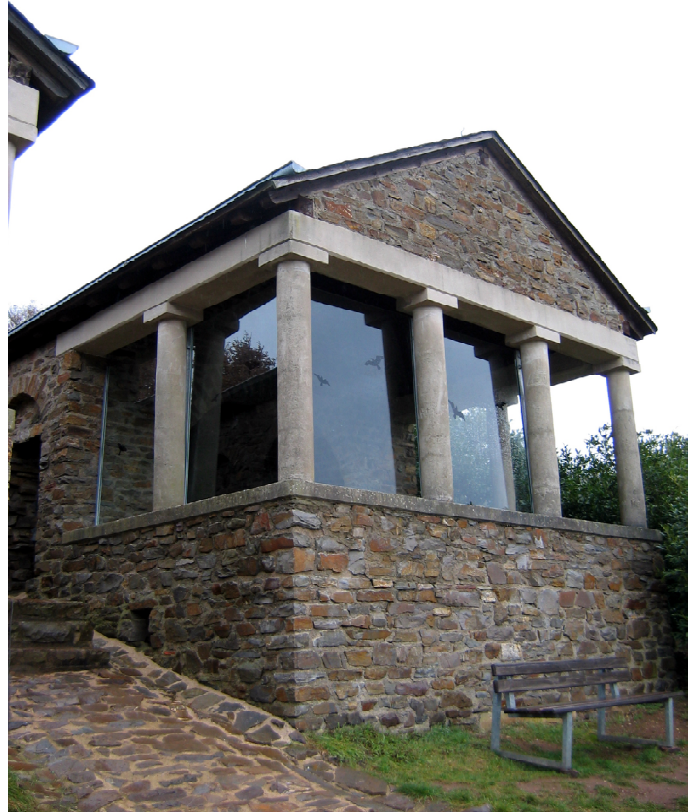
Abb. 405 Nehren, Grabbau II nach der Konservierung und dem Einbau von Schutzfenstern auf der Wetterseite.
