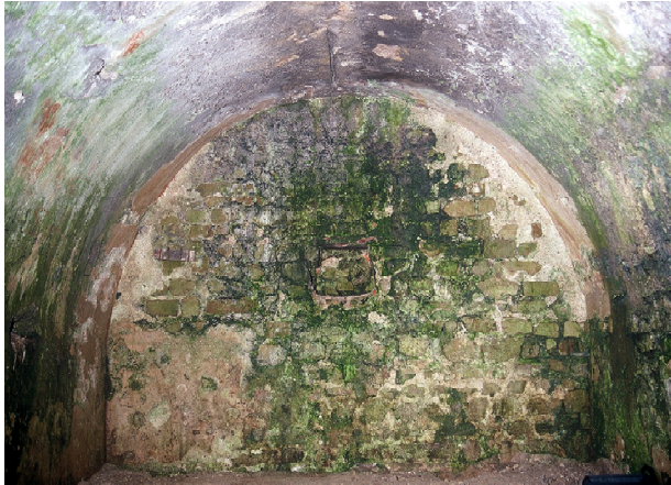
Abb. 438 Igel, Grabkammer, Nordwand, nur in den Randbereichen sind Reste von Putzmörtel erhalten.
