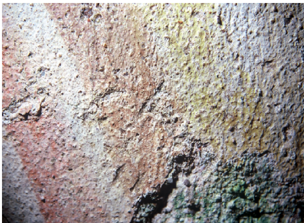
Abb. 440 Ostwand, nördlicher Eckbereich, deutlich ist die ungeglättete Oberfläche erkennbar.
