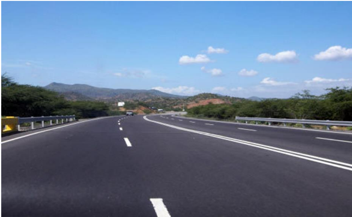
Foto 10: Autobahn M-3, renoviert im Rahmen des Projekts „Nord-Süd-Straßenverbindung Armenien“ (eigene Aufnahme 30.07.2015)
