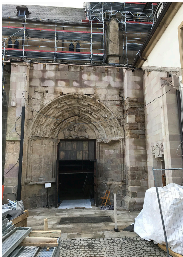
Abb. 3 Tholey, Benediktinerabtei, Nordportal nach Abbau des Schutzbaues aus dem Jahr 1962
