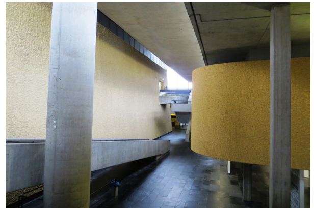
Gangsituation im Innenraum (Foto: Ramona Harmuth, 2018)
