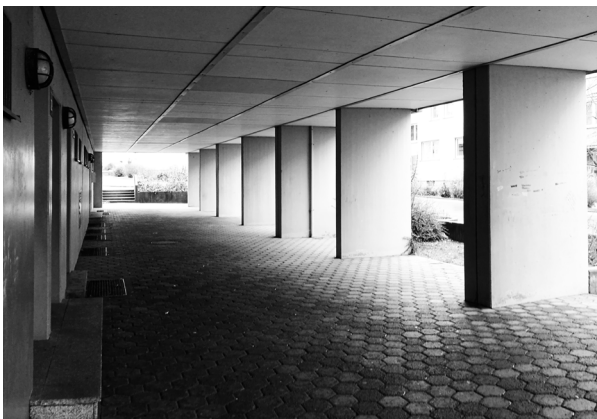
Erdgeschoss-Arkaden der Bebauung an der Luxemburger Straße (Foto: Ronja Rothweiler, 2018)
