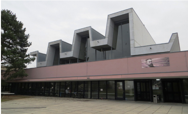
Sicht auf die Westfassade (Foto: Ramona Harmuth, 2018)
