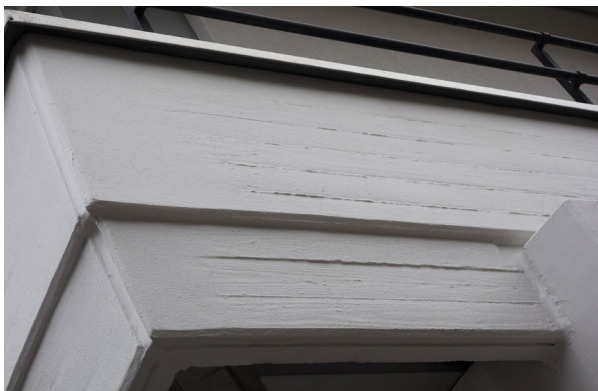
Gestrichene Betonbrüstung mit noch sichtbaren Abdrücken der Holzverschalung (Foto: Eva Kachelmann, 2019)
