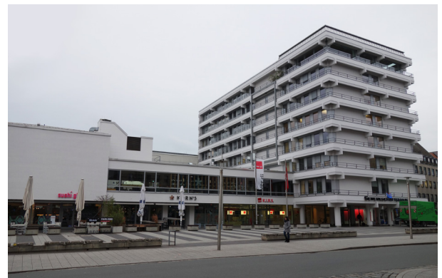
Gewerkschaftshaus nach Fassadensanierung 2008 (Foto: Eva Kachelmann, 2019)
