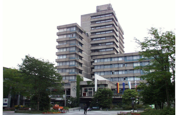
Rathaus vor der Sanierung (Foto: Stadt Erlangen, Bürgermeister- und Presseamt, 2000)
