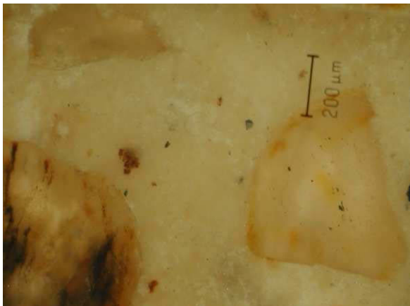
Abb.17.152: Anschliff des Grobputzes Probe M.17 (Auflicht).
