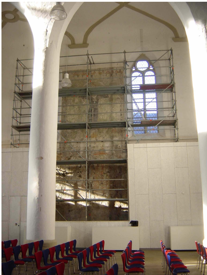
Abb.17.108: Verschalung der Wandflächen mit gedämmten Holz-Heraklitplatten, 2005.
