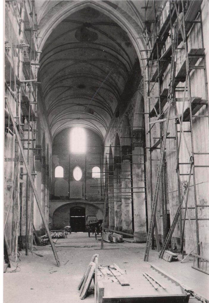
Abb.17.99: Sanierungsarbeiten im Mai 1949.
