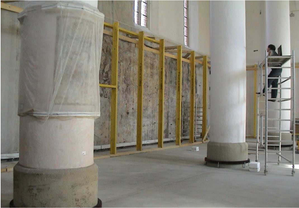
Abb.17.107: Verschalung der Wandflächen mit Holz-Heraklitplatten und Installation einer Konvektorenheizung, 2001/02.
