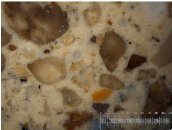
Abb.17.134: Anschliff des Grobputzes Probe M.02 (Auflicht).
