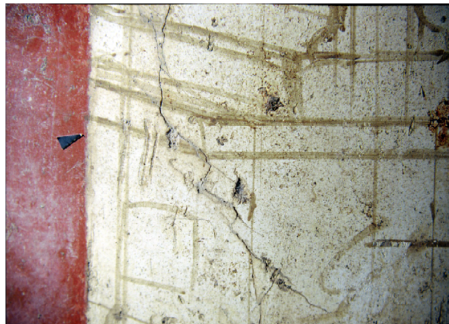
Abb. 26, Detailansicht, das rote Feld ist bereits im Hintergrund glättend verdichtet und fertiggestellt, als mit gelbem Ocker auf dem ebenfalls bereits geglätteten monochromen weißen Oberputz mit gelbem Ocker die Vorzeichnung ausgeführt wird.
