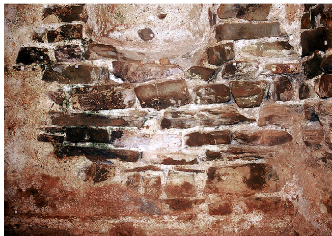
Abb. 5, Setzmörtel in der Grabkammer I in Nehren.
