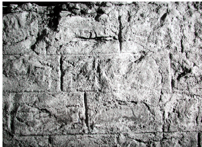
Abb. 4, Setzmörtel an der Basilika in Trier
