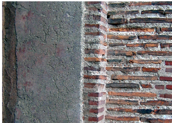
Abb. 4, Setzmörtel an der Basilika in Trier
