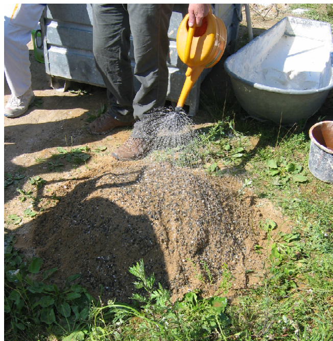
Abb. 20, Trockenlöschchen von gebranntem Kalk in abwechselnder Schichtung mit Sand direkt auf der Baustelle, Putztagung Bad Windsheim Juli 2006.
