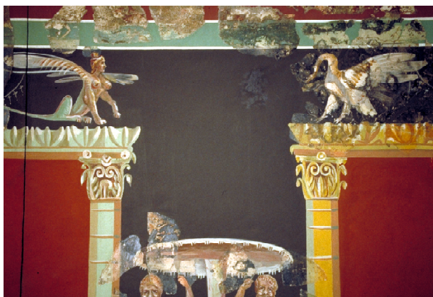
Abb. 47 Wand 1421, Detailansicht, Zustand 2006, untere Bildkante 1 m.
