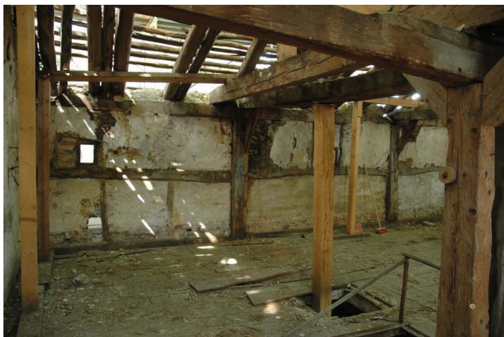
Abb. 3: Dollnstein: spätgotischer Fachwerkbau der Burg
