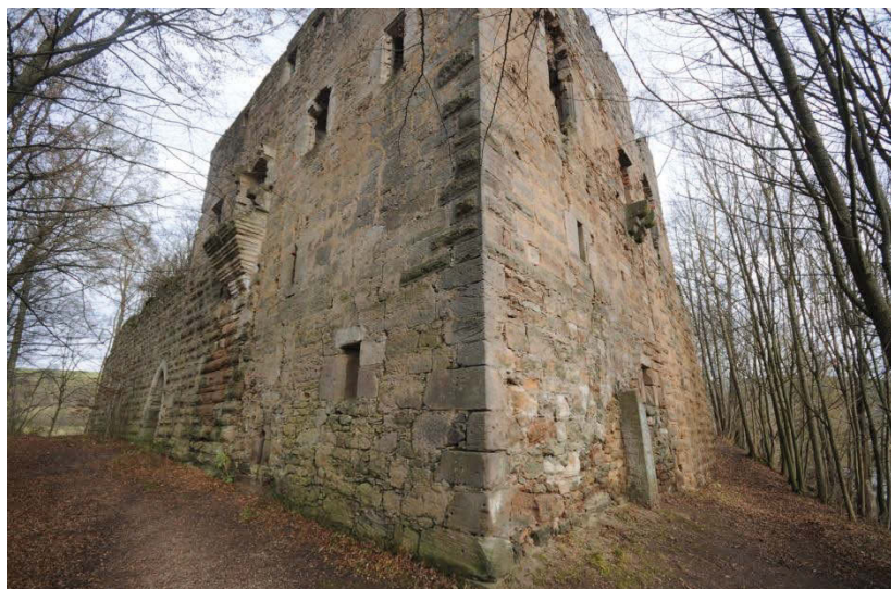
Abb. 8: Leonrod: Außenansicht der Burg
