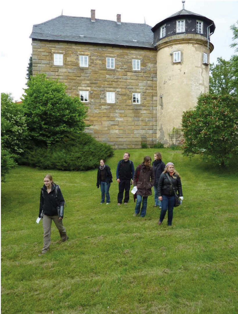
Abb. 11: Lichtenstein: Renaissance-Wohnbau der Vorburg
