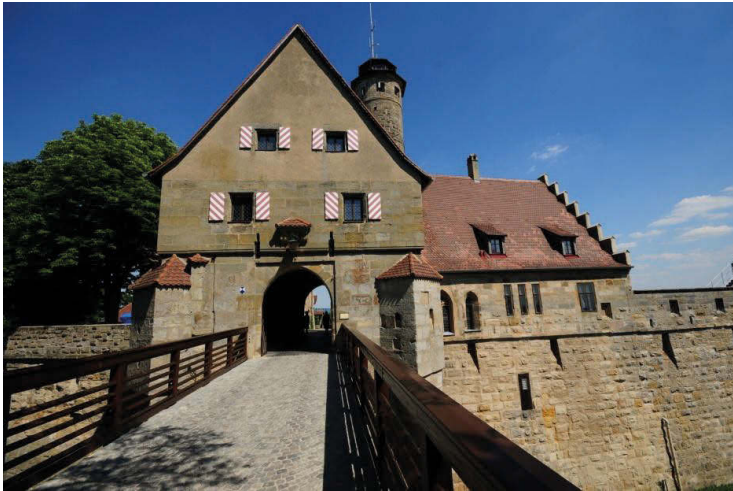
Abb. 1: Altenburg bei Bamberg: Ansicht des Torhauses
