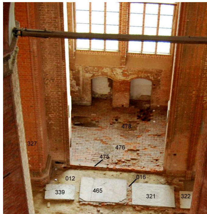
Abb. 185. Wismar, St. Georgen, Fpl. 68. A 102, Befunde in der Pegelkapelle. Blick von Norden nach Süden. 28.11.2008.
