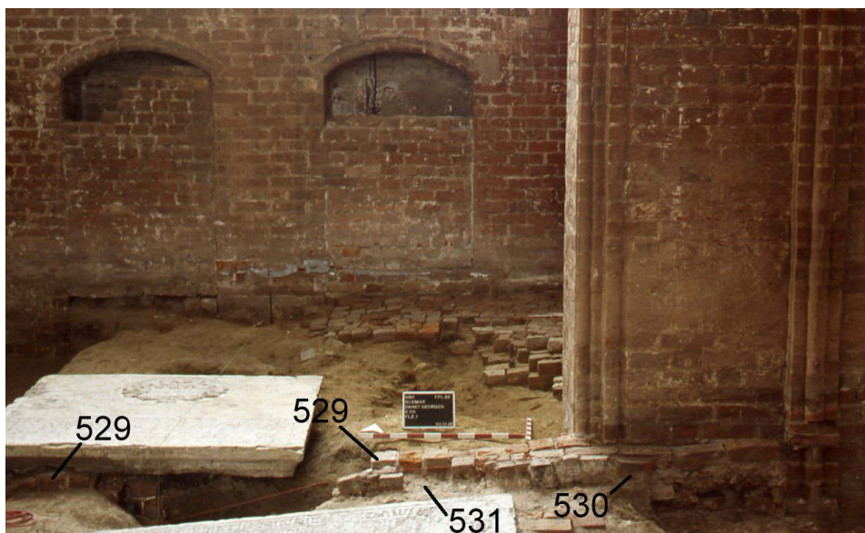
Abb. 146. Wismar, St. Georgen, Fpl. 68. A 105/106, Trennwandfundament (529). Blick von Süden nach Norden. 04.12.2008.
