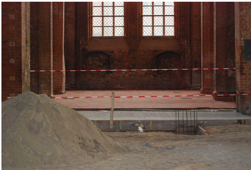
Abb. 8. Wismar, St. Georgen, Fpl. 68. Kampagne 2006, Chorbereich mit neuem Fußboden. Situation 24.08.2007. Blick von Westen nach Osten.
