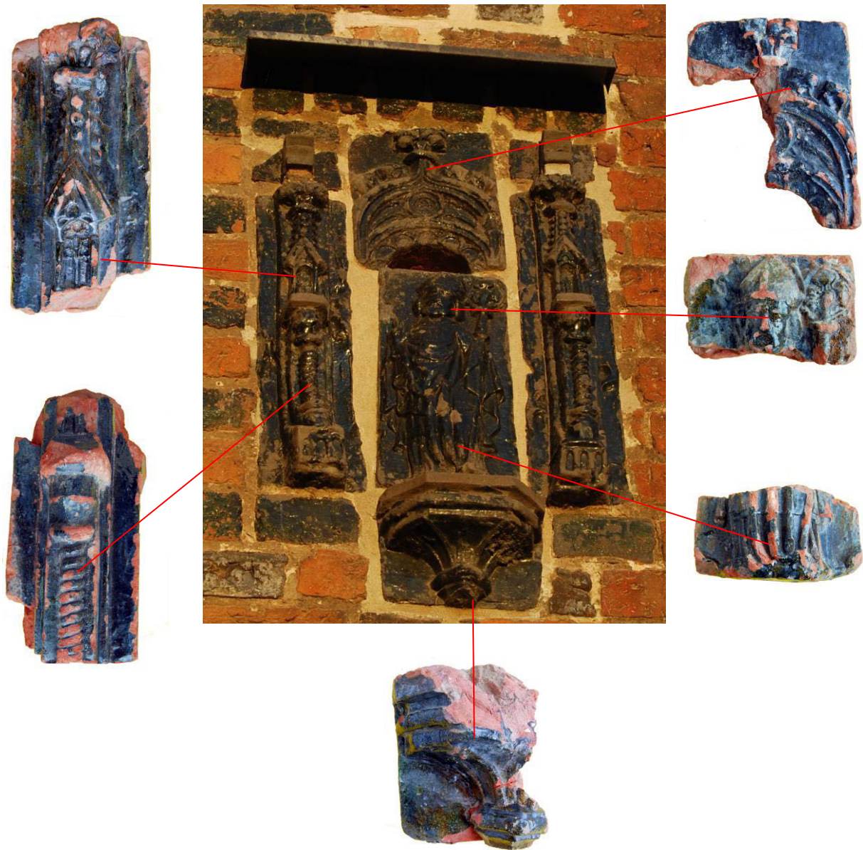
Abb. 84. Wismar, St. Georgen, Fpl. 68. Reliefziegel in der Fassade vom östlichen Treppenturm des Nordquerhauses (vor 1457) und Fundstücke aus Befund (698). ALM 2009/165, 327.
