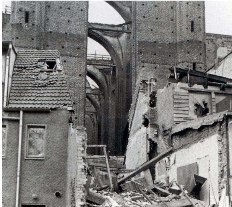
Abb. 24. Wismar, St. Georgen, Fpl. 68. Einsturz des Querhaus-Nordgiebels 1990.
