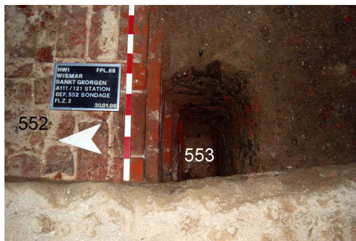
Abb. 51. Wismar, St. Georgen, Fpl. 68. A 111/121, südliches Turmfundament (552). Blick von Westen nach Osten. 30.01.2009.
