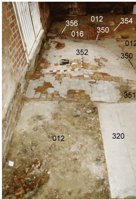
Abb. 181. Wismar, St. Georgen, Fpl. 68. A 80, Befunde am Südportal. Blick von Osten nach Westen. 15.01.2008.
