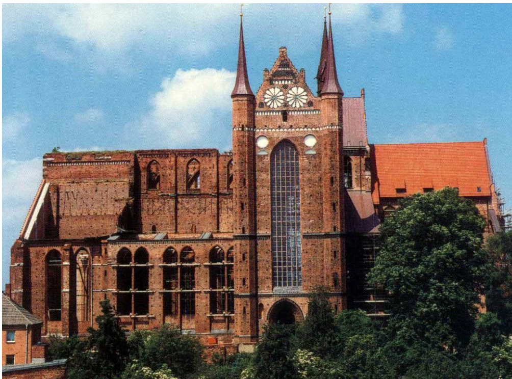
Abb. 25. Wismar, St. Georgen, Fpl. 68. Wiederaufbau der Georgenkirche, Zustand 1998. Blick von Süden.
