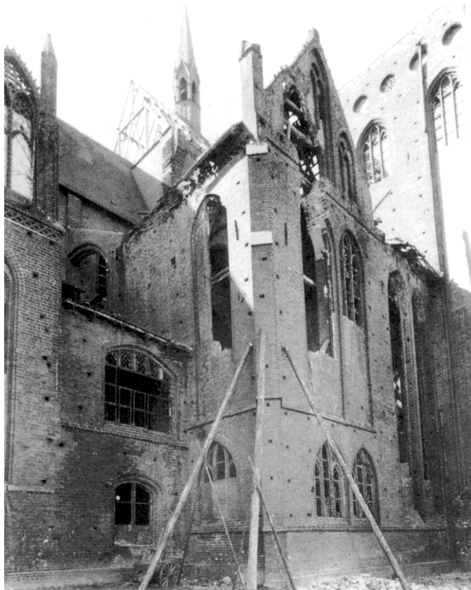
Abb. 23. Wismar, St. Georgen, Fpl. 68. Neue Sakristei, Zustand vor der Sprengung 1961. Blick von Nordosten.
