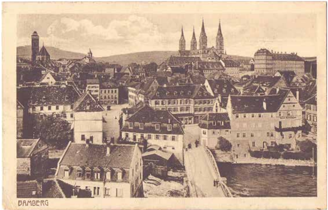
Abb. 3: Das erste Bamberger Wasserwerk. Beiderseits der Geyerswörthbrücke von 1863 die Gebäude des Wasserwerks: die ehemalige Bunzelmühle mit den eingehausten Wasserrädern am Wehr der Unteren Mühlen sowie die ehemalige Mehlnwaage, angebaut an das Anwesen Karolinenstraße 1. Vorn links die Mühlengebäude Untere Mühlbrücke 1 (mit Mansarddach), 2 (mit Walmdach) und 3 (mit Satteldach). Darüber das Konventgebäude des ehem. Franziskanerklosters. Ansichtskarte Gebr. Metz, Tübingen, gelaufen 1. Juli 1912 (Privatbesitz | Repro WK).
