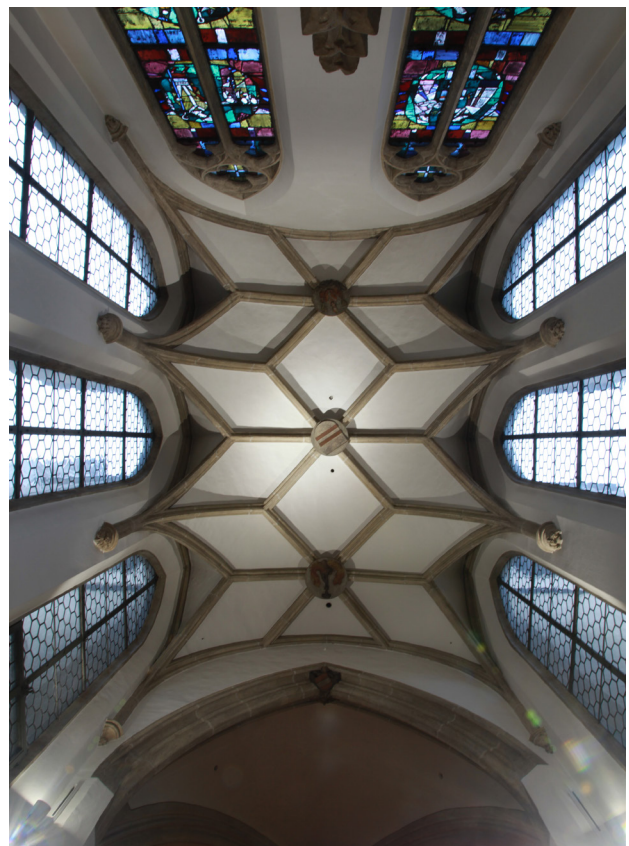
Abb. 7 Passau, St. Stephan, Springrautengewölbe im Chor der Andreas- bzw. Herrenkapelle, 1414
