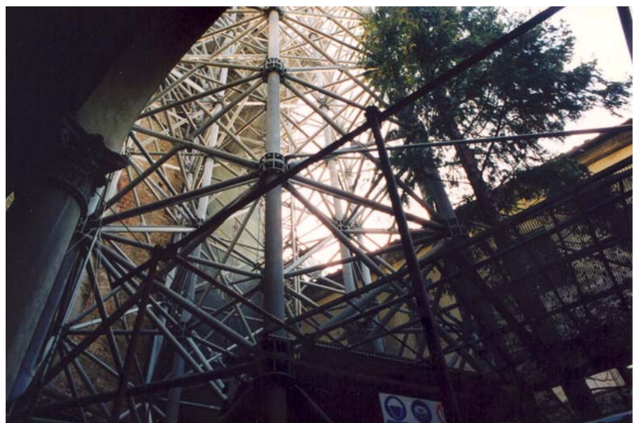
Badia Fiorentina, Gerüstturm im Nordosthof, 2003
