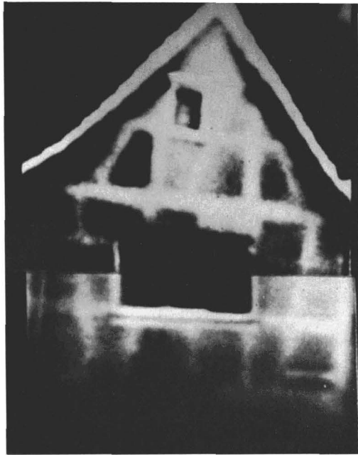
3 Thermogramm eines Fachwerkbaus, Ladenburg, Feuerleitergasse 1, um 1975 (aus: Johannes Cramer: Thermographische Untersuchung verputzter Fachwerkbauten. In: Deutsche Kunst und Denkmalpflege 35 (1977), H. 2, S. 172)
