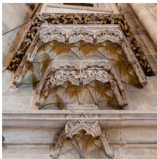
Abb. 16 Regensburg, Dom, Langhausmittelschiff, innere Westwand, Untersicht auf die Konsole des nördlichen Treppenerkers
