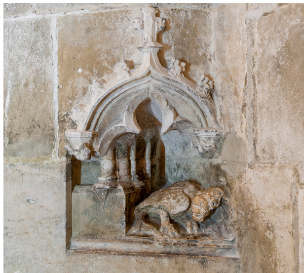
Abb. 14 Regensburg, Dom, Langhausmittelschiff, innere Westwand, Dämonennische in der nördlichen Schrägflanke des Hauptportalblocks
