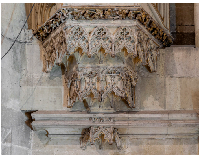
Abb. 15 Regensburg, Dom, Langhausmittelschiff, innere Westwand, Konsole des nördlichen Treppenerkers
