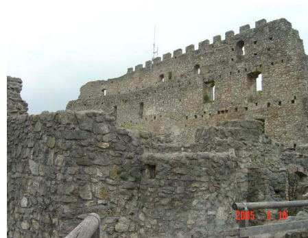
Abb. 3.12 Kernburg. Innenansicht der Nordwand (Grundriss Nr. 1). Der Zinnenkranz blieb unbegehbar.
