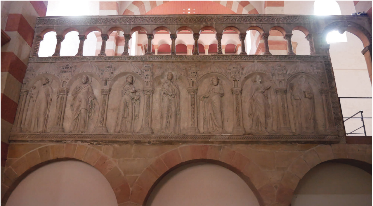
13 St. Michael in Hildesheim, Außenseite der nördlichen Chorschranke, um 1200.
