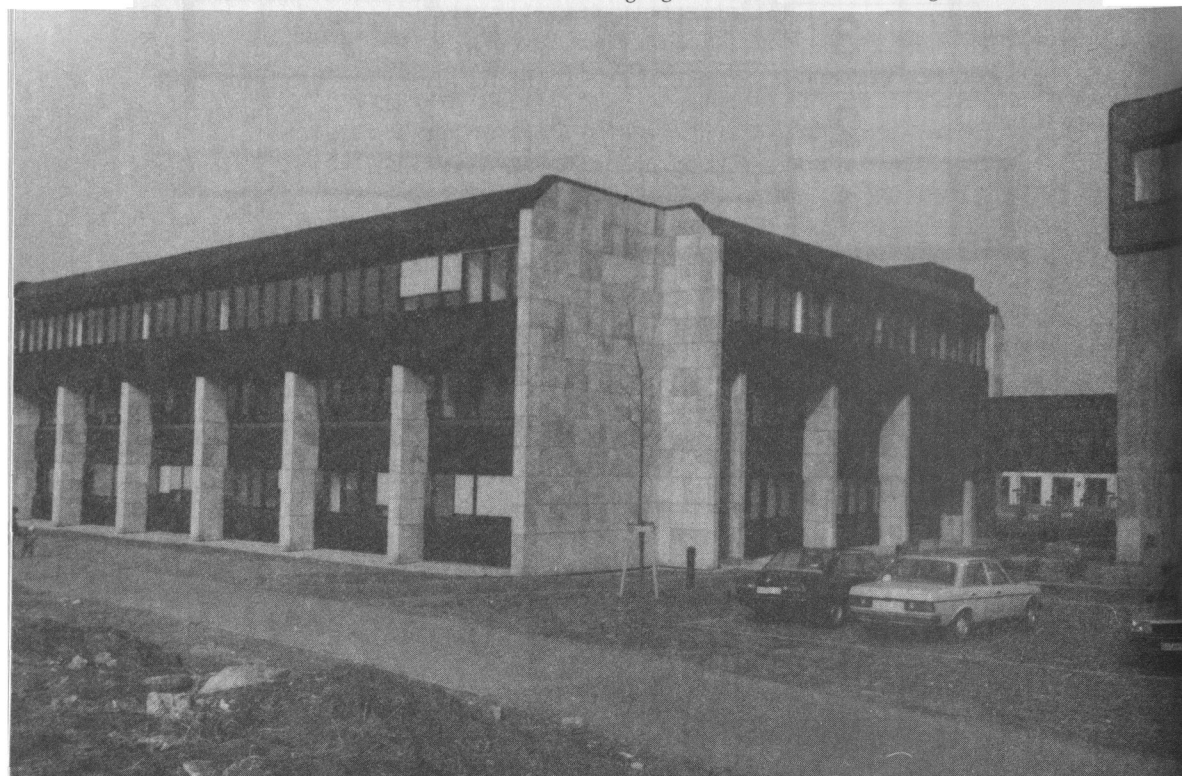
Abb. 8 Außenansicht von Süd-Osten mit Übergangsbrücke zum Universitätsgebäude (rechts)
