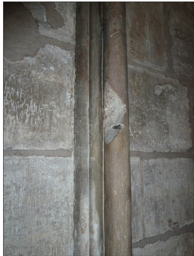
42 PARIS, NOTRE-DAME, QUERHAUS INNENWÄNDE, EISENDÜBEL BLENDMASSWERK, FOTO 2016
