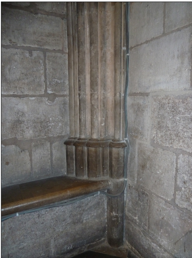
41 PARIS, NOTRE-DAME, SÜDQUERHAUS, ANSATZ DES BLENDMASSWERKS ÜBER DER SOCKELBANK IN DER SW-ECKE. DIE PROFILE FOLGEN DEN STEINLAGEN DER WAND.
