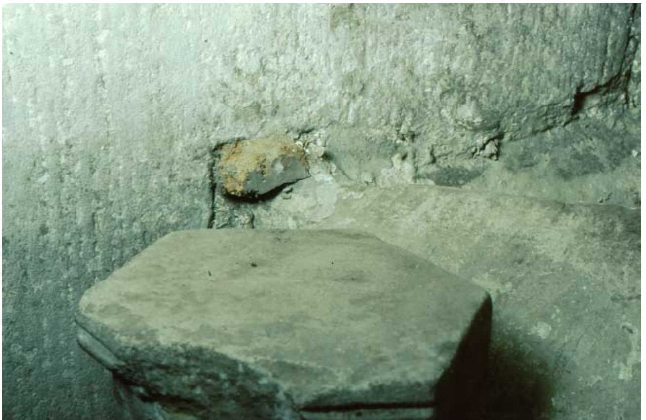
Baldachin der Jungfrau Maria an Pfeiler B3 nord. Gewölbeblock und Anschluss an den Pfeiler. Dokumentation, Analyse. Oben: Aufsicht auf den Gewölbeblock von Osten. Rückwärtiger Zwischenraum zwischen Rückseite des Turmaufsatzes, Oberlager des Gewölbeblocks und Pfeiler. Unter vielen Schichten Fassung und Schlämme liegt die entstehungszeitliche Klammer zur Verankerung des Gewölbeblocks. Unten: Aufsicht auf den Gewölbeblock von Nordosten. Aus der Pfeilervorlage wurde an der Versatzfuge mit Sorgfalt eine Vierung zum Einbringen eines Keils ausgearbeitet, um Rück- und Oberlager des Gewölbeblocks zu fixieren. Fotos: U. Gaasch.
