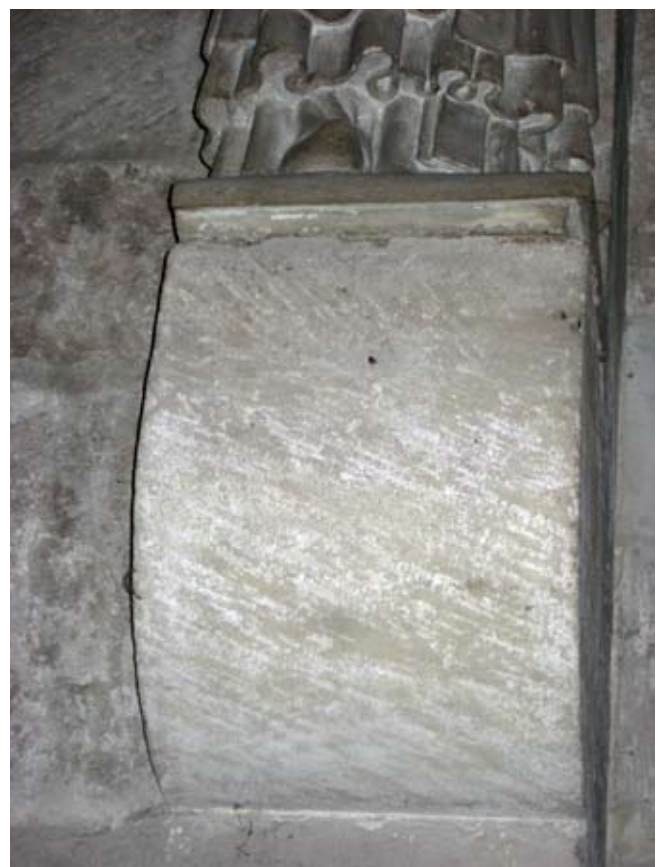
Nordseitenschiff, Achse 4, Pfeiler B4 ost mit entstehungszeitliche Konsole 21, darauf der Hl. Dionysius. Analyse. Die Maße am Unterlager der Skulpturenplinthe stimmen nicht überein mit den Maßen am Oberlager der Konsole 21. Fotos: U. Gaasch.
