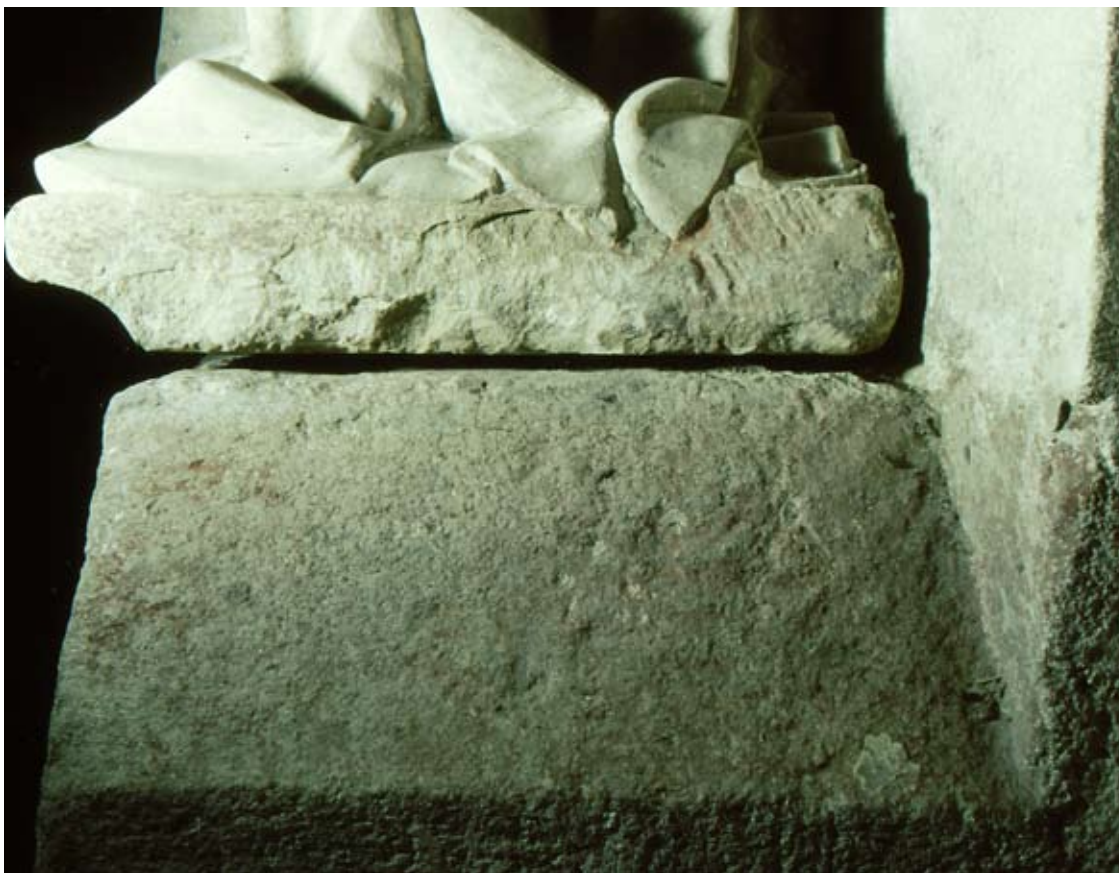
Jungfrau Maria am Pfeiler B3 nord auf entstehungszeitlicher Pfeilerkonsole 15. Linke Seitenansicht. Analyse. Oben: Linke Seitenansicht mit polygonalem Steg, die Gewandfalten wurden bis zur Rückseite detailliert und geschliffen. Der Steg und die Seitenfläche der Plinthe wurden in nicht ausgearbeitetem Zustand belassen. Sichtbar sind die Spuren der entstehungszeitlichen Bearbeitung mit der Zahnfläche. Unten: Die Setzfuge zwischen Plinthe und Pfeilerkonsole 15 ist seit 1942/48 ohne Mörtel. In der Tiefe passt die Figurenplinthe auf die Konsole, in der Breite wurde die Konsole beidseitig abgearbeitet, bezugnehmend auf das Maß der Plinthe. Fotos: U. Gaasch.
