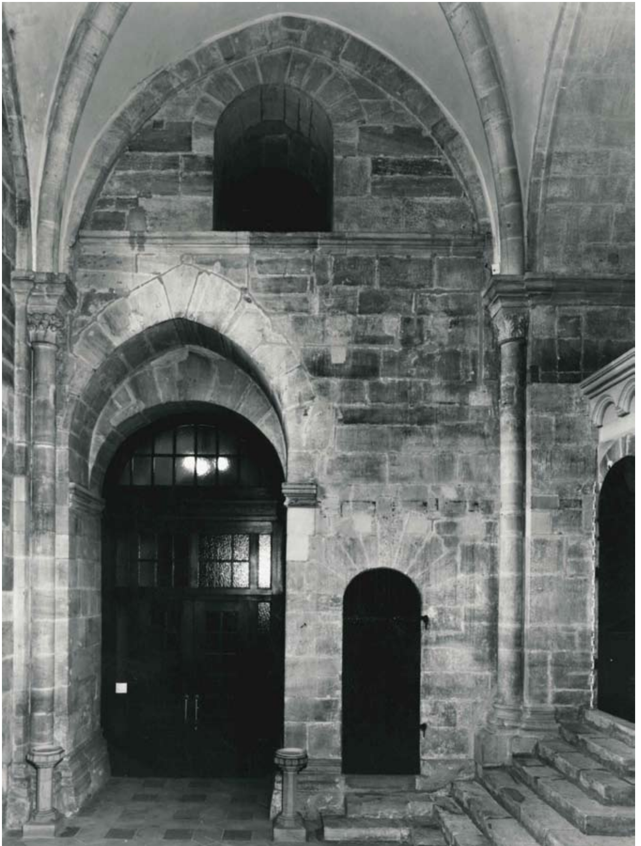
Nordseitenschiff, Joch N1, nach Osten. Westwand des Nordostturmes. Zustand nach 1980. Dokumentation und Analyse. Joch N1 ist der älteste Bauteil des Untersuchungsbereiches. Links: Durchgang zur Vorhalle des NO-Turms und zum Gnadenportal. Mittig: rundbogige Öffnung, der bauzeitliche Zugang zu Kilianskapelle und Turmobergeschossen. Rechts: entstehungszeitliche Treppe auf den Ostchor, mit rundbogigem bauzeitlichen Durchgang. Über dem Gesims das Fenster zur Kilianskapelle. An der Turmwand zeugen zahlreiche Auswechslungen des späten 19. und 20. Jh. von den Umbauten der Sänger- und Orgelempore und von ihrem Abbruch. Foto: U. Gaasch.
