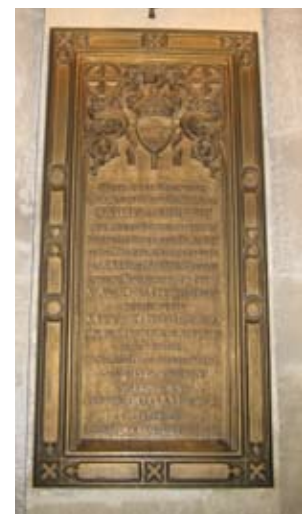
Nordseitenschiff nördliche Außenwand, Achse 2. Analyse. An der Vorlage A2 eine große Vierung, die abgearbeitete Konsole 9, das Emporen- auflager von 1896. Darüber der Abdruck der Emporenbrüstung, darunter das Epitaph des Erzbischofs Michael von Deinlein (+ 4. Januar 1875). Foto oben: U. Gaasch.
