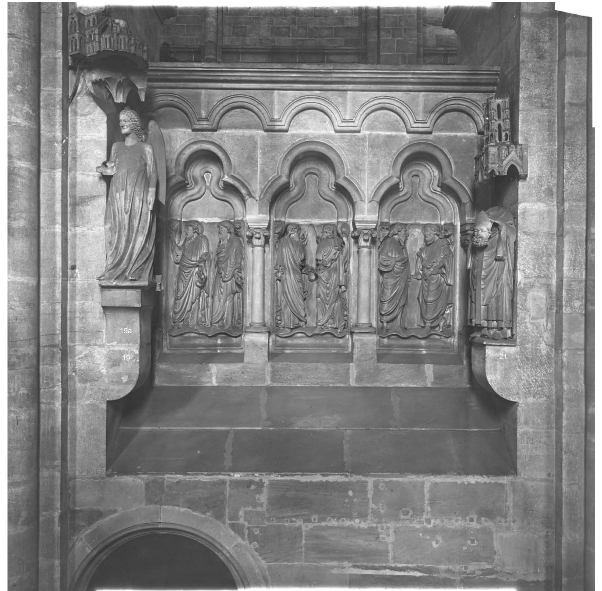
An beiden Schrankenwänden mit Prophetenreliefs lassen sich die Formen von 2 Säulentypen unterscheiden, jeweils beide mittlere mit typisch gotischen Tellerbasen. Links: Messbildfoto V Bd 774.61b. Rechts: Messbildfoto V Bd 774.61a, Staatsbibliothek Bamberg.
