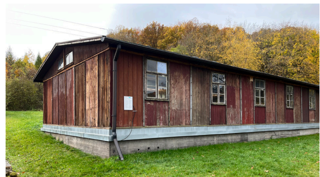
73 Tischlereibaracke, KZ-Gedenkstätte Mittelbau-Dora
