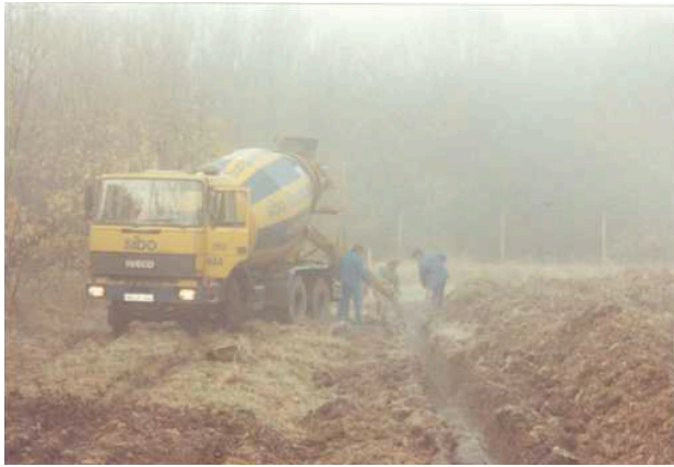
60 Aufnahme Wiederaufbau in Buchenwald, Verfüllung neuer Fundamentgruben mit Beton, 04.11.1993
