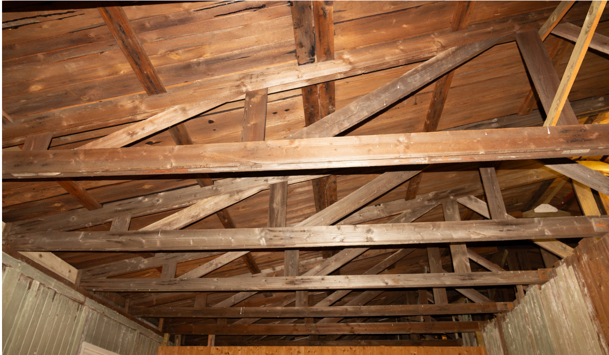
Dachbinder, Blick auf 07b
