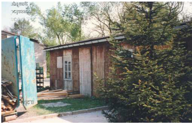
52 Aufnahme der Demontage in Tambach-Dietharz, Südwestliche Wand, 05.05.1993
