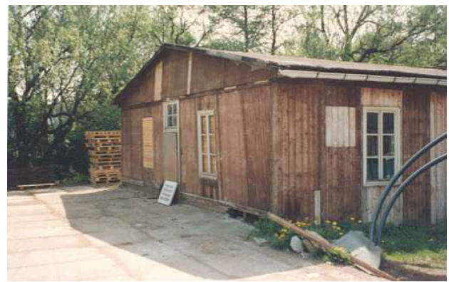
53 Aufnahme der Demontage in Tambach-Dietharz, Nordwestliche Giebelecke, 12.05.1993
