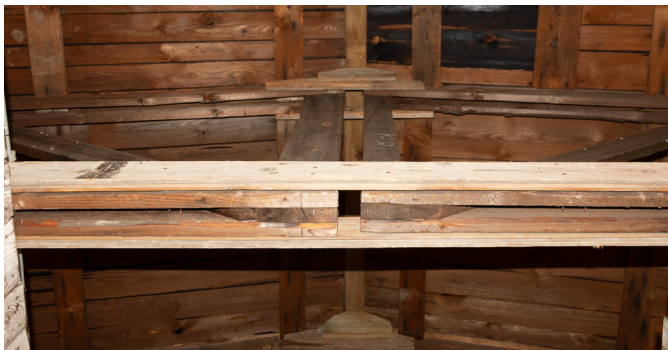
Dachbinder, Detail Mittelstück
