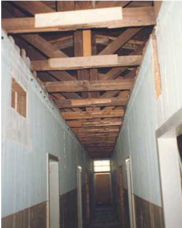
55 Aufnahme der Demontage in Tambach-Dietharz, Mittelgang Nordwesten, 12.05.1993
