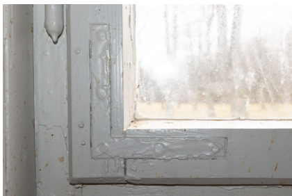
F7a2, Detail Winkelbeschlag
