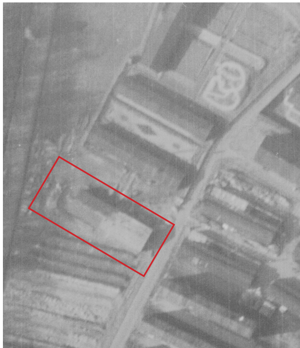
24 Luftaufnahme Standort, Markierung der Baracke, 14.02.1945, TLBG
