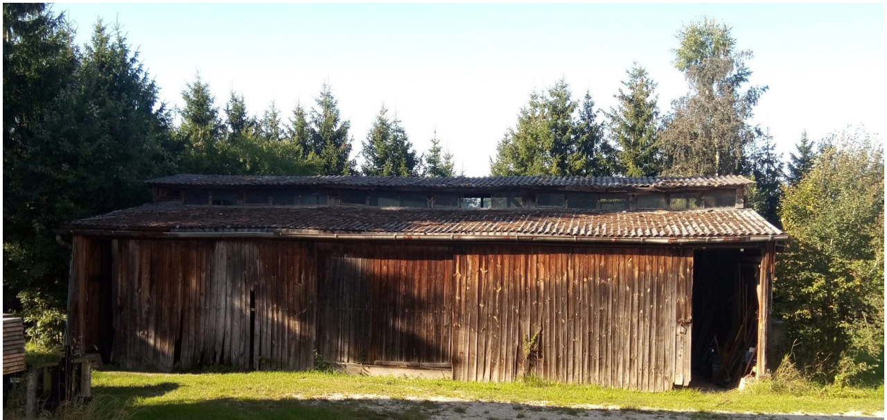
78 Die Pferdestallbaracke OKH 260/9 in situ als landwirtschaftliches Gebäude in Kollersried, Stadt Hemau, Landkreis Regensburg, 2022
