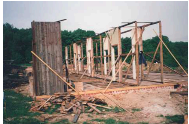
36 Wiederaufbau der Baracke, 18.05.1994
