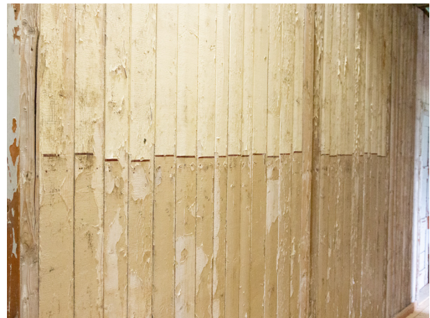
Mittelgang, Detail Holzbretter
