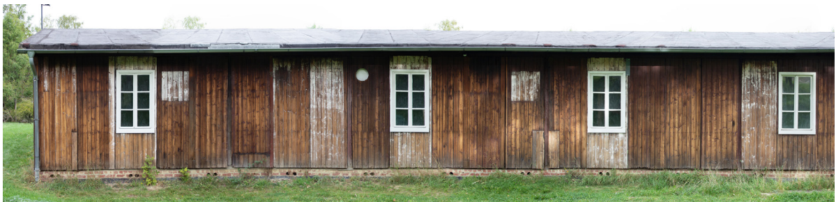
Ansicht Südfassade Westabschnitt
