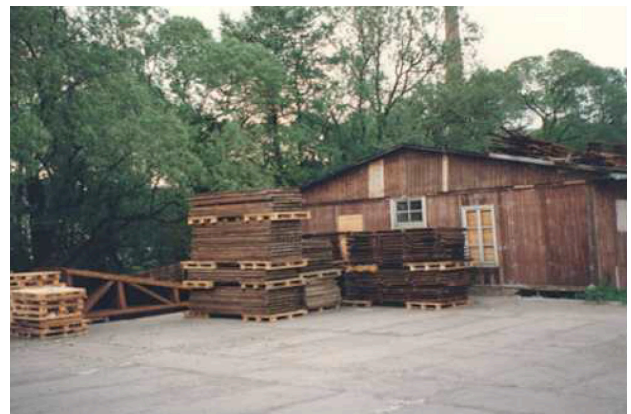
58 Aufnahme der Demontage in Tambach-Dietharz, Südwestliche Giebelwand, 19.05.1993
