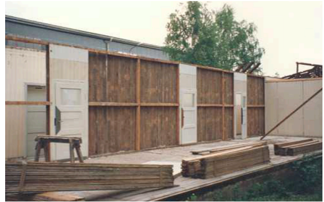
45 Aufnahme der Demontage in Tambach-Dietharz, 19.05.1993
