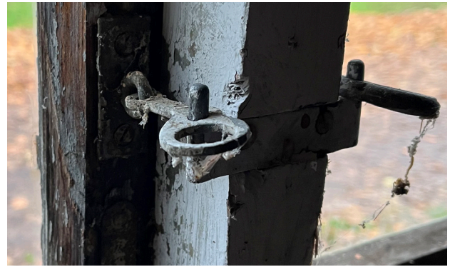
75 Tischlereibaracke, KZ-Gedenkstätte Mittelbau-Dora, Fensterverschluss
