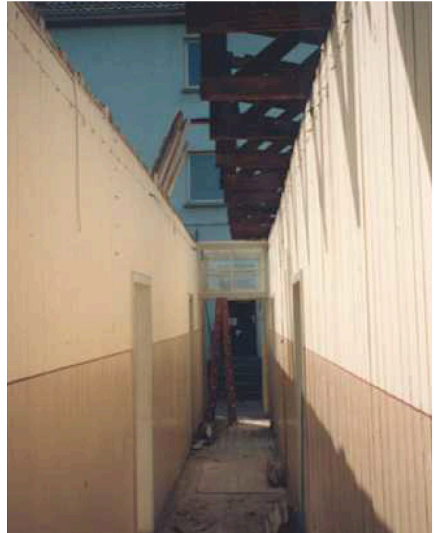
57 Aufnahme der Demontage in Tambach-Dietharz, Mittelgang Südosten, nach 12.05.1993
