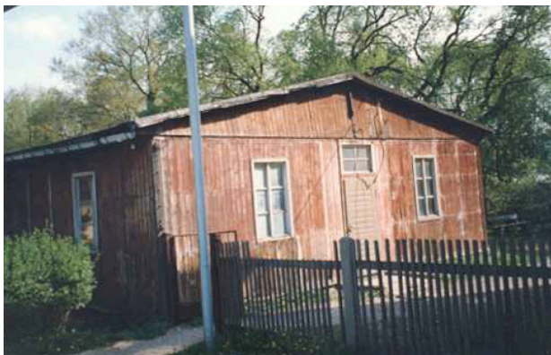
51 Aufnahme der Demontage in Tambach-Dietharz, Südwestliche Giebelecke, 05.05.1993
