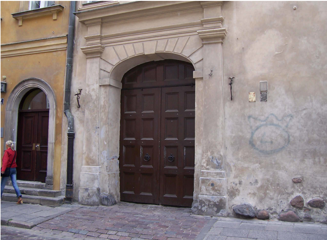
Abb. 168. Eingangsportal zum ehem. Augustinerkloster (jetzt Franziskanerinnen). Foto Verfasserin, 2005.
