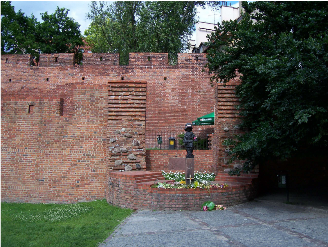
Abb. 104. Westlicher Abschnitt, errichtet vor 1339 und nach 1379. Ergänz in 1958. Fragment mit Resten einer halbrunden Bastei.
