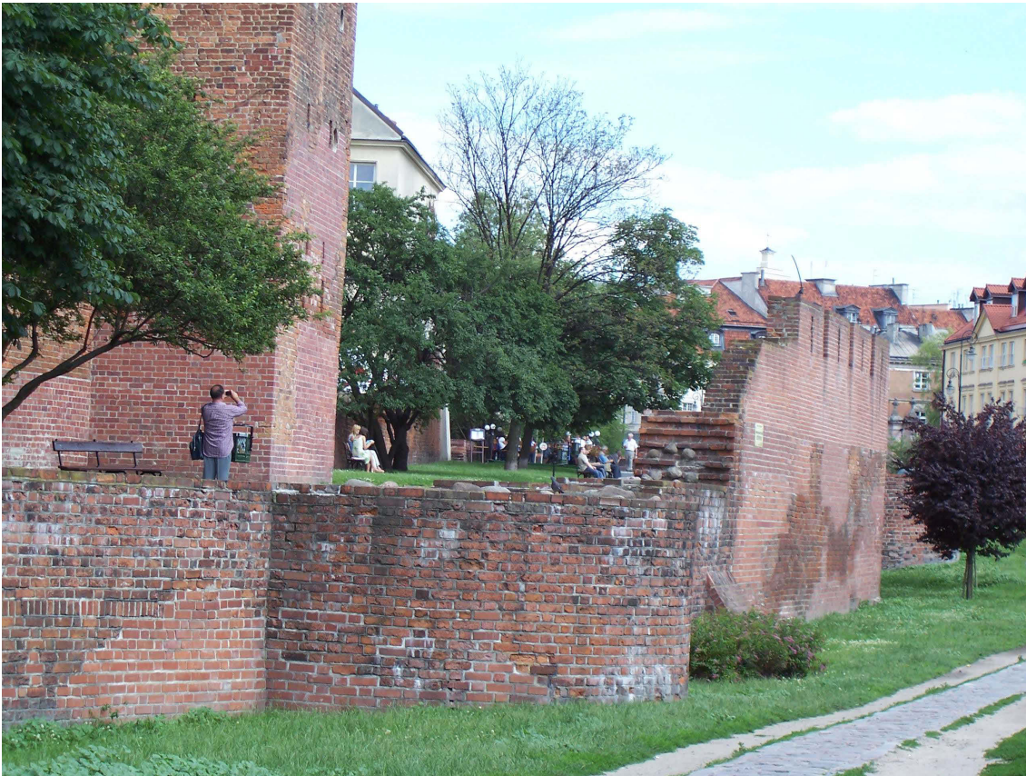
Abb. 103. Süd-westlicher Abschnitt der Wehrmauer. Errichtet vor 1339 und nach 1379. In dem Jahr 1958 ergänzt und teilrekonstruiert.
