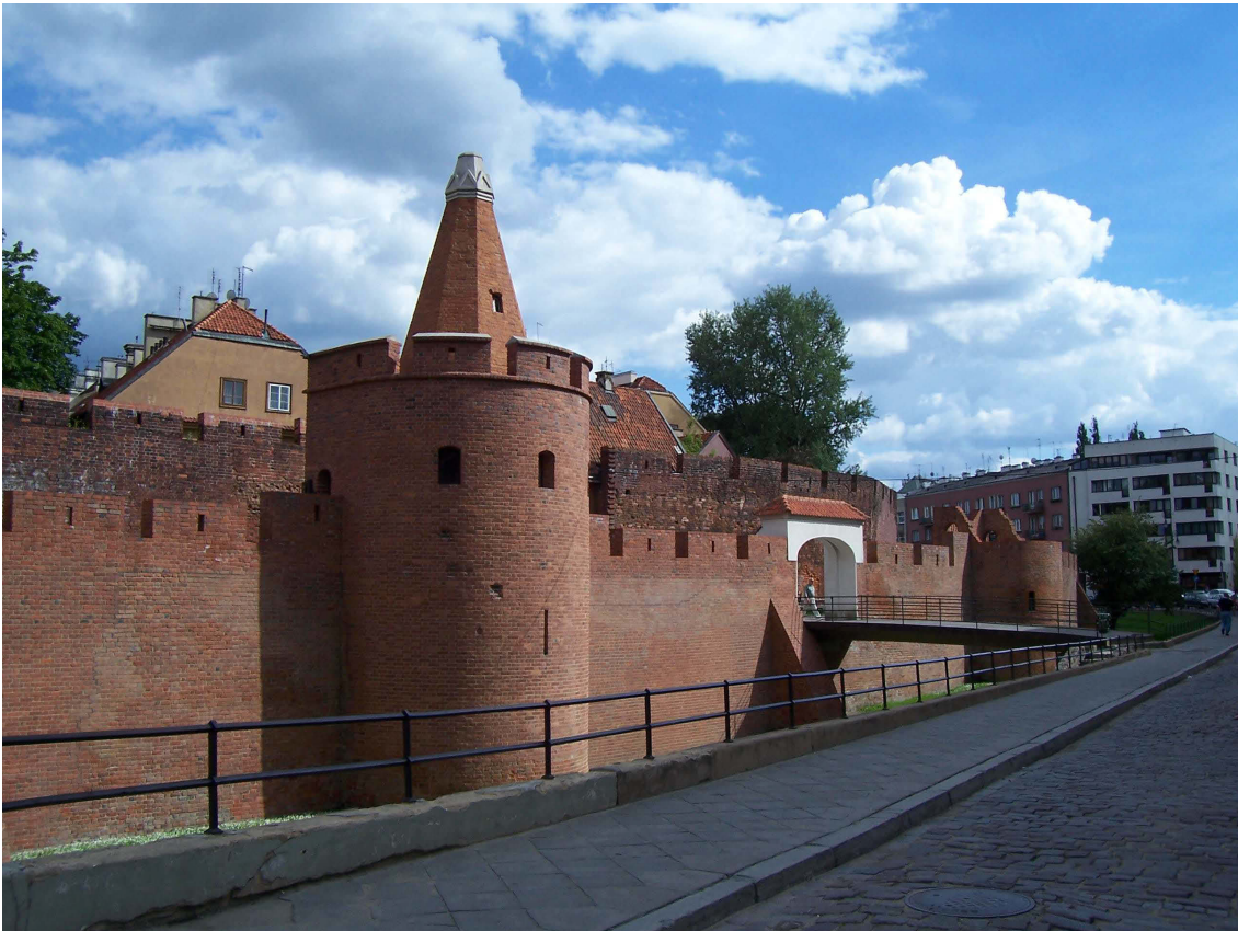
Abb. 95. Pulverbastei von der 2. Hälfte des 15. Jh. rekonstruiert in den Jahren 1937-1938 und 1958-1963, gesehen von der Seite der Podwale-Straße. Foto Verfasserin, 2005.
