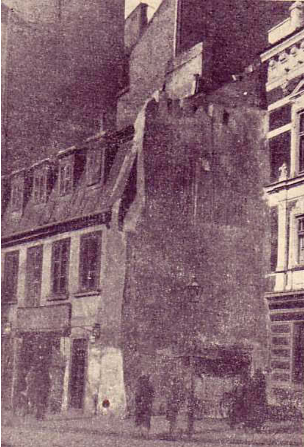
Abb. 74. Reste der Barbakane in dem Haus Nowomiejska-Straße Nr. 24. Fotograf unbekannt, 1916. Nach: Zachwatowicz Jan, Mury i barbakan Starej Warszawy ( Mauer und Barbakane von Alt-Warschau ), in: OZ 1953, Heft 2-3, S. 93-106, Bild 121, S. 102.
