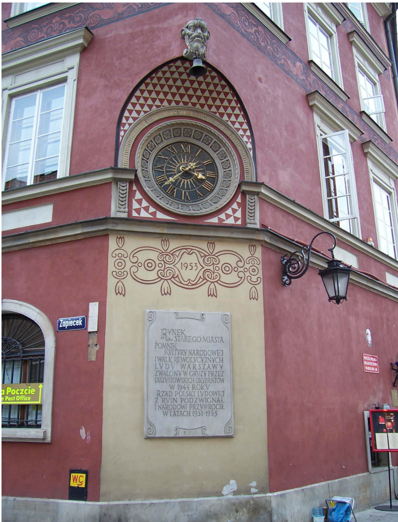
Abb. 212. Haus Rynek Nr. 15 an der Ecke des Altstädtischen Marktes und Zapiecek-Straße. Foto Verfasserin, 2005.
