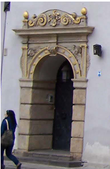
Abb. 271. Portal in Rynek Nr. 31. Foto Verfasserin, 2008.
