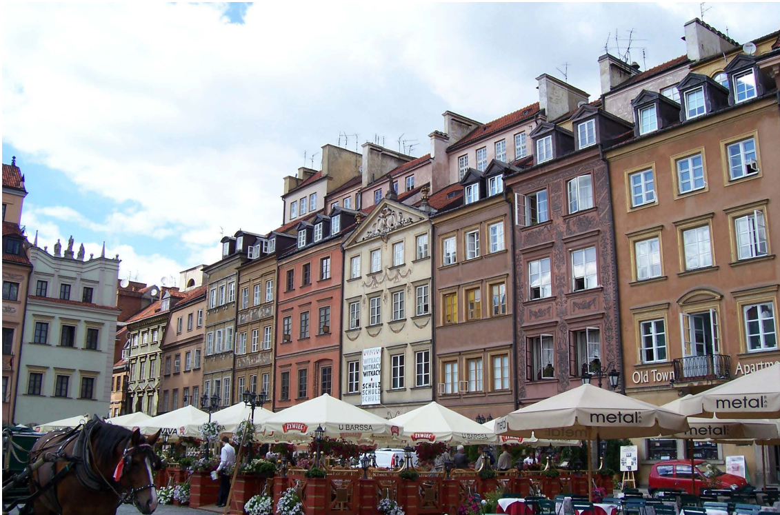
Abb. 41. Altstädtischer Markt nach dem Wiederaufbau. Von links Eckhaus der Dekert-Seite Nr. 28, Häuser der Barss-Seite Nr. 26, Nr. 24, Nr. 22, Nr. 20, Nr. 18, Nr. 16, Nr. 14 und Nr. 12. Foto Verfasserin, 2008.
