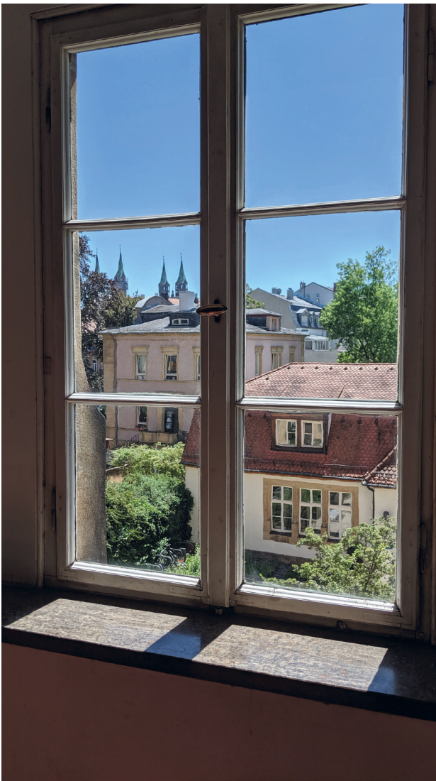
2 ERSCHEINUNGSBILD HISTORISCHEN GLASES: DURCH DIE OPTISCHEN FEHLER IM GLAS WERDEN EIGENTLICH GERADE LINIEN GEBROCHEN UND ERSCHEINEN „VERSCHWOMMEN“
