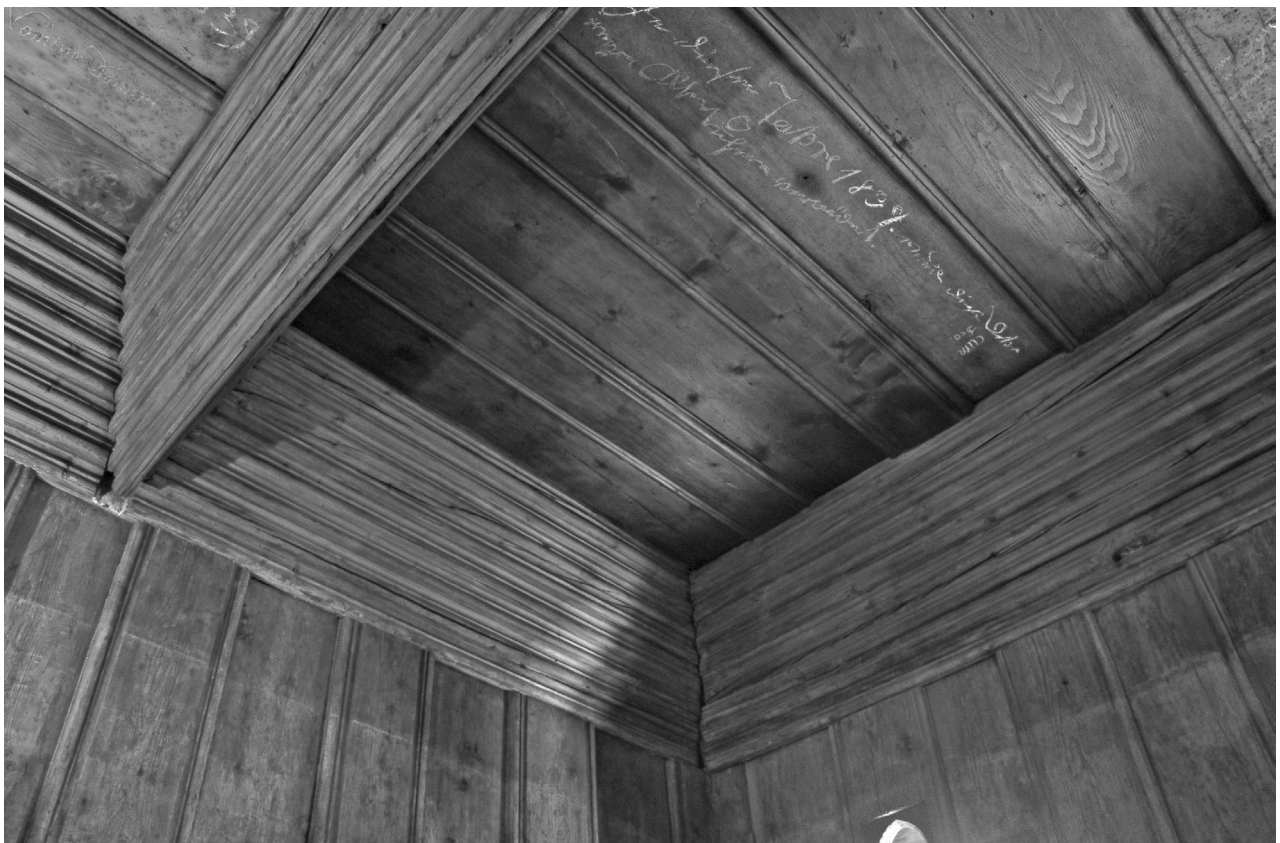
6 Pirna, Tetzehaus. Ausschnitt der restaurierten Decke und Wand der Bohlenstube von 1381 (Restaurierung: Markus Schulz).
