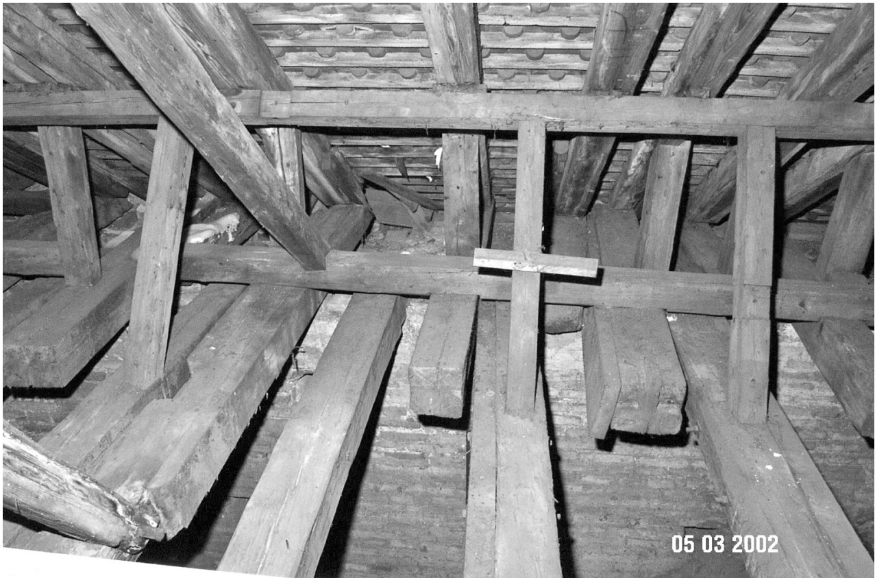
1 Augsburg, Hoher Dom. Fußbereich des nördlichen Chorseitenschiffes mit zahlreichen heterogenen Ergänzungen.
