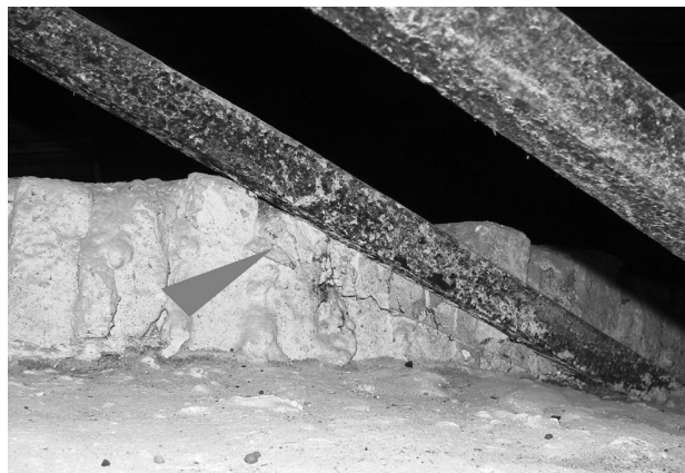
12 Wie Abb. 7. Abdrücke der Eisenanker an den Gewölberippen der ursprünglich steiler verlaufenden Gewölbeform.
