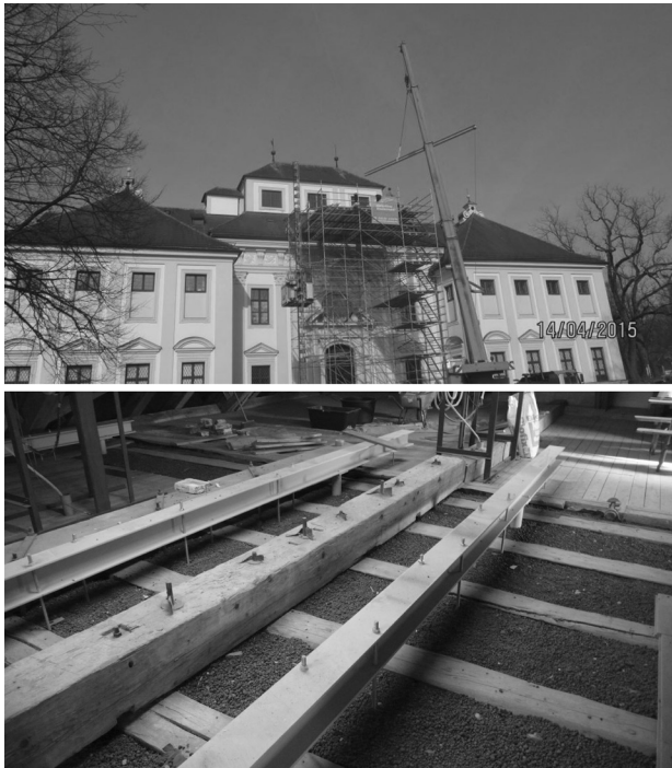
15 Wie Abb. 7. Einbringung der modernen Ankersicherung (oben). Jetzige Situation über der Zerrbalkenlage (unten).
