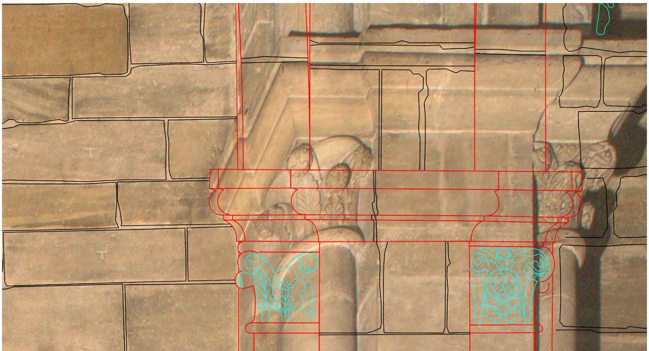
13 Bamberg, Dom, nördliche Mittelschiffwand, Gewölbeansatz. Auf die Wandfläche entzerrtes Bild mit 2D-Strichzeichnung überlagert. Nur die Auswertung der Wandfläche ist deckungsgleich mit dem Photo.
