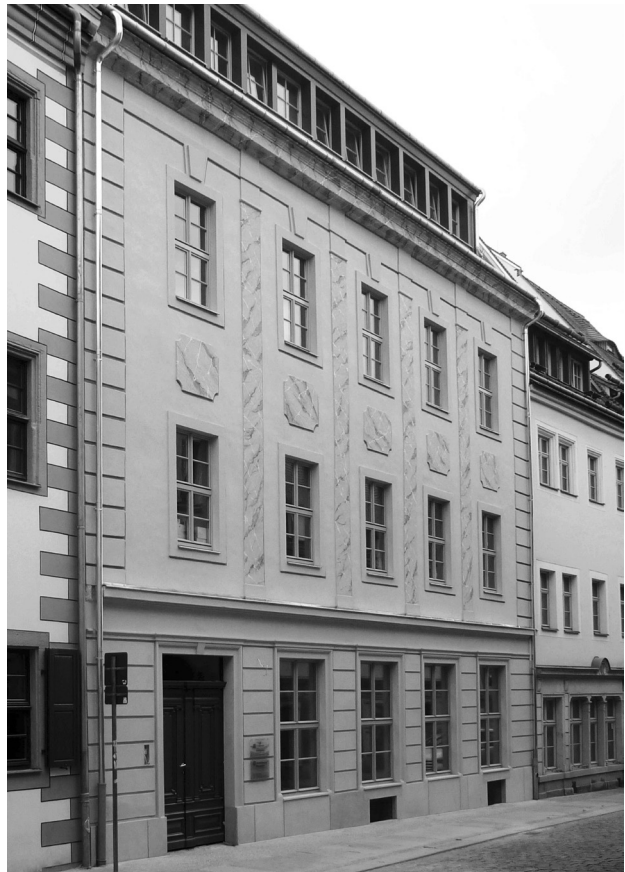
2 Pirna, Wohnhaus Schloßstraße 8. Bewahrung der barocken Fassade von 1721 und Wiederherstellung der Fassung bei gleichzeitigem Aufbringen einer flächigen Kalzium-Silikat-Dämmung auf der Rauminnenseite.
