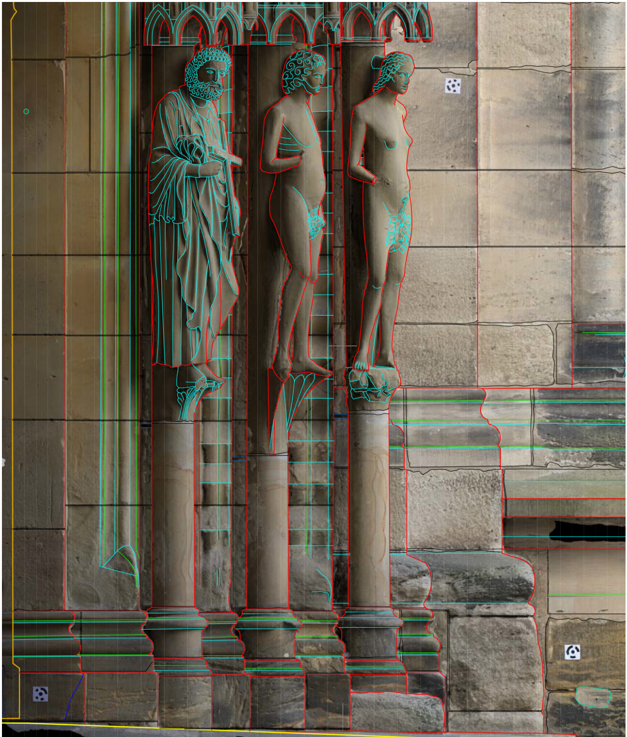
14 Bamberg, Dom, Adamsforte, Nordseite. Ausschnitt aus einem mit SfM generierten Orthophoto einschließlich Strichauswertung.
