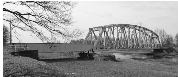
ABB. 2 Premsendorf, Vorland- und Strombrücke über die Schwarze Elster mit gemeinsamem Festlager auf dem Mittelpfeiler, 2013
