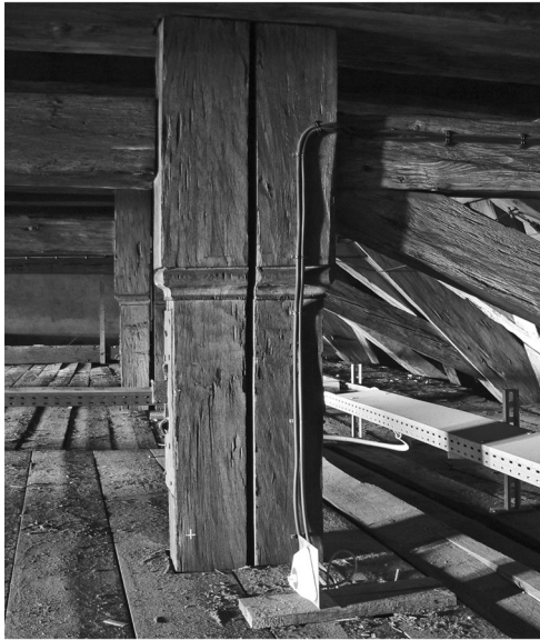
5 Bamberg, Residenz. Dachwerk über dem Kaisersaal, Detail Hängesäule.
