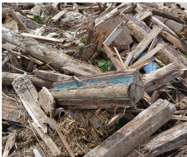
1 Oschersleben, Ortsteil Schermcke, Am Sauren Holz 6, ehemalige Hofstelle. Profiliertes Füllholz aus der Oberstock-Schwellzone des im Dezember 2014 als Sicherheitsabbruch mitsamt der Hofanlage niedergelegten Fachwerkwohnhauses von 1692 (d), Aufnahme Mai 2015.
