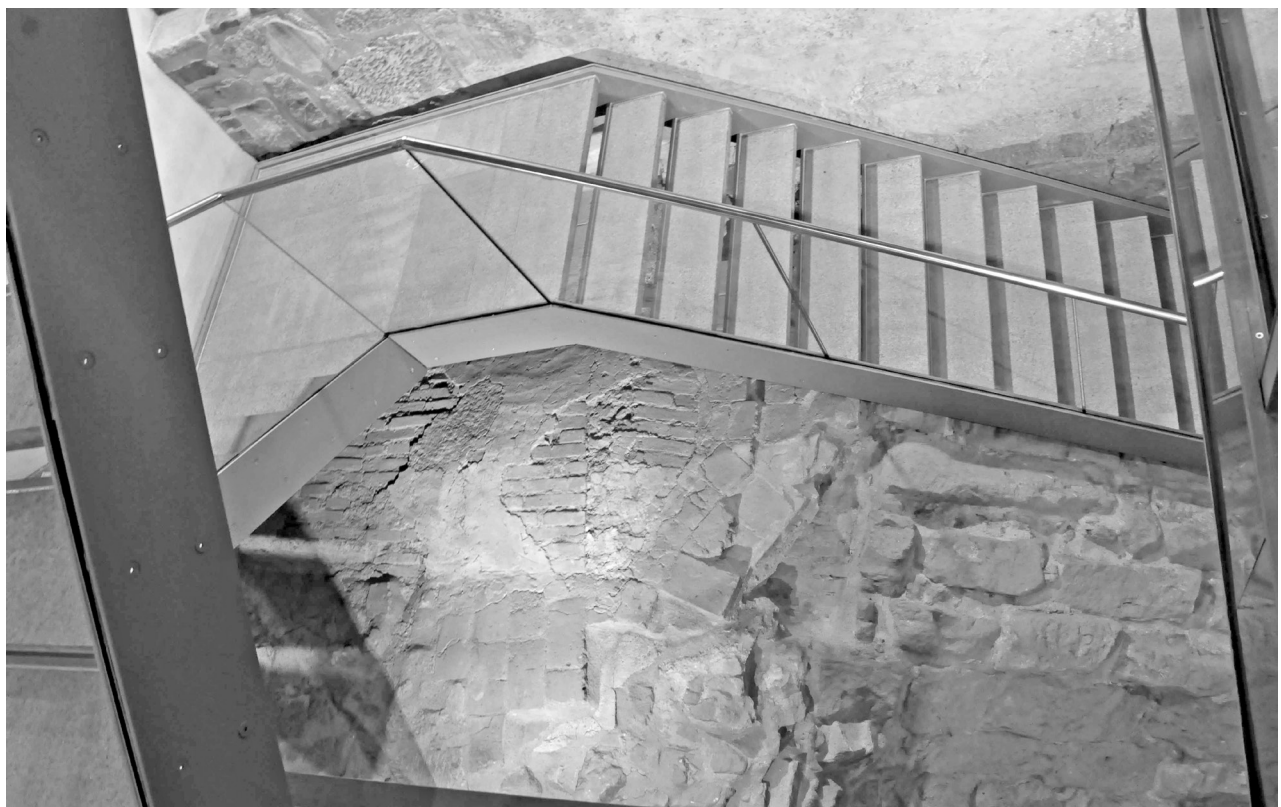
15 Veste Heldburg, Heidenbau, Erdgeschoss. Überwölbter Kellerhals in der Südwestecke mit der Treppe ins 1. Obergeschoss, Zustand 2011.
