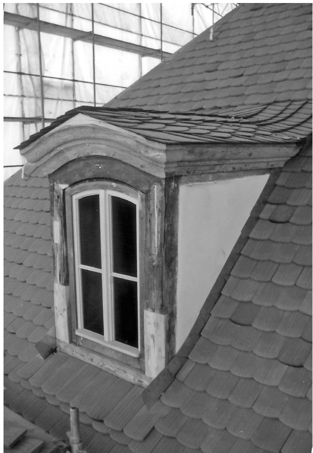
4 Weimar, Schloss Tiefurt (um 1776). Reparatur einer bauzeitlichen Dachgaube nach dem Entfernen jüngerer Bekleidungen auf der Basis einer fundierten Untersuchung (Bauforschung und Planung: Architektengemeinschaft Milde + Möser, 2004–2006).
