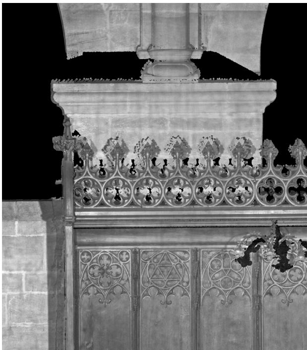
7 Bamberg, Dom, Ostchor, Nordseite. Detail des Chorgestühls mit anschließendem Pfeiler als Orthophoto aus Laserscan und externem Photo.
