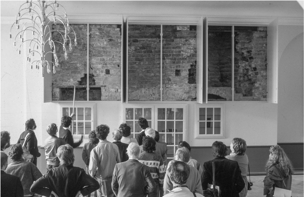
1 Versteckte Geschichte: Hinter normalerweise geschlossenen Klapptüren sind die Befunde zu dem mittelalterlichen Mauerwerk eines Lübecker Kaufmannshauses versteckt. Nur während der Führung öffnet sich das Fenster zur Geschichte.
