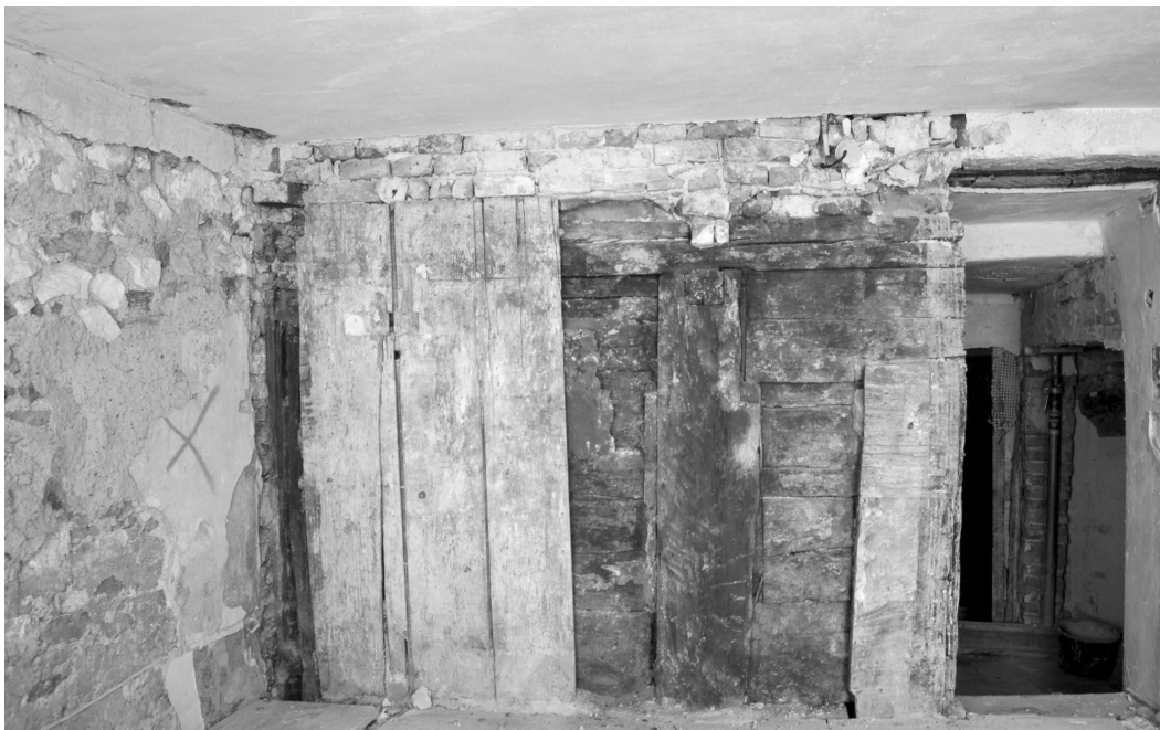
11 Regensburg, Ortnergasse 3. Stube im 1. Obergeschoss. Ständerbohlenwand gegen die Diele.
