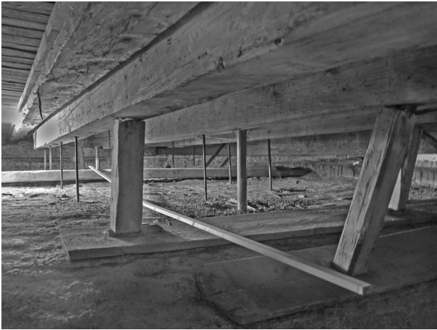
8 Wie Abb. 7. Gewölbeoberseite des HauptsaaIs mit verschiedenen Hilfskonstruktionen.
