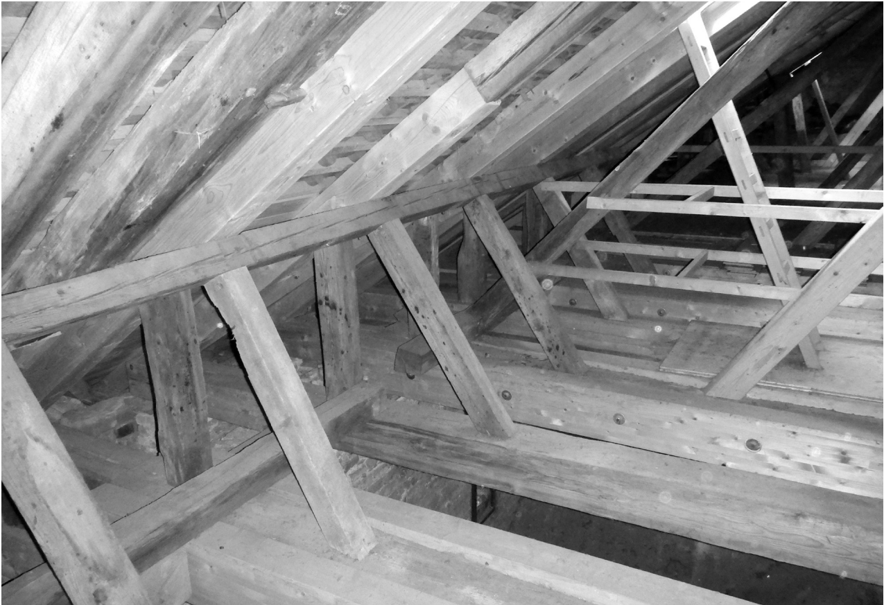
3 Augsburg, Hoher Dom, nördliches Chorseitenschiff. Zustand nach zimmermannsmäßiger Reparatur unter Beibehaltung der Ergänzungen.
