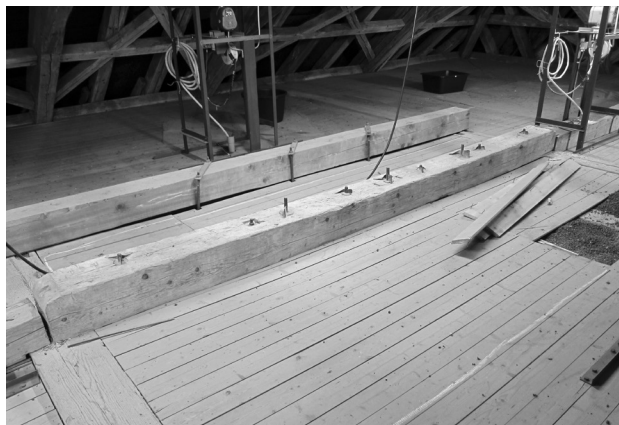
11 Wie Abb. 7. Mittlerer Überzug über dem Gewölbe zwischen den Sägezahnbalken mit sichtbaren Spuren aus Vorverwendungen.
