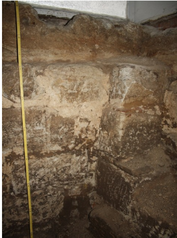
Abb. 10: Baufuge in der Südwest-Ecke von Raum 1 zwischen der Bermenmauer Bef. 23 (rechts) und der Außenmauer Bef. 9 (Foto: M. Sloan).
