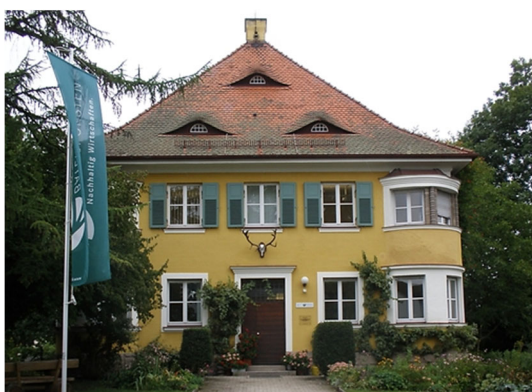
3 (oben links) Das Forstgebäude Kolpingstraße 7 im Jahr 2008.
