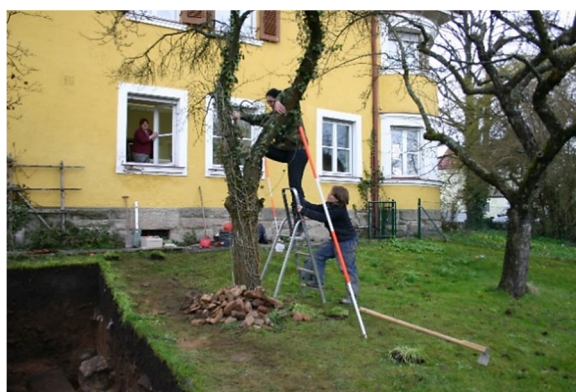
4 (oben rechts) Westseite, Gartenansicht während der Grabungsarbeiten im Jahr 2008.
