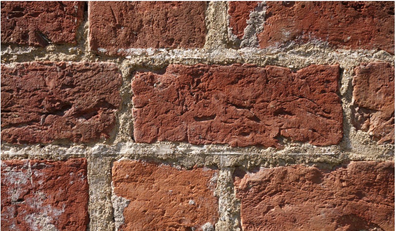
14 Kloster Chorin, Ostflügel von Osten, Detail des Ergänzungsmauerwerks von 1832, zweitverwendete mittelalterliche Backsteine, neue Verfugung und Farbfassung mit aufgemalten weißen Fugenstrichen, Aufnahme 2017.
