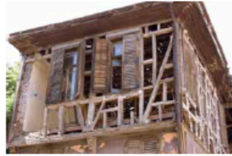
Abbildung 4: Vorbereitung zur Renovierung? (2006)
