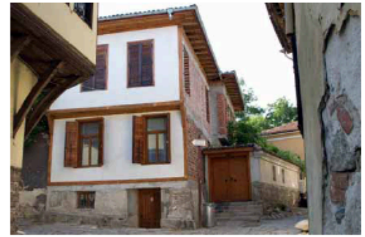
Abbildung 6: Haus fertig, fast ganz verputzt (2009)
