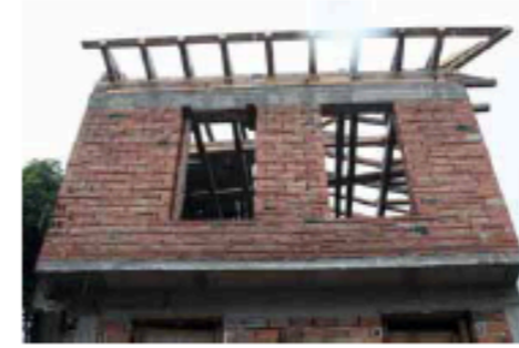
Abbildung 5: Neubau mit Beton und Ziegeln (2007)
