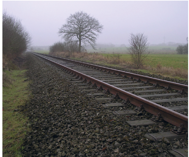
16 Sekundärnutzung neuzeitlicher Schlacken. 1) Bahndamm der Bahnlinie Sanem – Livange (oben); 2) Gleiskörper aus maschinell zerkleinerten Hochofenschlacken bei der Mine von Fond de Gras (unten). Aufnahmen Dez. 2005, bzw. März 2004.
