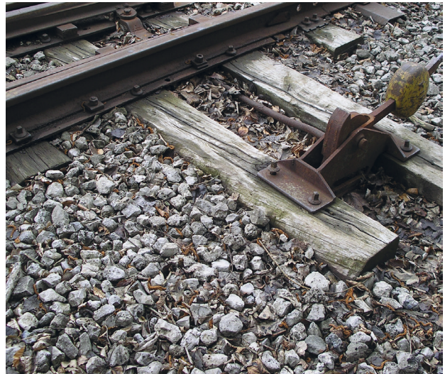
16 Sekundärnutzung neuzeitlicher Schlacken. 1) Bahndamm der Bahnlinie Sanem – Livange (oben); 2) Gleiskörper aus maschinell zerkleinerten Hochofenschlacken bei der Mine von Fond de Gras (unten). Aufnahmen Dez. 2005, bzw. März 2004.
