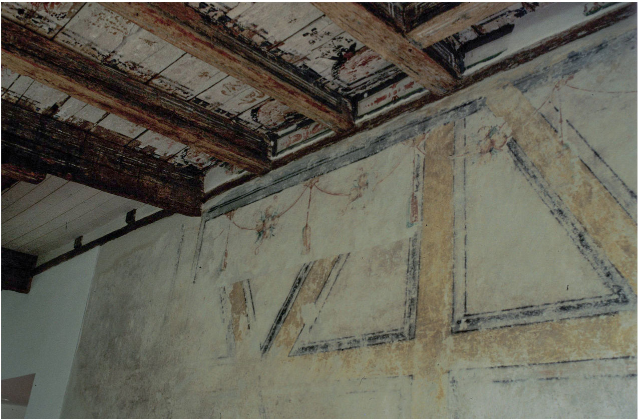
3 Überlagerte Geschichte: Im Foyer des Bürgerhauses liegt die gemalte Fachwerkfassung von 1575 unter einer barocken Neufassung von 1741 (Mundelsheim, Bürgerhaus).
