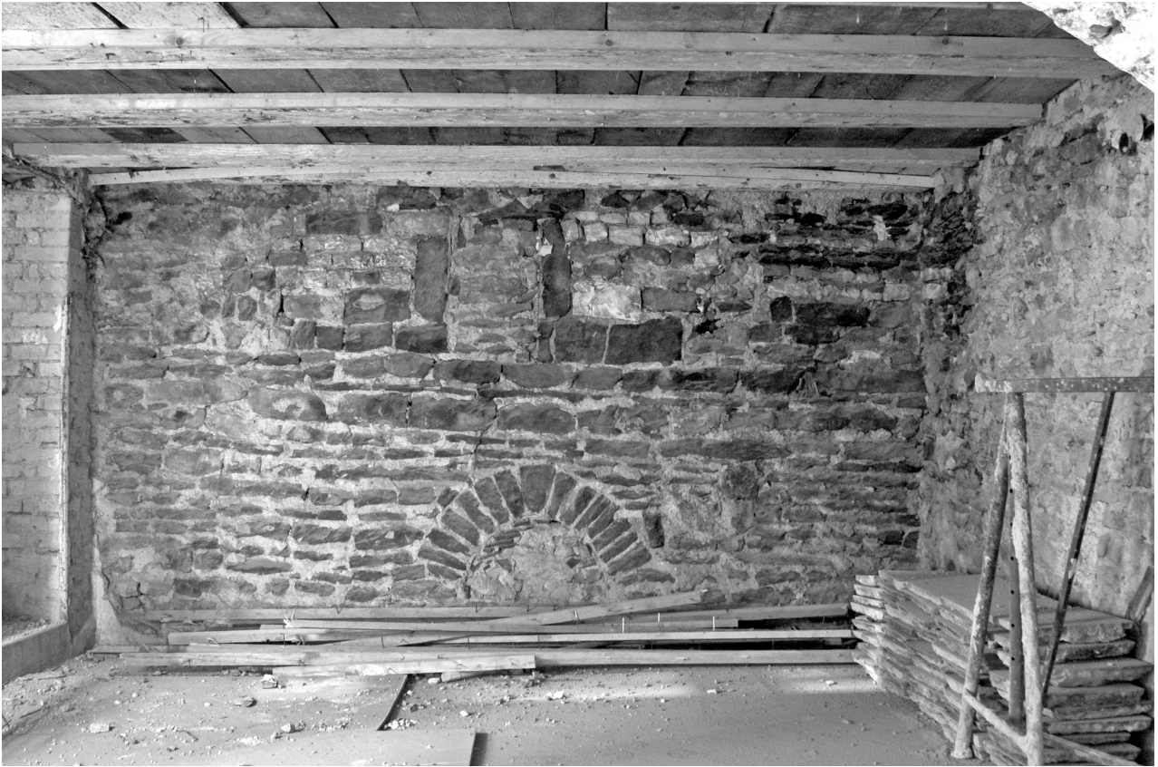
15 Regensburg, Goldene Bären Str. 10. Ostwand des 1. Obergeschosses im Bereich des rückwärtigen Anbaus an den Wohnbereich.
