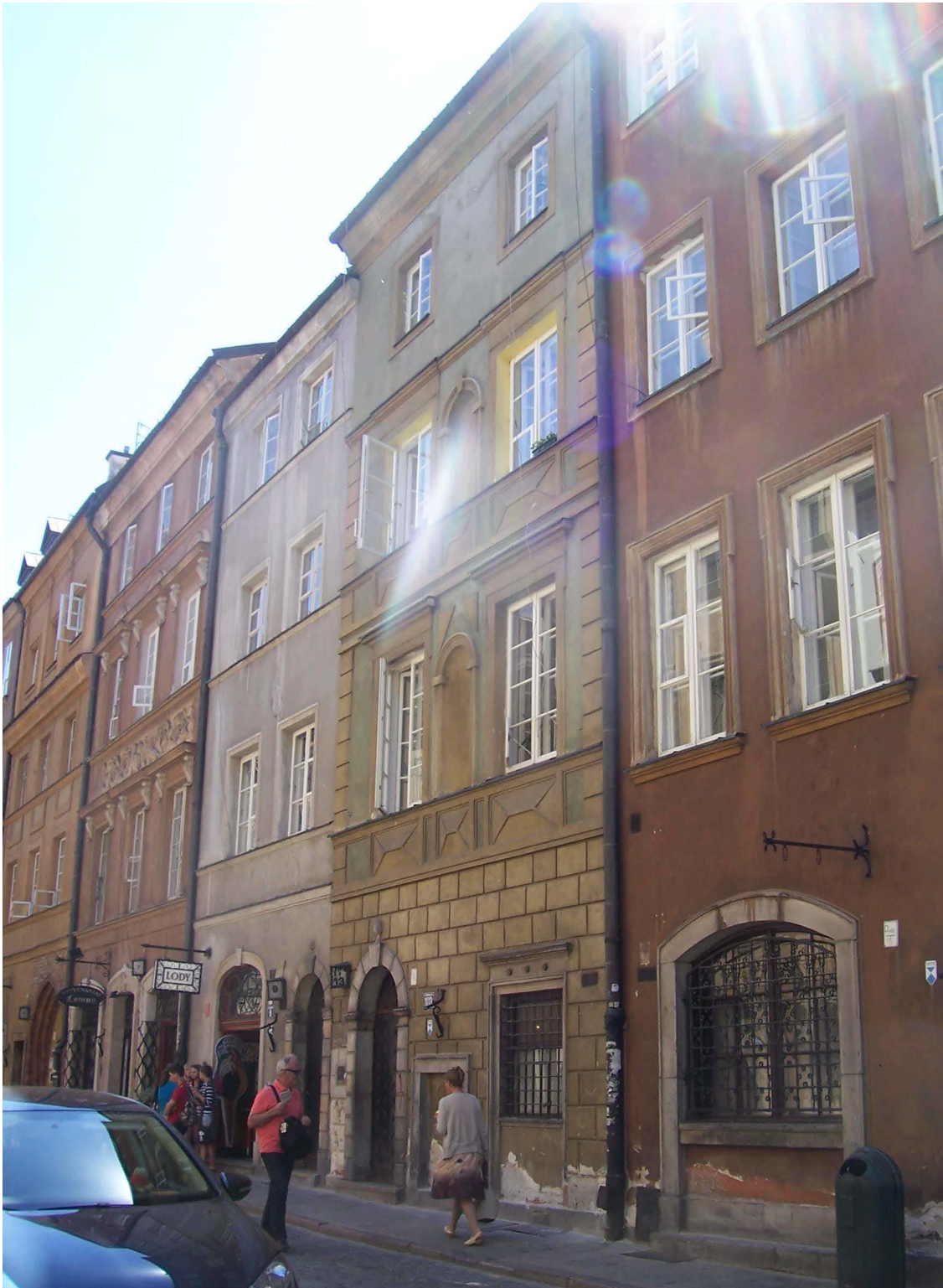
Abb. 636. Nowomiejska-Straße Nr. 11. Foto Verfasserin, 2012.
