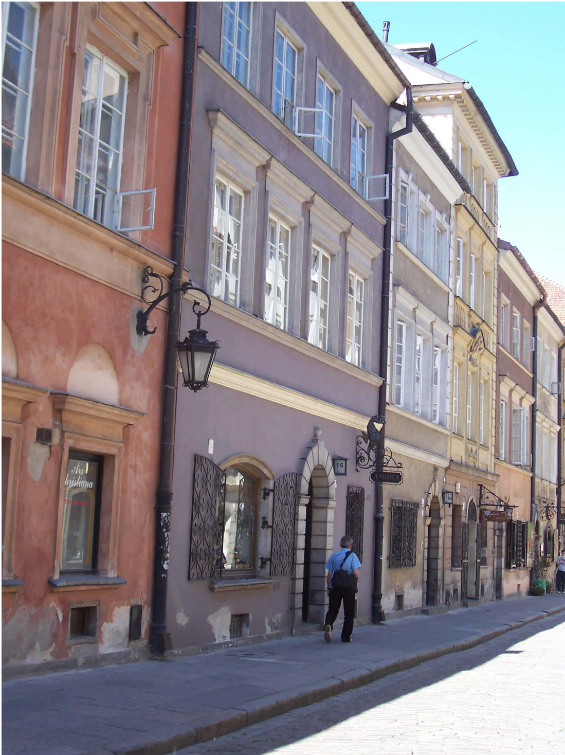
Abb. 750. Piwna-Straße Häuser Nr. 15, Nr. 17, Nr. 19, Nr. 21 und Nr. 23. Foto Verfasserin, 2012.
