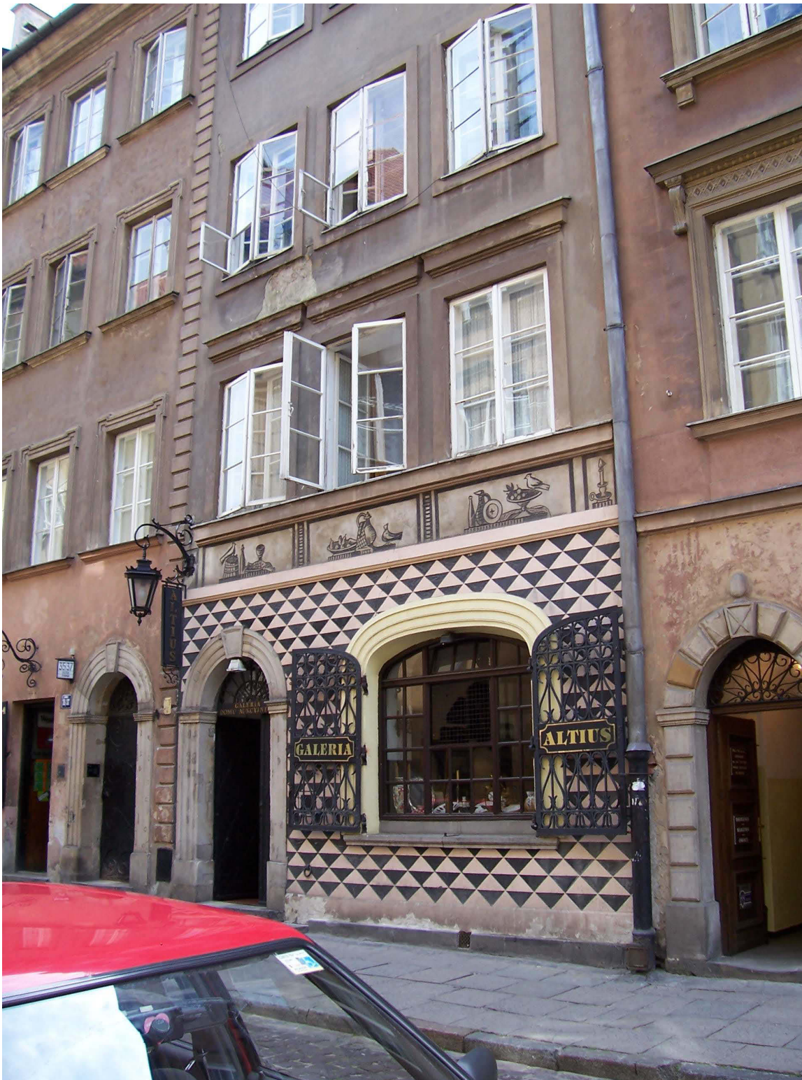
Abb. 777. Piwna-Straße Nr. 37. Links Nr. 35, rechts Fragment Nr. 39. Foto Verfasserin, 2006.
