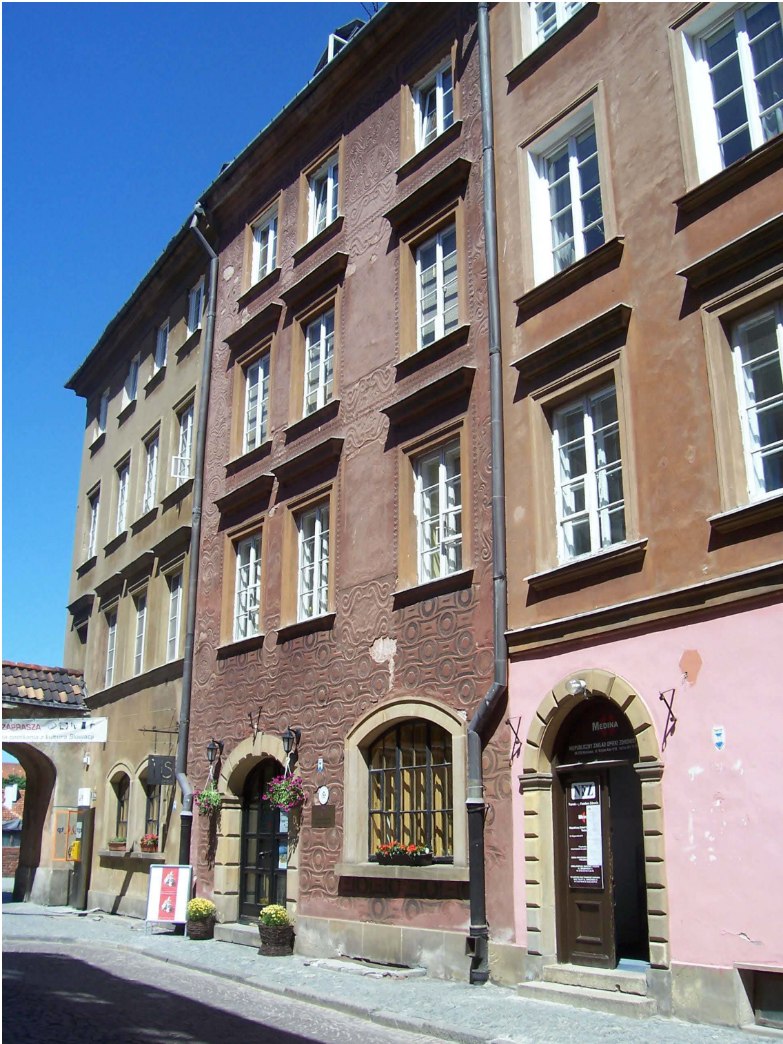
Abb. 725. Krzywe Koło-Straße Nr. 12. In der Mitte zwischen Fenstern wurde die Stelle markiert, wo sich bis 1944 die Nische mit der Muttergottes befand Foto Verfasserin, 2012.
