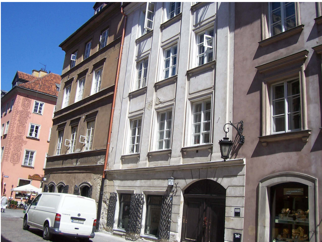
Abb. 798. Piwna-Straße. Von links Häuser Piwna-Straße Nr. 30, Nr. 28, Nr. 26 (Fragment). Foto Verfasserin, 2012.
