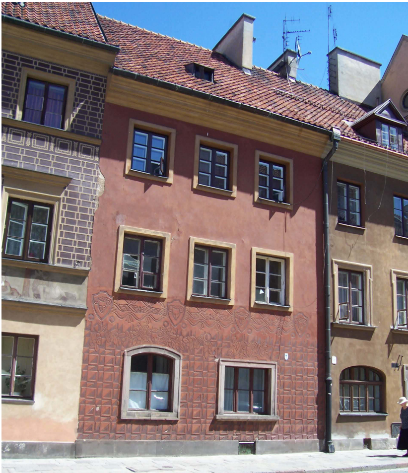
Abb. 838. Szeroki Dunaj-Straße Nr. 6. Foto Verfasserin, 2012.
