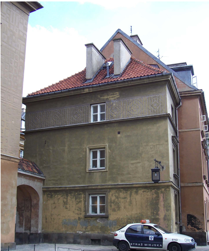
Abb. 730. Krzywe Koło-Straße Nr. 14A. Gesehen von der Seite der Wehrmauer. Weiter rechts Nr. 16, links – sichtbar die Ecke des Hauses Nr. 14. Foto Verfasserin, 2009.
