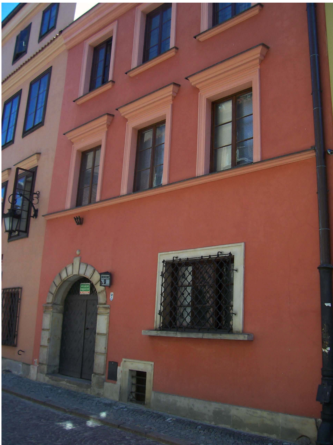
Abb. 708. Krzywe Koło-Straße Nr. 9. Foto Verfasserin, 2012.
