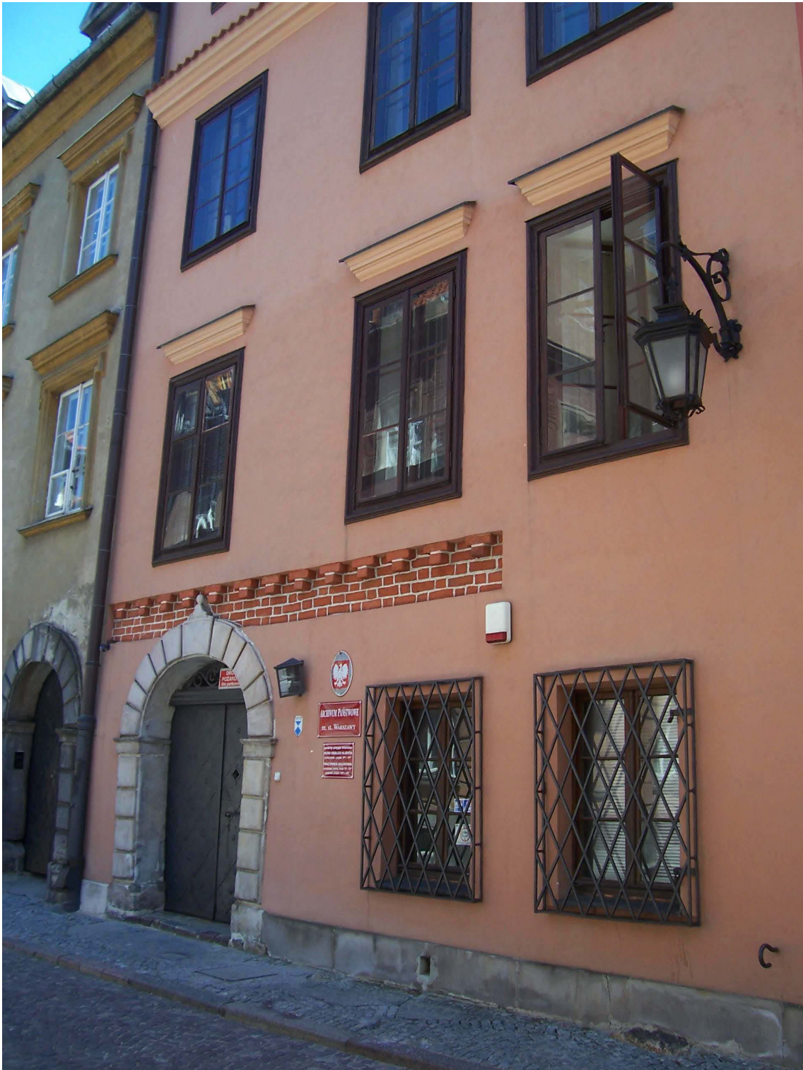
Abb. 701. Krzywe Koło-Straße Nr. 7. Foto Verfasserin, 2012
