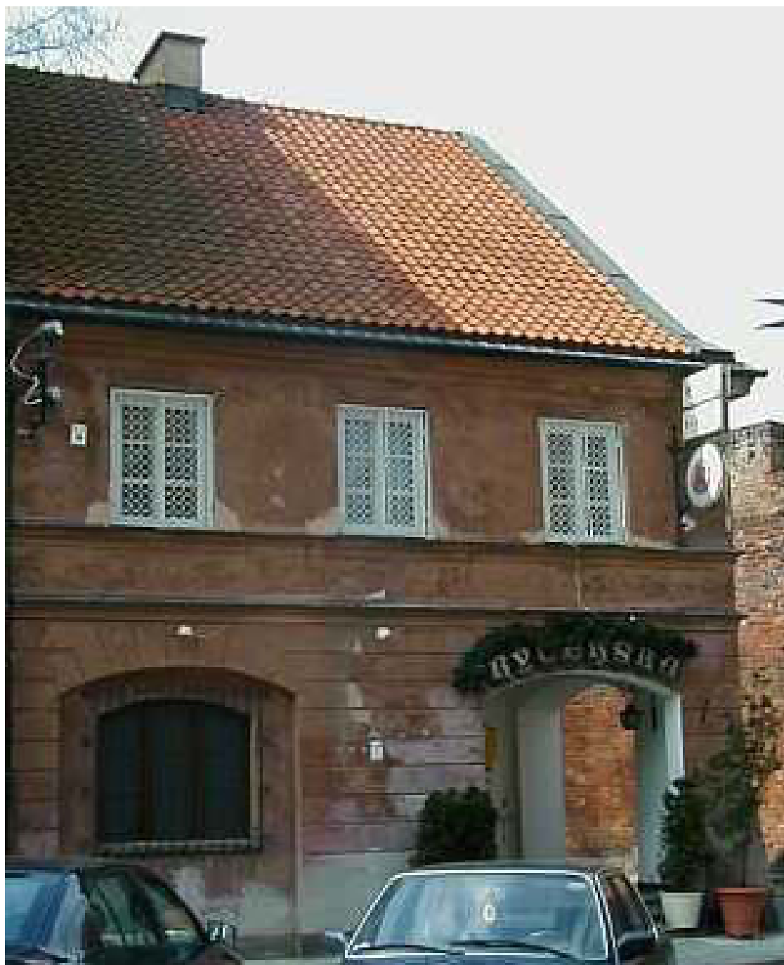
Abb. 827. Szeroki Dunaj-Straße Nr. 11. Foto Verfasserin, 2006.
