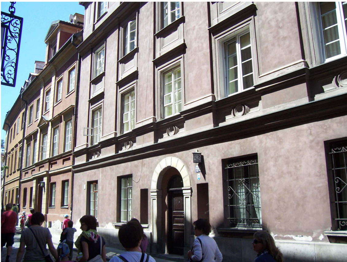
Abb. 867. Häuserzeile Wąski Dunaj. Vorne Haus Nr. 12. Das Portal erschließt Häuser Nr. 12/18. Foto Verfasserin, 2012.
