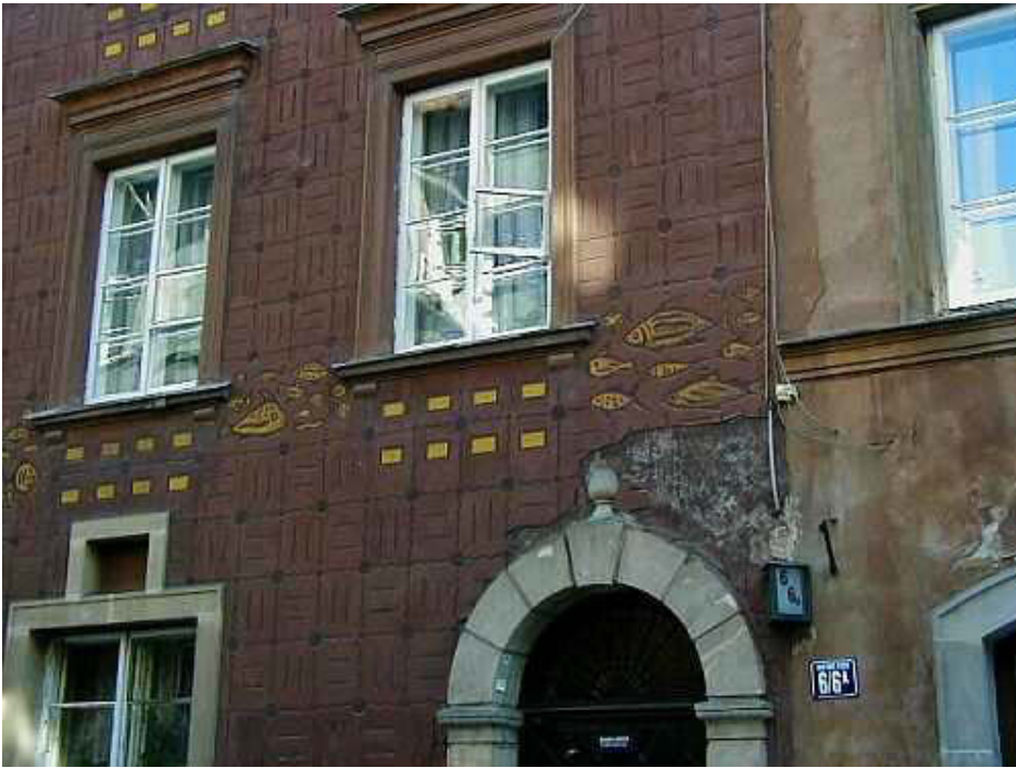
Abb. 718. Krzywe Koło-Straße Nr. 6. Portal erschließt Häuser Nr. 6 und Nr. 6A. Foto Verfasserin, 2012.
