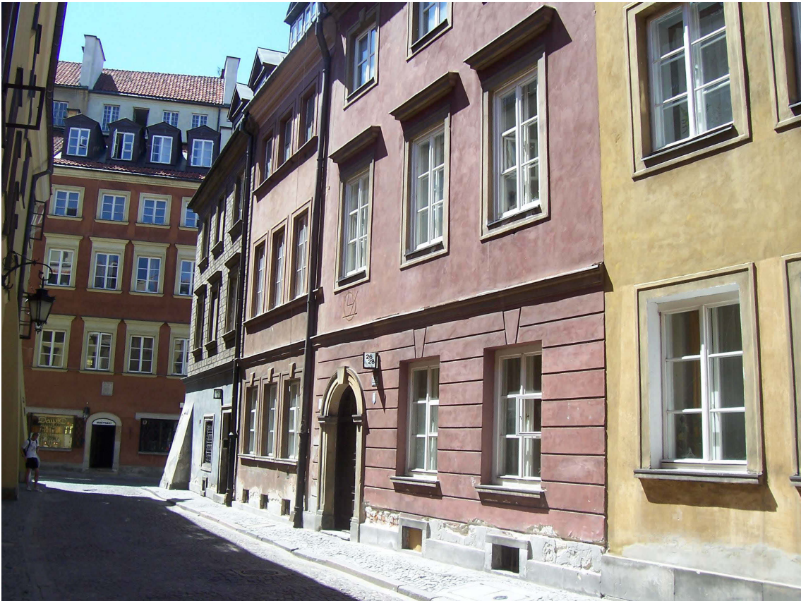
Abb. 735. Krzywe Koło-Straße. Von links Häuser Nr. 30/Nowomiejska 14, 28, 26, 24 (Fr.). Foto Verfasserin, 2012.
