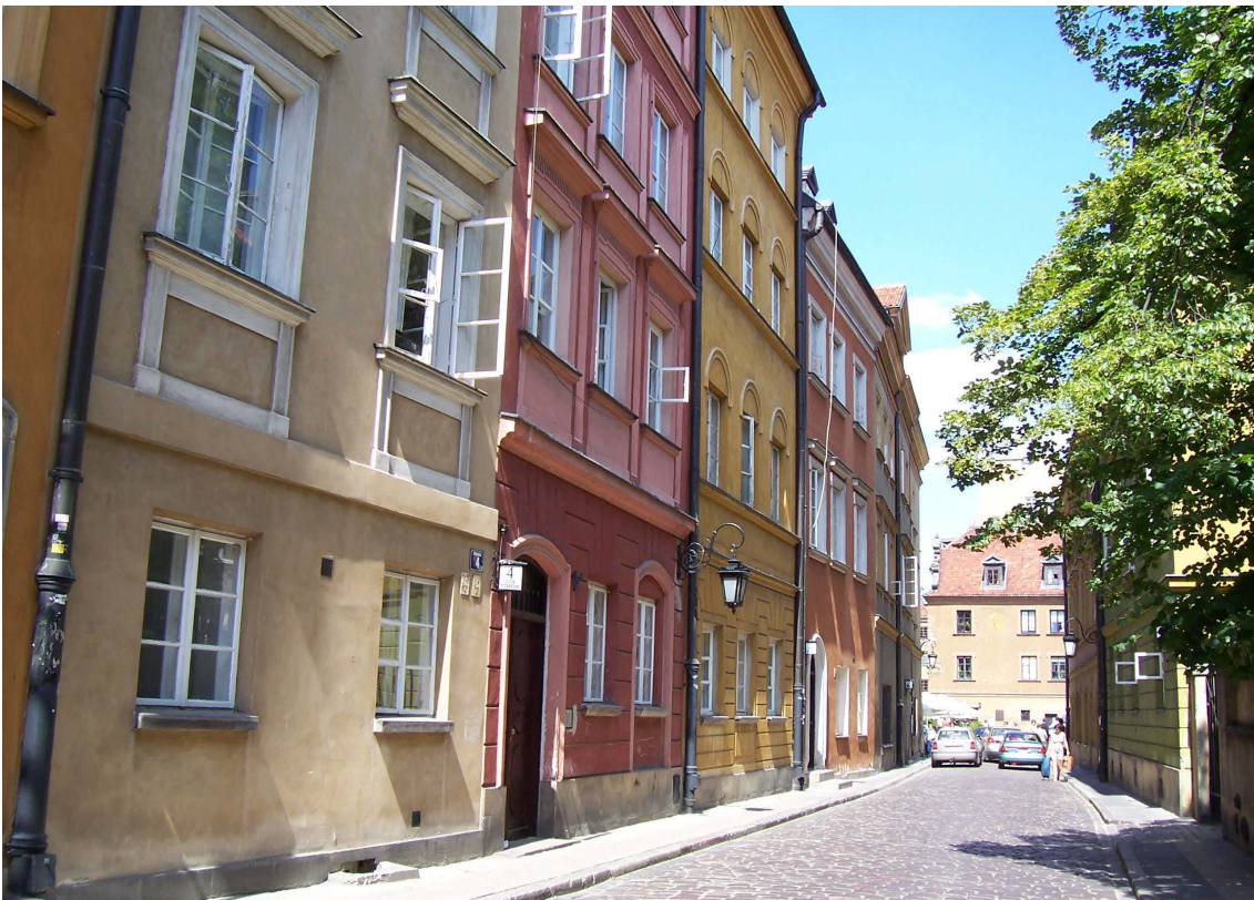
Abb. 873. Piekarska-Straße Nr. 4. Foto Verfasserin, 2009.
