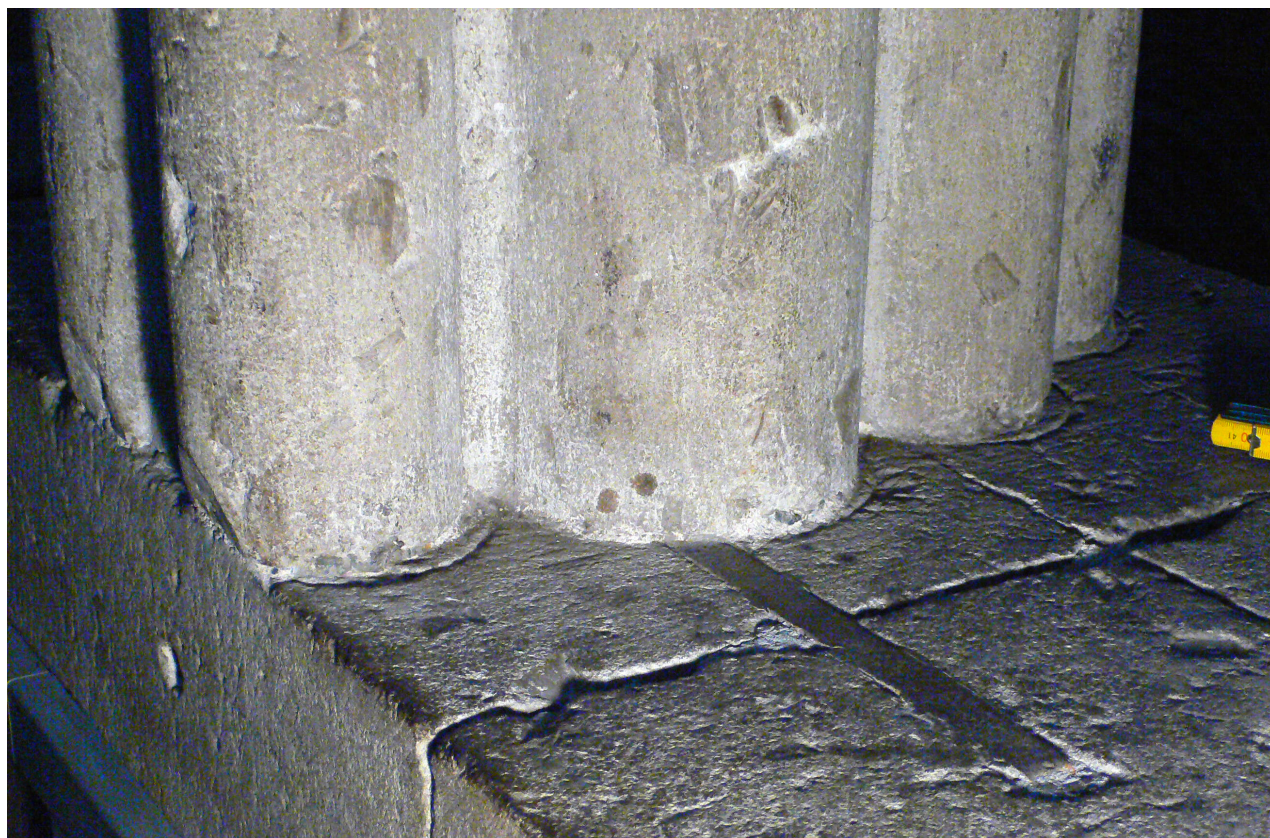
Abb. 9 Köln, Dom, Maßwerkstab auf der Brüstung des Triforiums, angerissener Umriss
