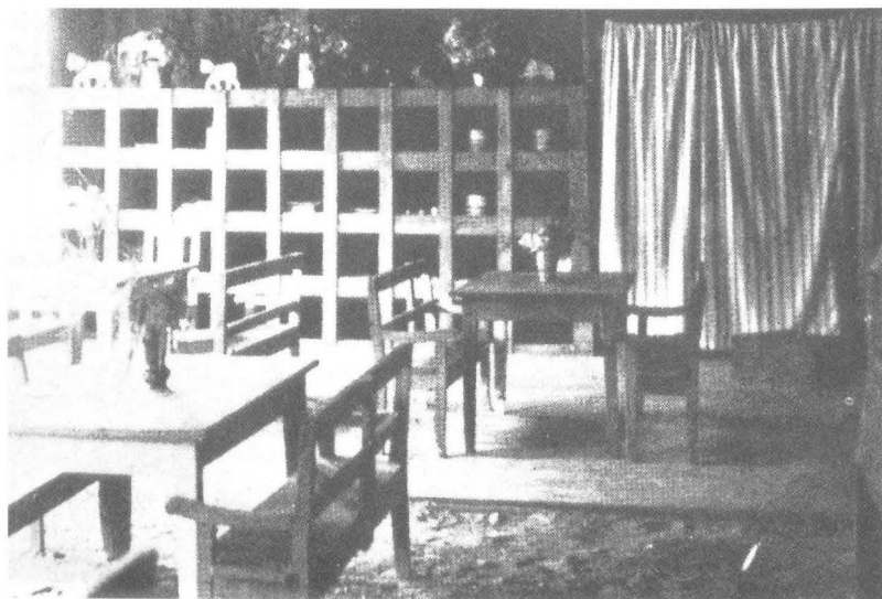
Abb. 162: Notkindergarten in Unterwirrbach/Saalfeld; um 1930. In einem früheren Hühnerstall ist Platz für einen Kindergarten geschaffen worden. Die Gestelle für Hühnerester an der Wand dienen jetzt als Spielzeugregal, teilweise ist der Boden noch aus gestampftem Lehm.
