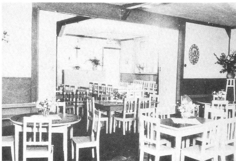
Abb. 239: Innenansicht eines neugebauten Kindergartens in Heimersheim; in den 50er Jahren. Durch Schiebetüren können zwei Gruppenräume zu einem großen Saal geöffnet werden. Leicht bewegliche Tische für Kleingruppen mit einzelnen Stühlen füllen den Raum aus.
