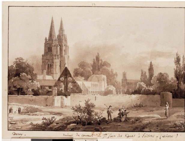
47 Isidore-Laurent Deroy: Die Ruinen des Konvents von Saint-Jean-des-Vignes in Soisson (Oise), 1823.
