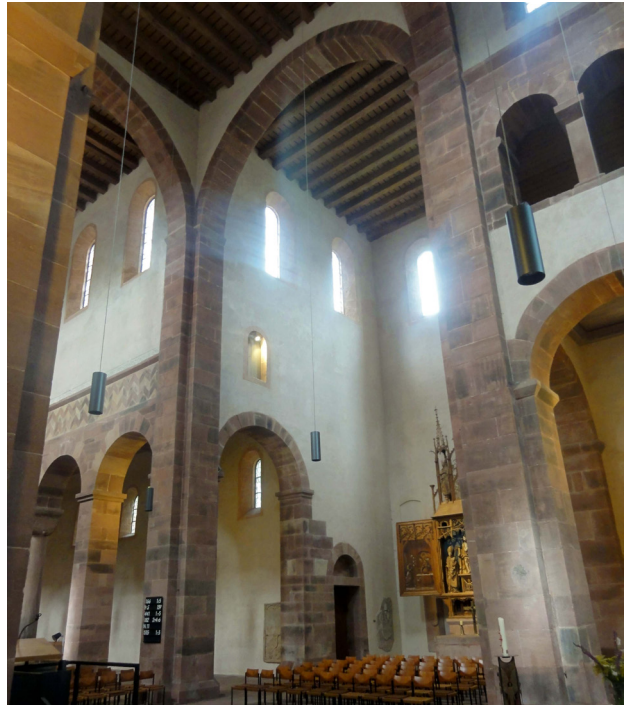
30 Alpirsbach, ehemalige Benediktiner-Abteikirche. Innenraum, Blick durch die Vierung nach Nordwesten, heutiger Zustand.
