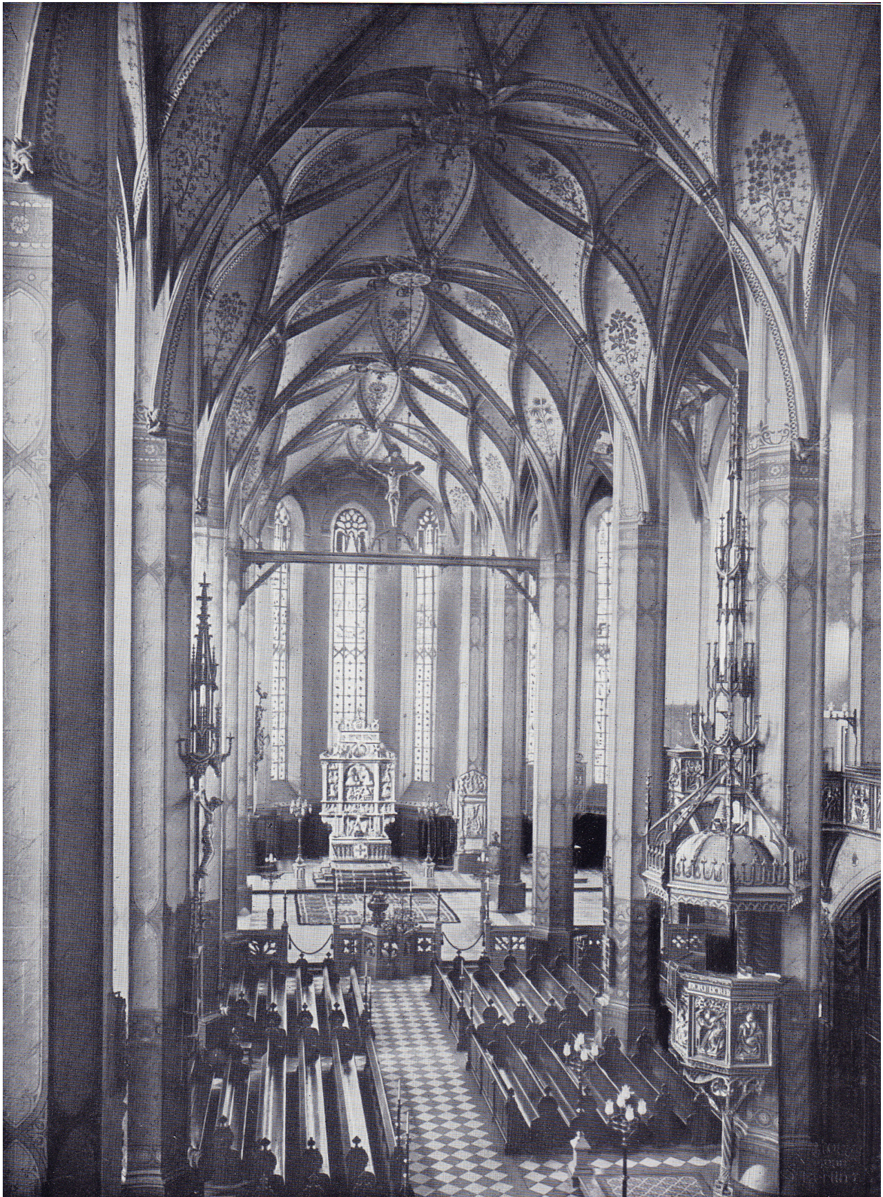
50 Annaberg-Buchholz, Pfarrkirche. Innenraum nach Osten, mit der Ausstattung von 1875/84.
