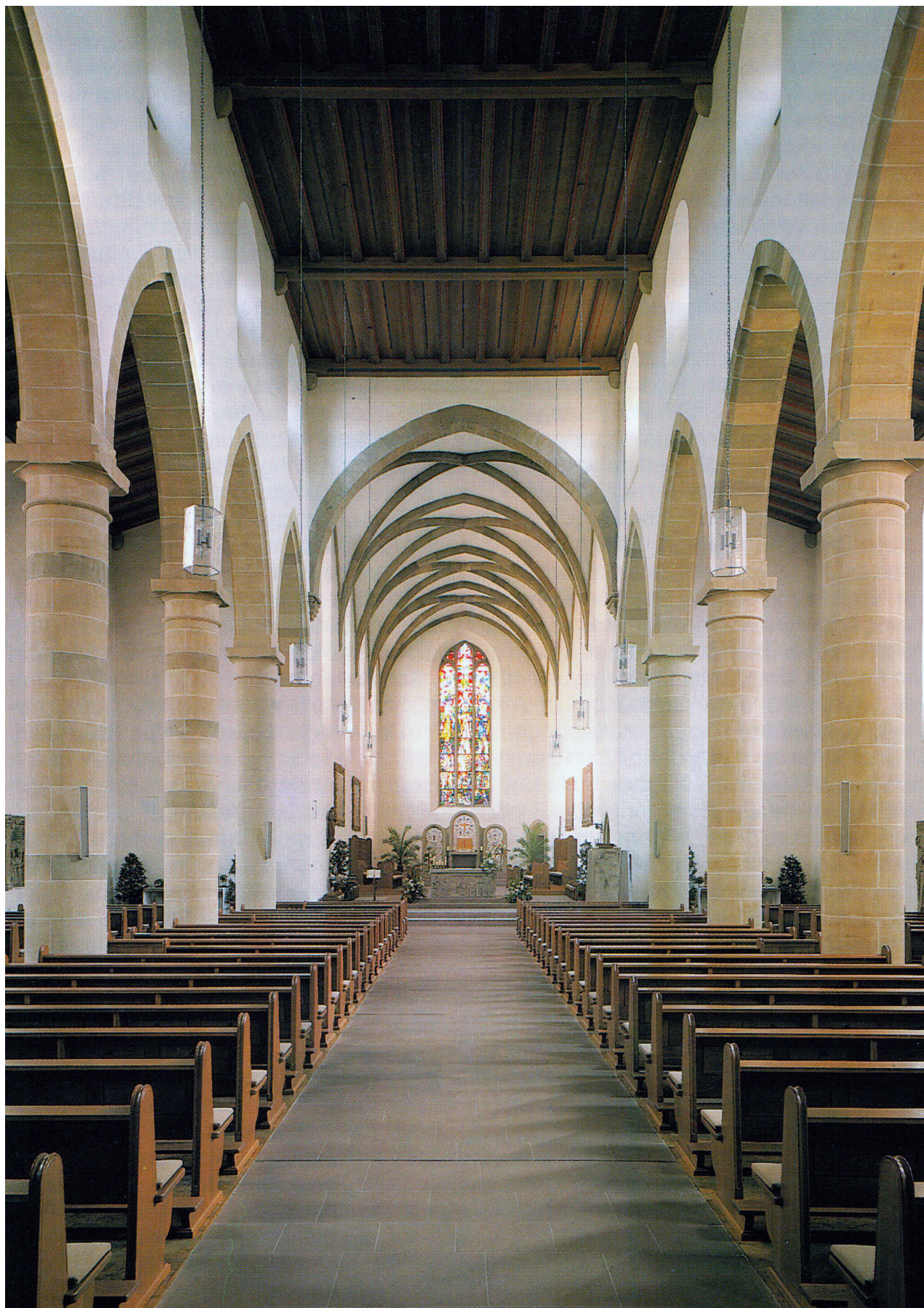
70 Würzburg, Franziskanerklosterkirche. Innenraum nach Osten, nach dem weitgehenden Um- und Rückbau 1988, heutiger Zustand.
