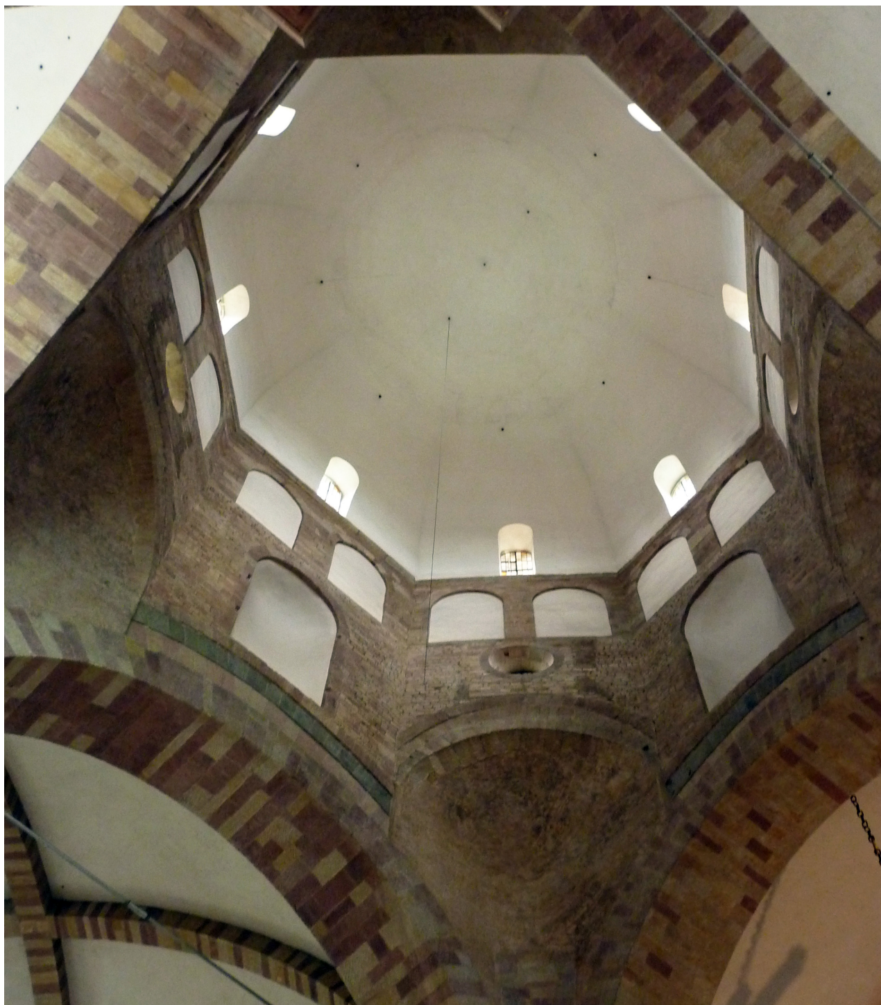
41 Speyer, Dom. Blick in die Vierungskuppel, heutiger Zustand.
