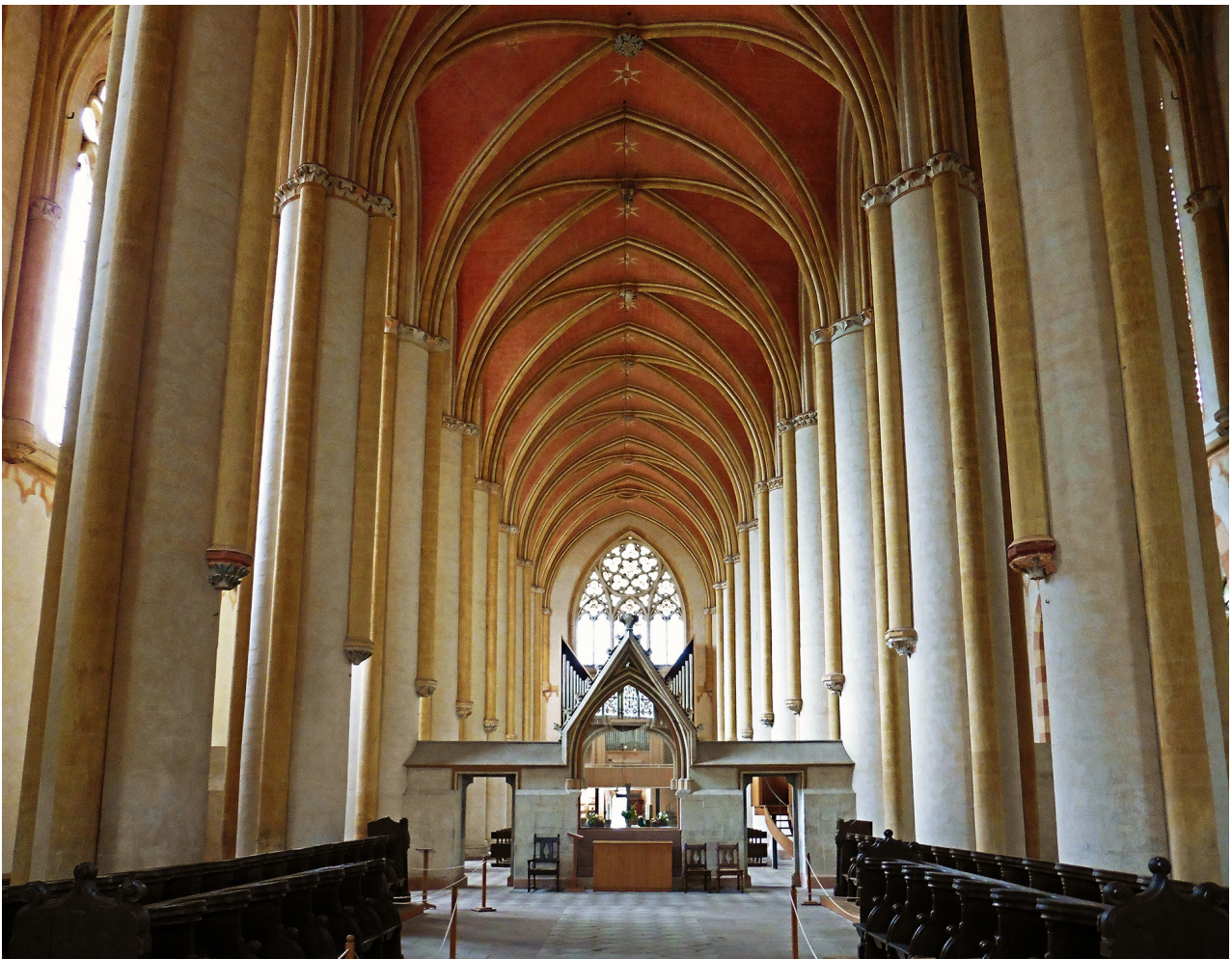
23 Haina, ehemalige Zisterzienser-Abteikirche St. Maria. Innenraum nach Osten, heutiger Zustand.
