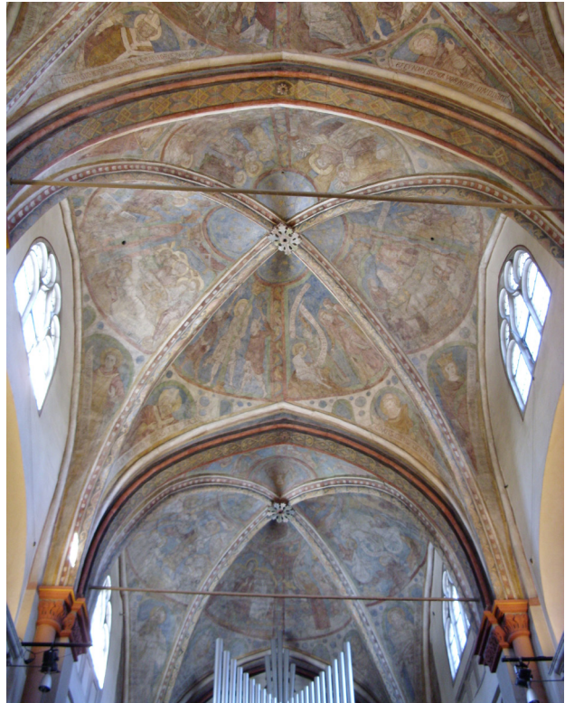
57 Köln, Pfarrkirche St. Maria Lyskirchen. Blick zu den Mittelschiffgewölben nach Westen, heutiger Zustand.
