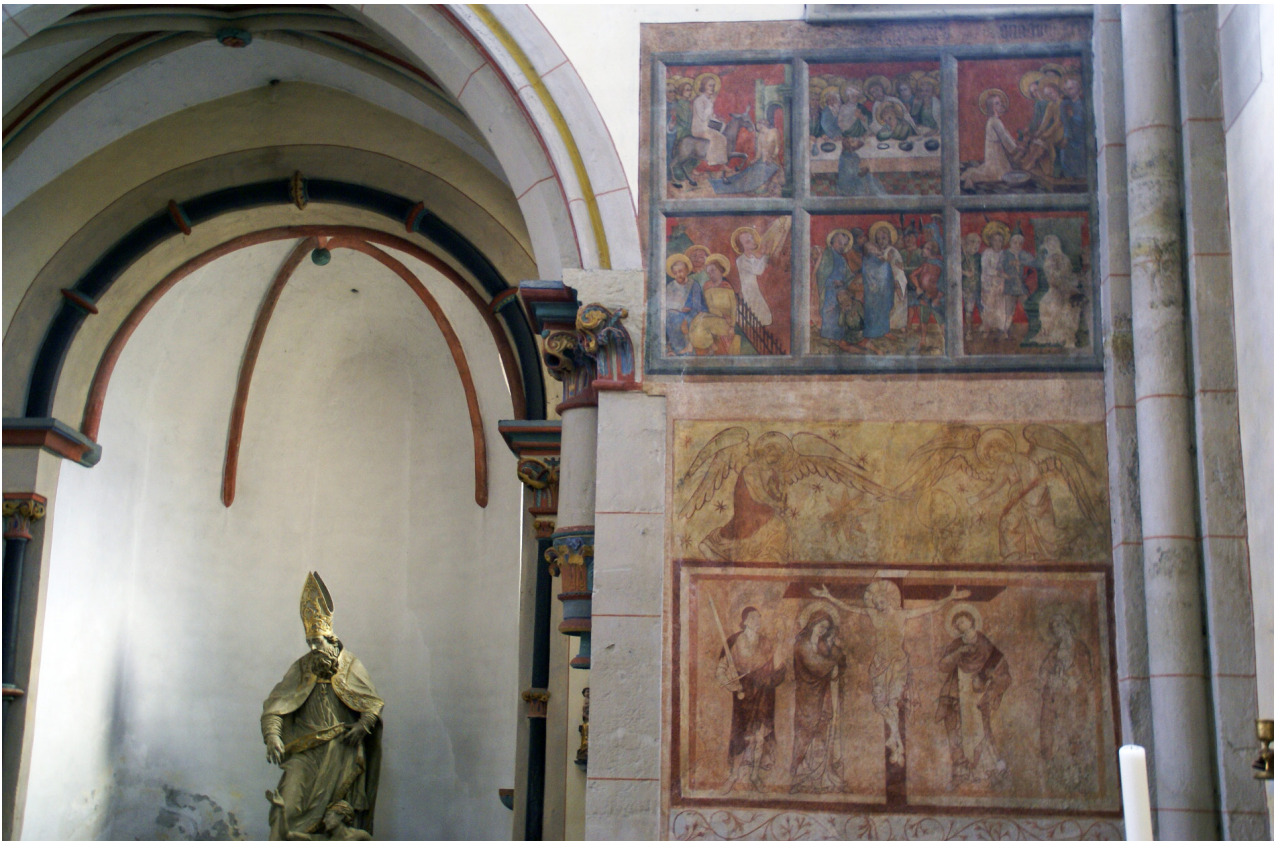
59 Münstermaifeld, ehemalige Stiftskirche. Freigelegte Wandmalereien und Architekturfassungen in Querhaus und Chor, heutiger Zustand.
