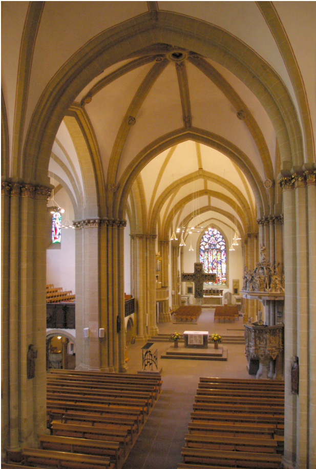
33 Herford, ehemalige Damenstiftskirche St. Marien und Pusinna. Innenraum nach Osten, heutiger Zustand.
