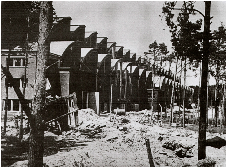
Abb. 37 Aufnahme der Fertigungshalle 1 von Südwesten, aufgenommen nach einem der Luftangriffe der USAAF im Sommer.1944 (Aufnahme HVA, DM, Archiv, Bild Nr. 260)
