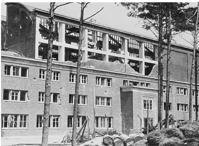
Abb. 38 Aufnahme der Fertigungshalle 1 von Westen, aufgenommen nach einem der Luftangriffe der USAAF im Sommer.1944 (Aufnahme HVA, DM, Archiv Bild CD 52936 / FA01/B259/43a)
