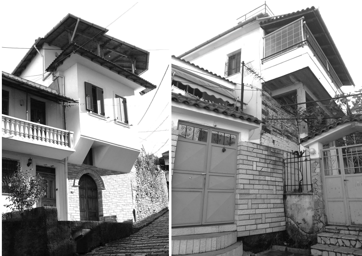
Abb. 64 & 65: Als authentisch eingestufte Gebäudetransformationen mit typischen Elementen (Fassadengestaltung mit Ziersteinen, Verputzen, Anbau von Balkon/Dachterasse, Dachumbau, Eingangstor)
