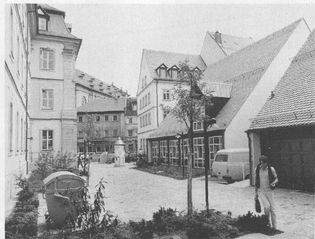
Abb. 14 Sog. Haus zum Schwan, Austrasse 37. Blick von Westen auf die Rückfront und die Rückgebäude mit der Mensa
