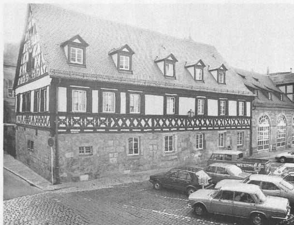
Abb. 24 Burgershof. Blick von Nordosten auf das ehem. Haus des Stadtphysikus
