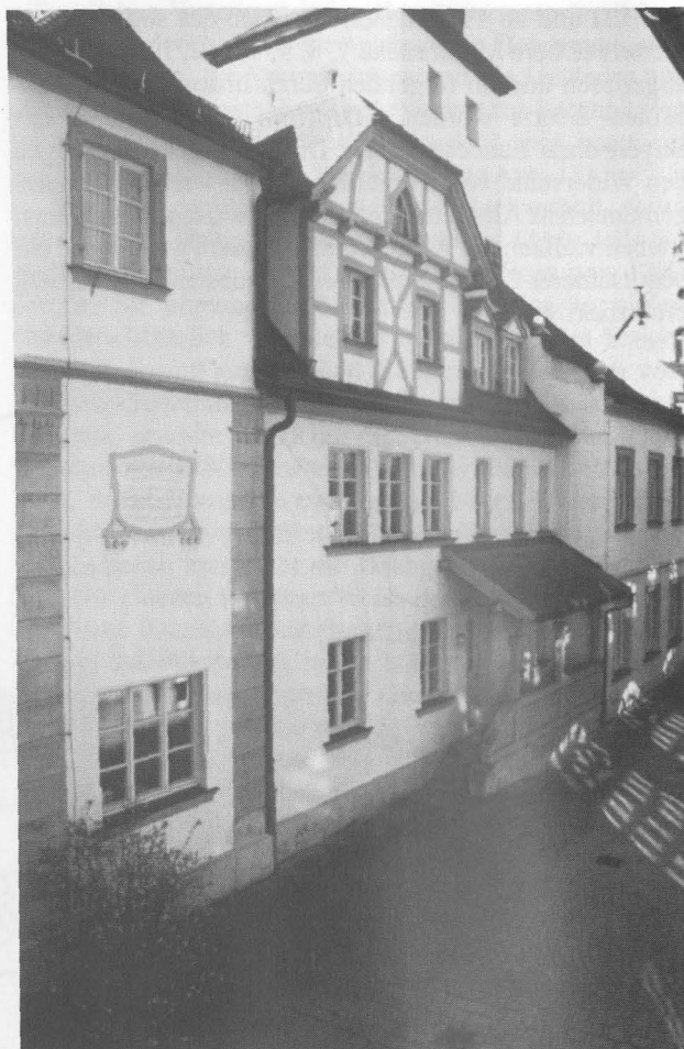
Abb. 21 Burgershof. Blick von Nordosten auf den Stadtturm und seine Anbauten, mit der Fassadengestaltung durch Hans Jakob Erlwein
