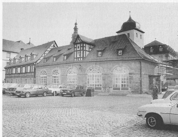
Abb. 23 Burgershof. Blick von Nordwesten auf die ehem. Feuerwehrrhalle
