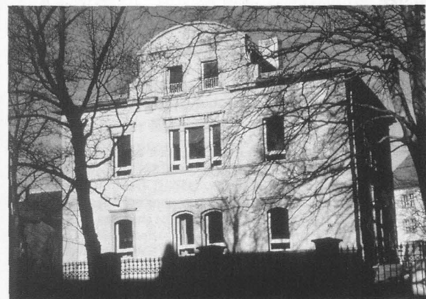
Abb. 44 Gebäudekomplex Marcus-Haus. Blick von Osten auf das ehem. Wohnhaus des Klinikdirektors (Markusstraße 6). Fassade 1854/55, 1908 umgestaltet
