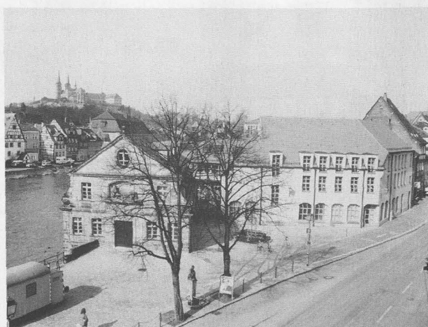
Abb. 30 Ehem. Schlachthaus und Bibliotheksgebäude. Blick von Süden, nach dem Umbau
