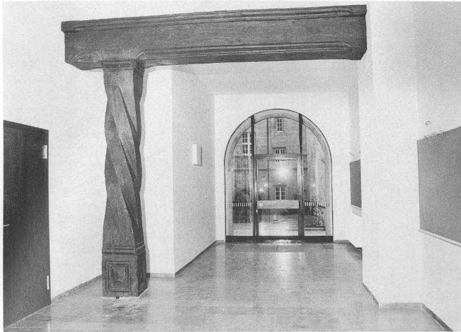
Abb. 6 Sog. Hochzeitshaus. Rückgebäude, Eingangshalle im Erdgeschoß, mit Stütze und Unterzug vom Vorgängerbau
