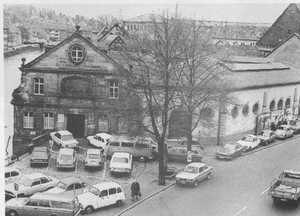
Abb. 29 Ehem. Schlachthaus und Fleischverkaufshalle. Blick von Süden, Zustand vor dem Umbau
