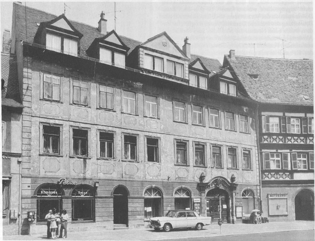
Abb. 15 Gebäude Kapuzinerstraße 16 (Universitätsleitung). Fassade vor dem Abbruch (Foto 1974)
