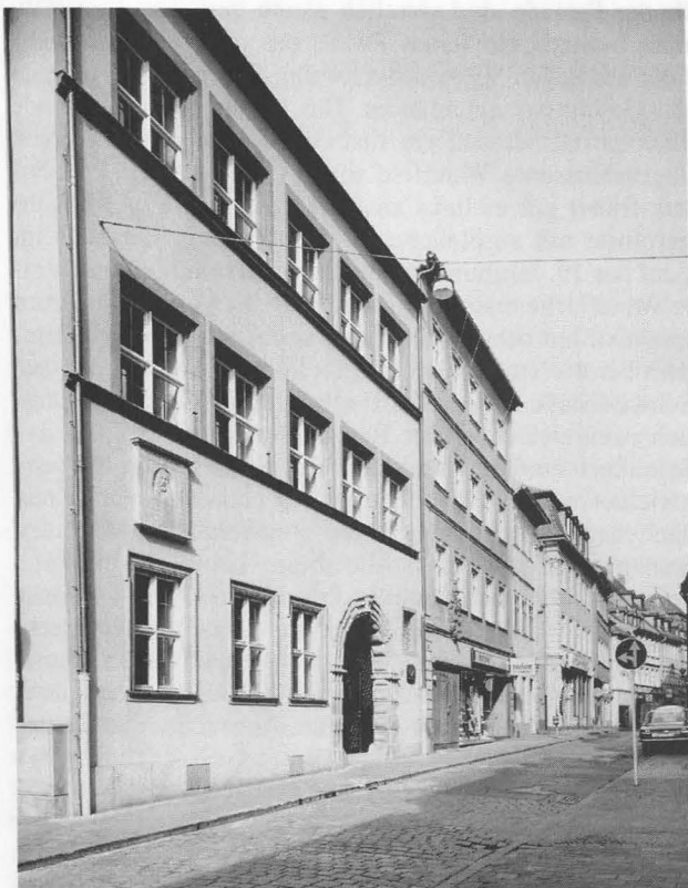
Abb. 3 Sog. Hochzeitshaus. Fassade des Rückgebäudes (links) an der Austrasse
