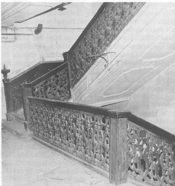
Abb. 17 Gebäude Kapuzinerstraße 16. Barockes Treppenhaus (um 1730/40), im ehemaligen südlichen Haus, 1. Obergeschoß (Foto 1978)
