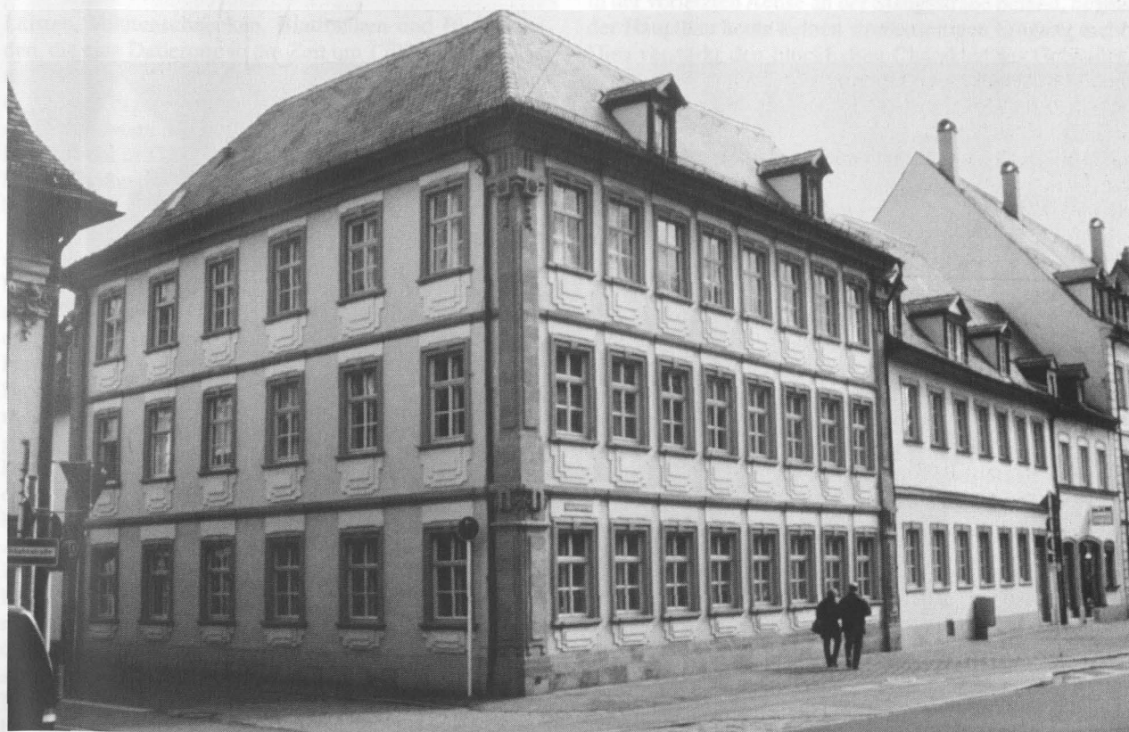
Abb. 31 Gebäude Kapuzinerstraße 20 und 22. Blick von Nordwesten
