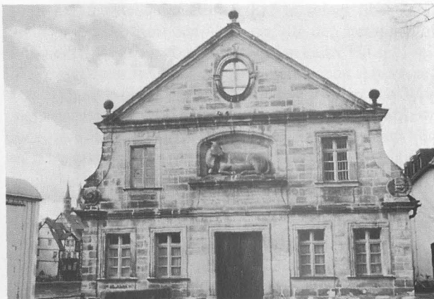
Abb. 28 Ehem. Schlachthaus. Südfassade, mit Figur eines Ochsen von Johann Adam Nickel, 1742
