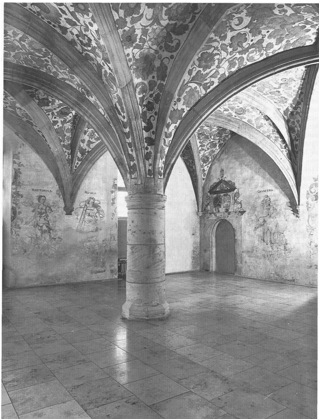
1. Der «Renaissancesaal» des Schlosses Geyerswörth nach Abschluß der Restaurierung von 1981–1984; Blick auf die straßenseitige Südwestwand mit «Rhetorica» und «Musica» und auf die an das Treppenhaus grenzende Nordwestwand mit «Geometria» neben dem vormaligen Zugang zum Keller. In der gemalten Portalarchitektur das Allianzwappen des Hochstifts Bamberg und des Fürstbischofs Ernst von Mengersdorf
